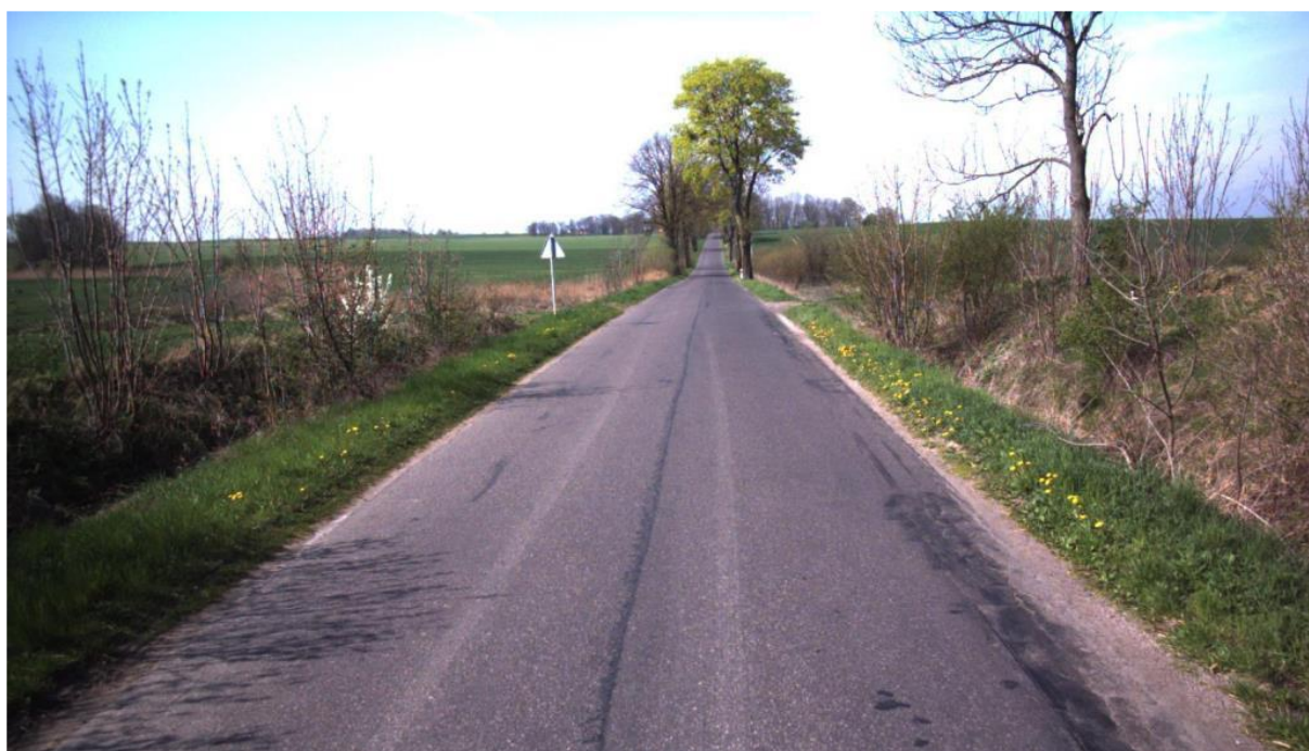
Rys. 7.1.3.6. Poziom decyzyjny ostrzegawczy: łąty o powierzchni LIW do 60 m 2 / sekcja 100 m [4]
