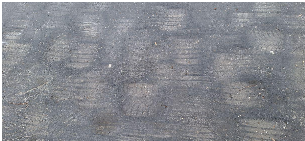
Rys. 7.1.1.3. Widok deformacji trwałych – odcisków
