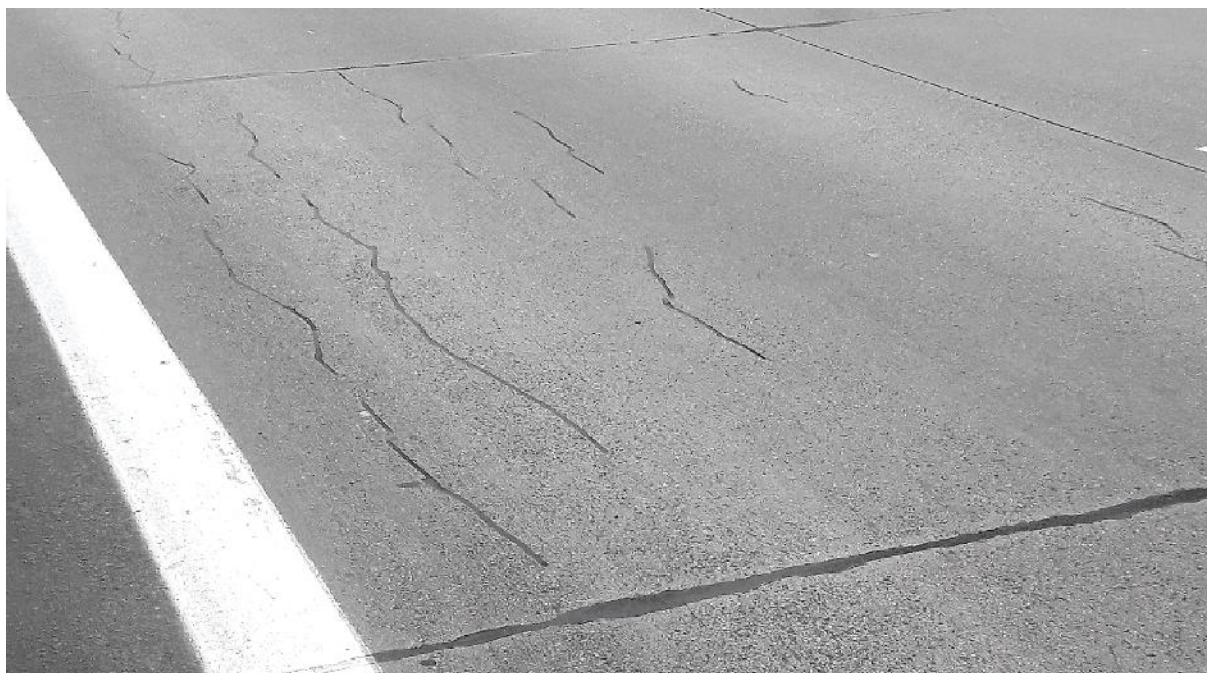
Rys. 7.2.2.2. Widok krótkich spękań podłużnych
