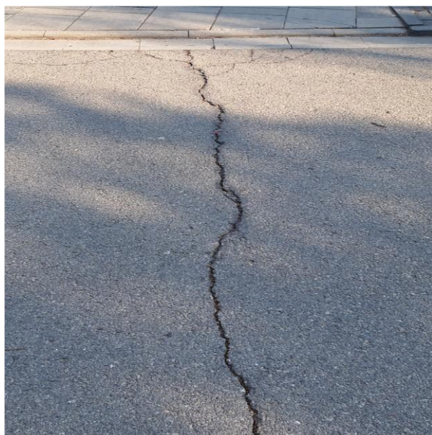
Rys. 7.1.2.9. Widok spękania termicznego pojedynczego poprzecznego
