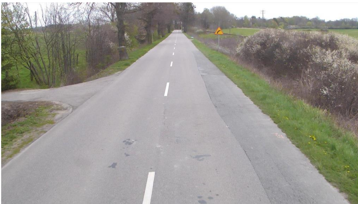
Rys. 7.1.3.4. Poziom decyzyjny ostrzegawczy: łaty o powierzchni LIW do 60 m 2 / sekcja 100 m [4]
