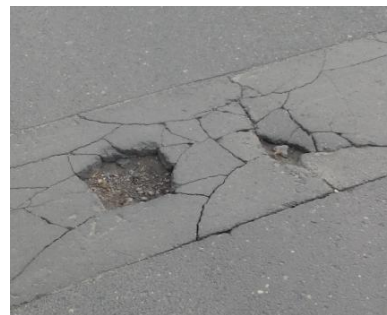
Rys. 7.1.3.3. Przykłady ubytków mieszanki mineralno-asfaltowej (zdjęcie z lewej i środkowe) oraz wybojów (zdjęcie z prawej) [4]
