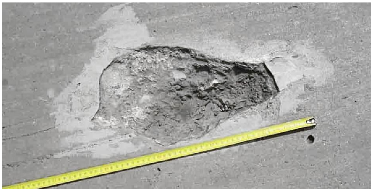
Rys. 7.2.4.1. Widok wyboju
