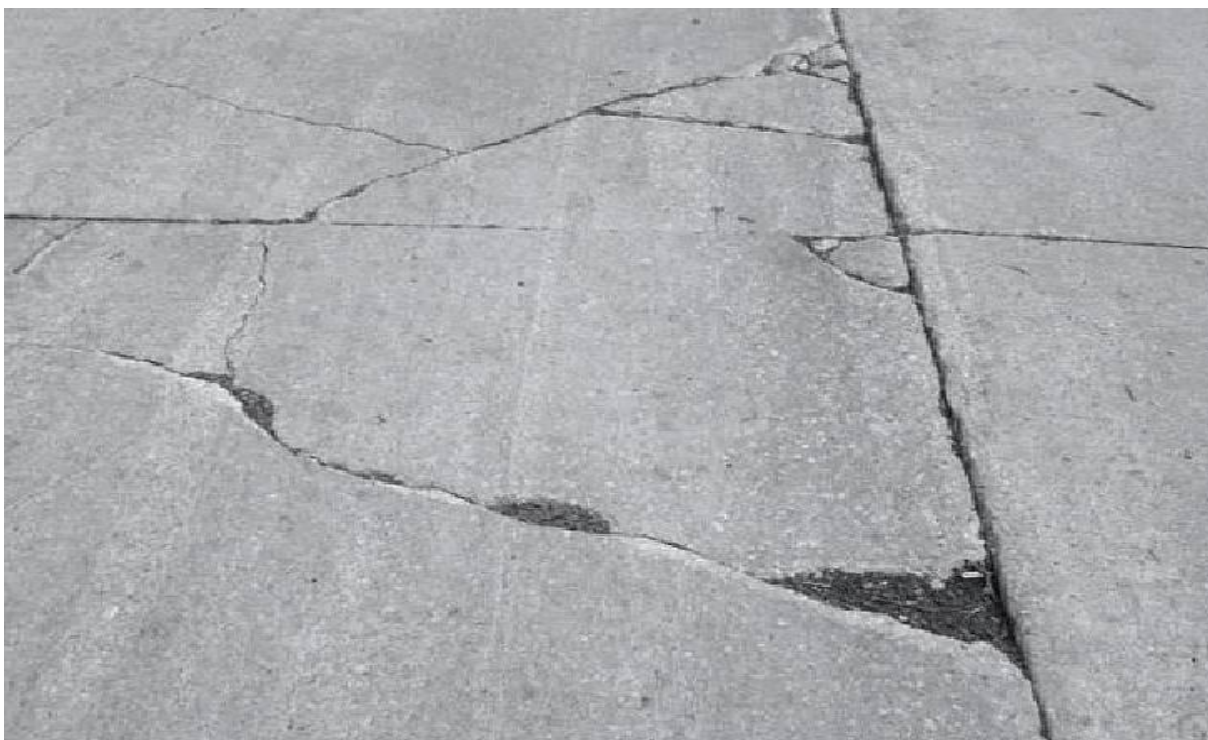
Rys. 7.2.2.10. Widok spękań blokowych w obszarze naroża
