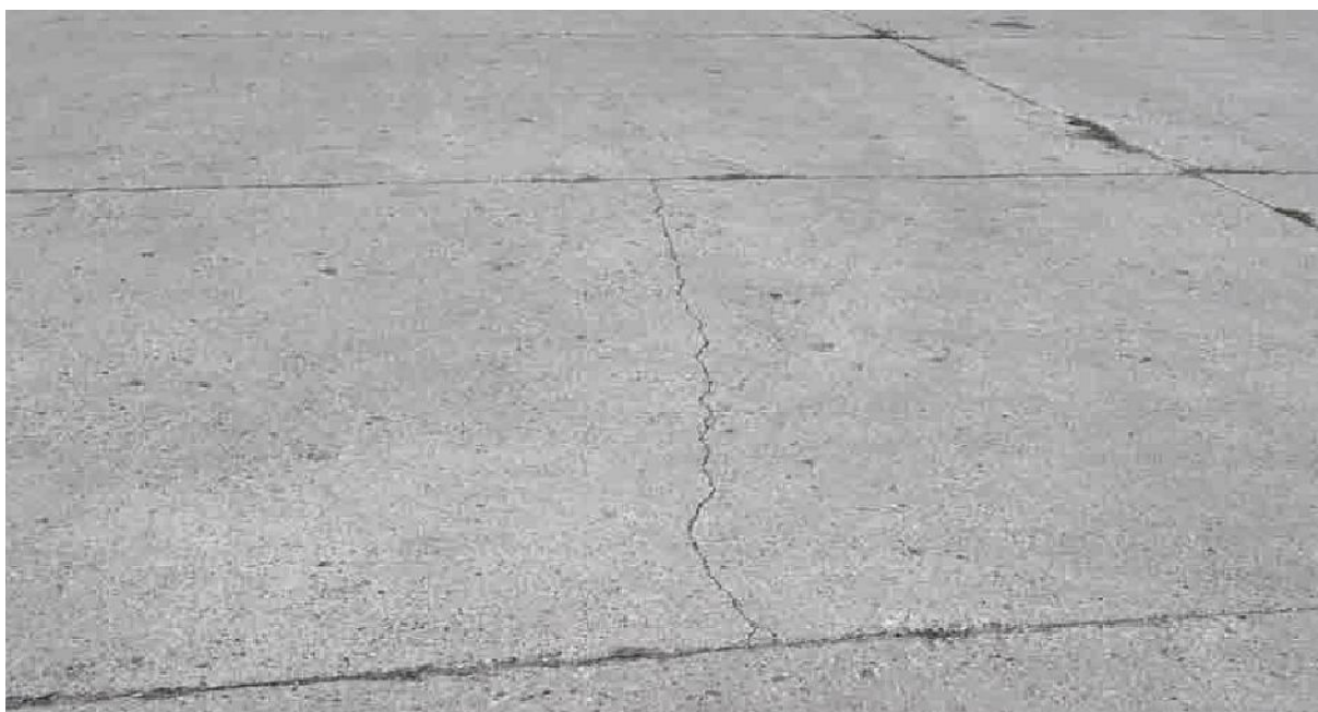
Rys. 7.2.2.4. Widok spękania poprzecznego
