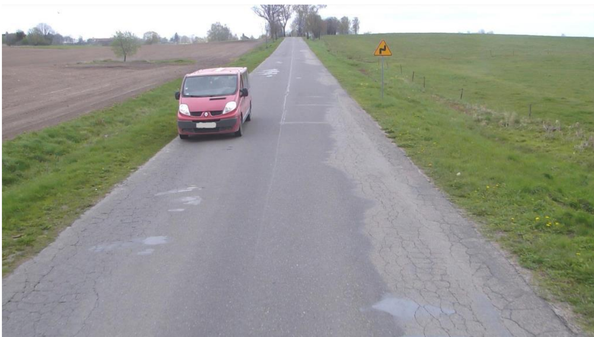
Rys. 7.1.2.3. Poziom decyzyjny ostrzegawczy: spękania siatkowe o powierzchni SPO do 45 m 2 / sekcję 100 m [4]
