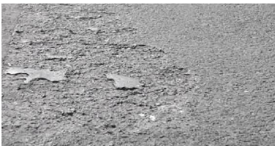
Rys. 7.2.4.4. Widok złuszczeń
