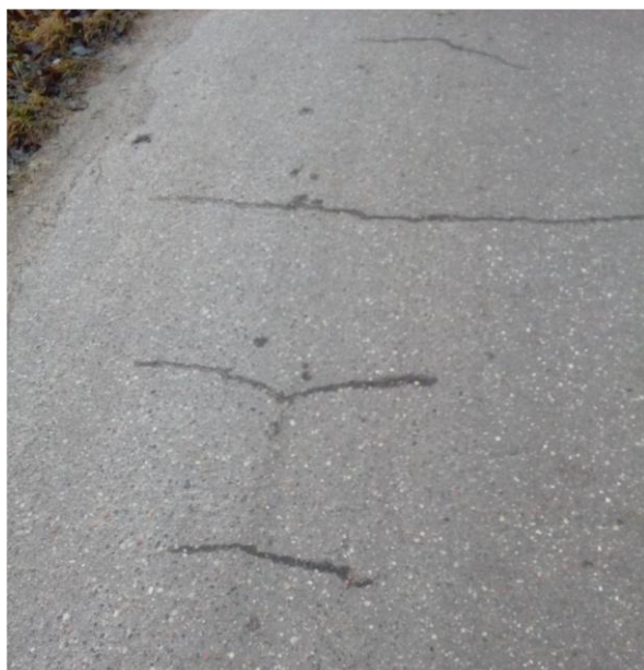
Rys. 7.1.2.8. Schemat spękań termicznych pojedynczych poprzecznych [4]
