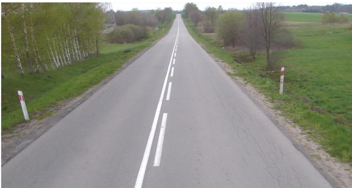
Rys. 7.1.2.2. Poziom decyzyjny ostrzegawczy: spękania siatkowe o powierzchni SPO do 45 m 2 / sekcję 100 m [4]
