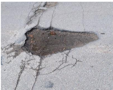
Rys. 7.1.3.3. Przykłady ubytków mieszanki mineralno-asfaltowej (zdjęcie z lewej i środkowe) oraz wybojów (zdjęcie z prawej) [4]
