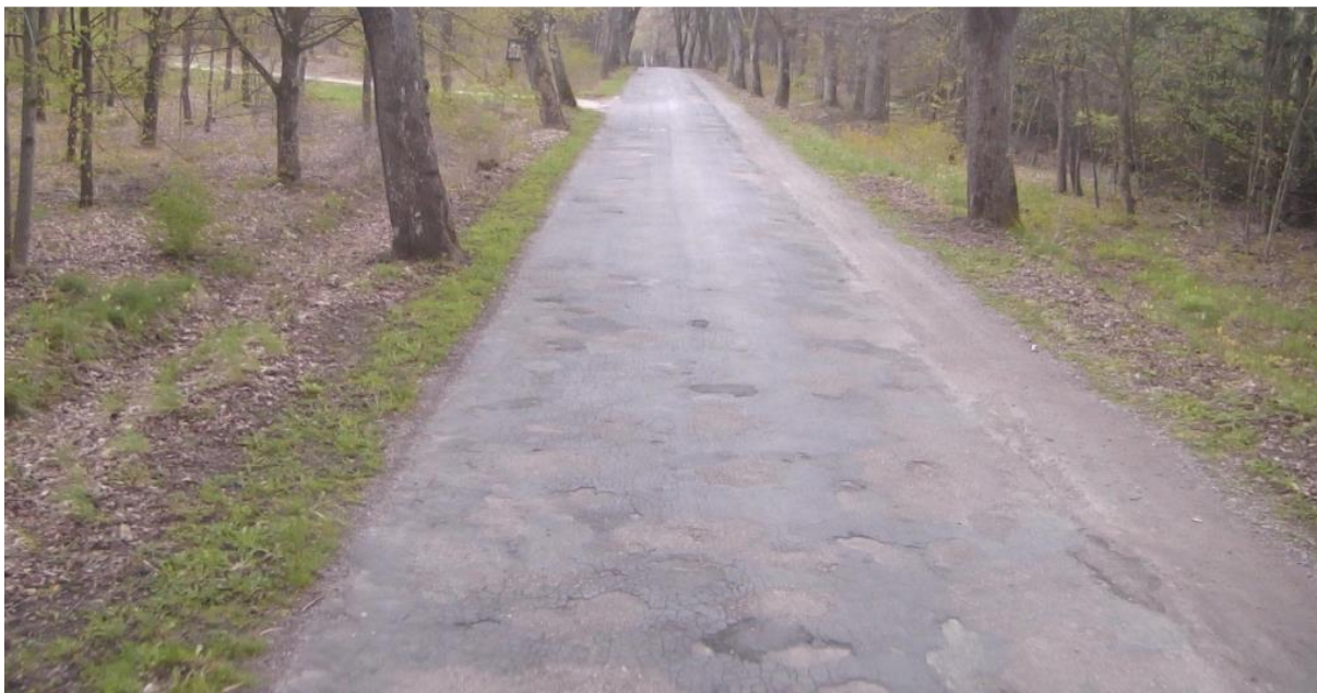
Rys. 7.1.3.7. Poziom decyzyjny krytyczny: liczne wyboje o powierzchni LIW ponad 60 m 2 / sekcja 100 m [4]
