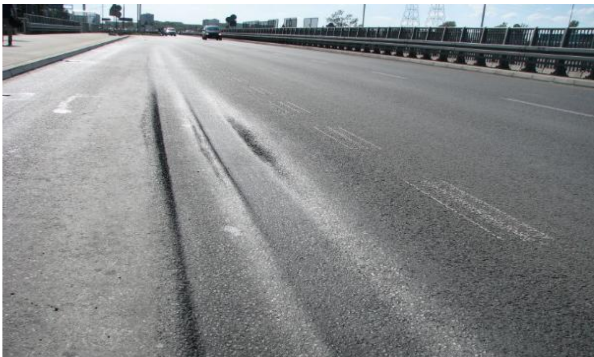
Rys. 7.1.1.1. Widok nierówności poprzecznych lepkoplastycznych
