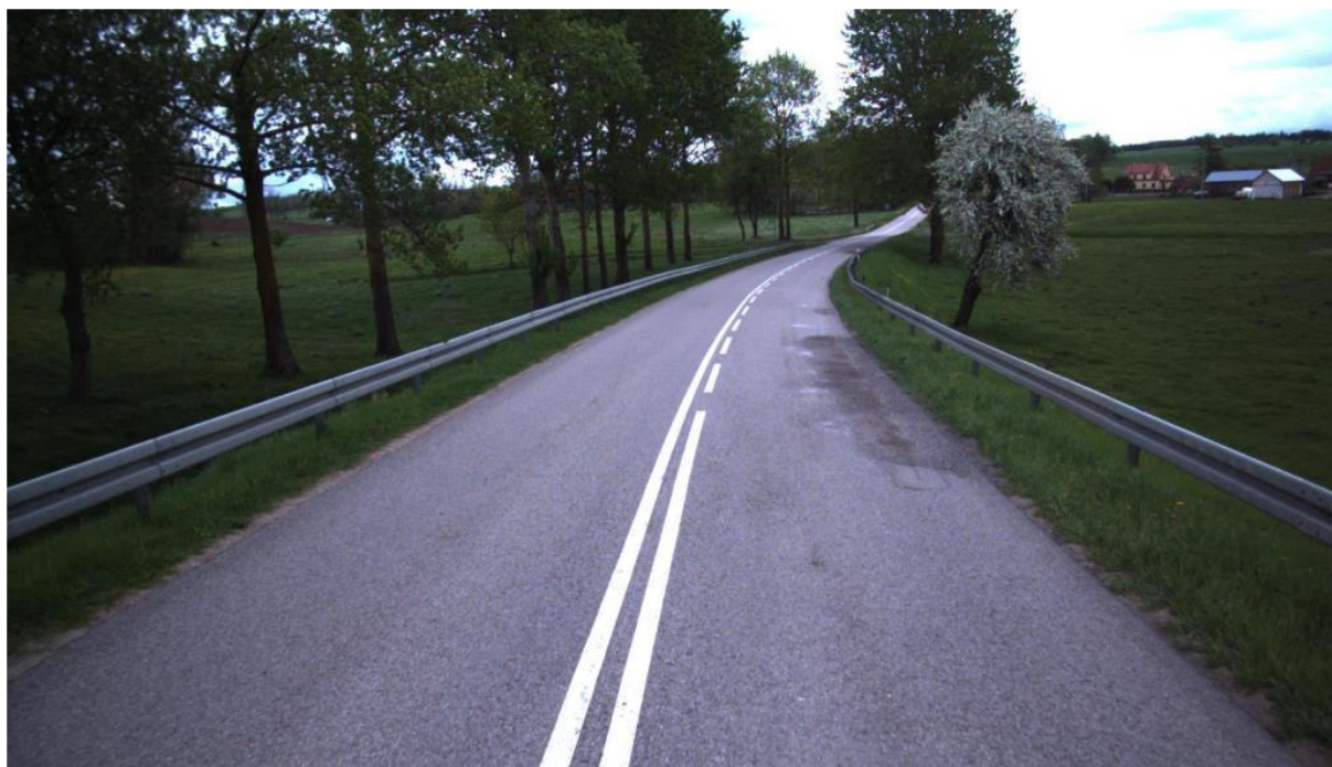
Rys. 7.1.3.5. Poziom decyzyjny ostrzegawczy: łąty o powierzchni LIW do 60 m 2 / sekcja 100 m [4]
