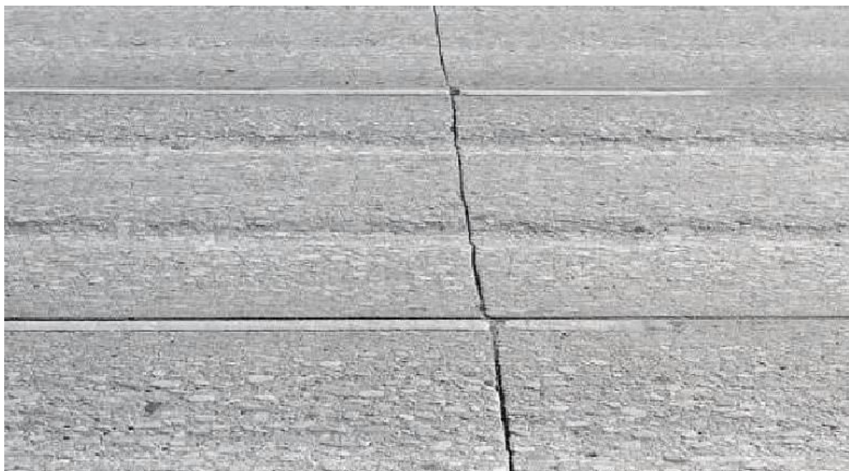
Rys. 7.2.1.6. Widok nierówności poprzecznych
