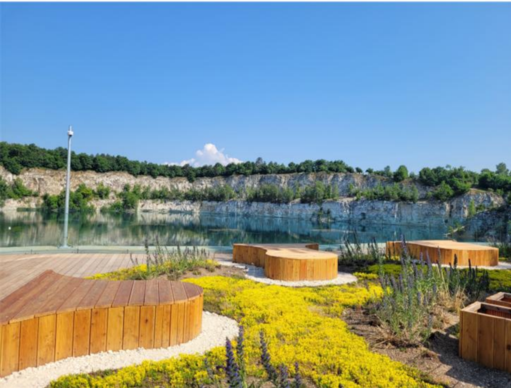
Zielony dach i taras. Zdjęcie: Archiwum ZZM
