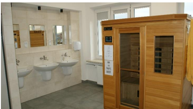
Rysunek 22 Wyremontowane łazienki na pierwszym piętrze
