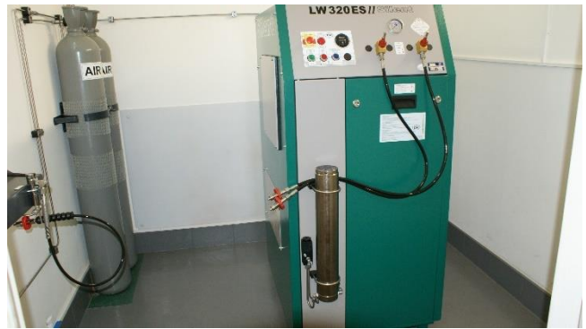
Rysunek 23 Nowa sprężarka z bankiem powietrza
