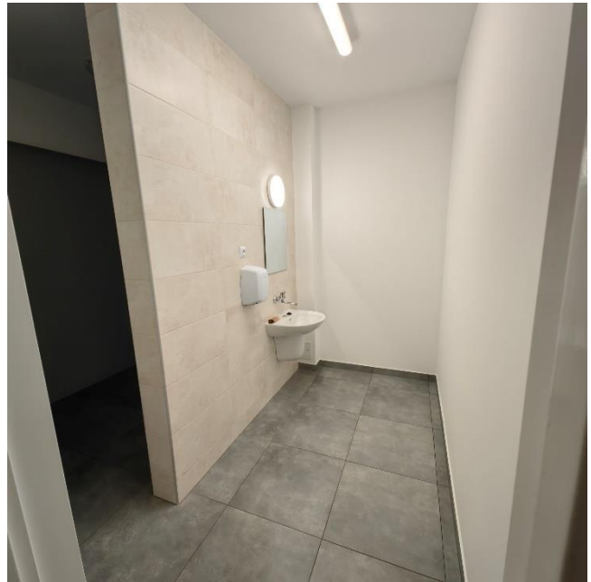
Rysunek 24 Wyremontowana łazienka na drugim piętrze
