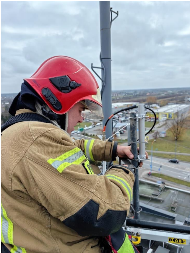
Rysunek 21 Wymiana anten i przewodów na maszcie
