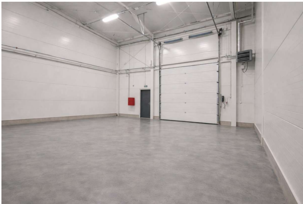
Zdjęcie 64 - Budynek magazynowo - garażowy w JRG Nowa Dęba
