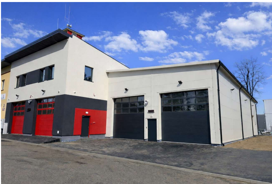
Zdjęcie 1 – obiekt magazynowy wybudowany z POLiOC przy JRG-2 w Nowej Dębie
