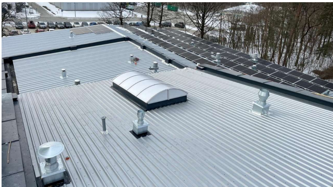
Zdjęcie 63 - Budynek magazynowo - garażowy w JRG Nowa Dęba
