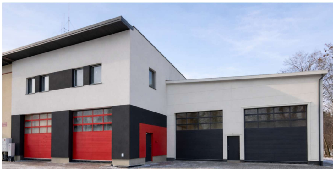
Zdjęcie 61- Budynek magazynowo - garażowy w JRG Nowa Dęba
