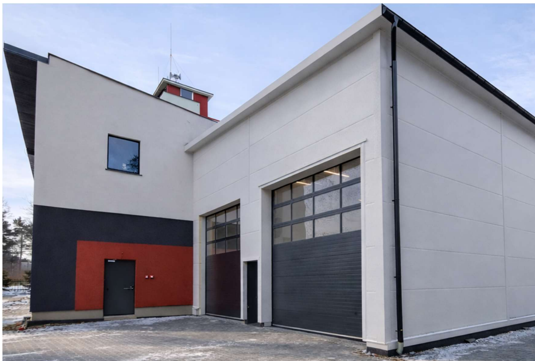
Zdjęcie 62 - Budynek magazynowo - garażowy w JRG Nowa Dęba
