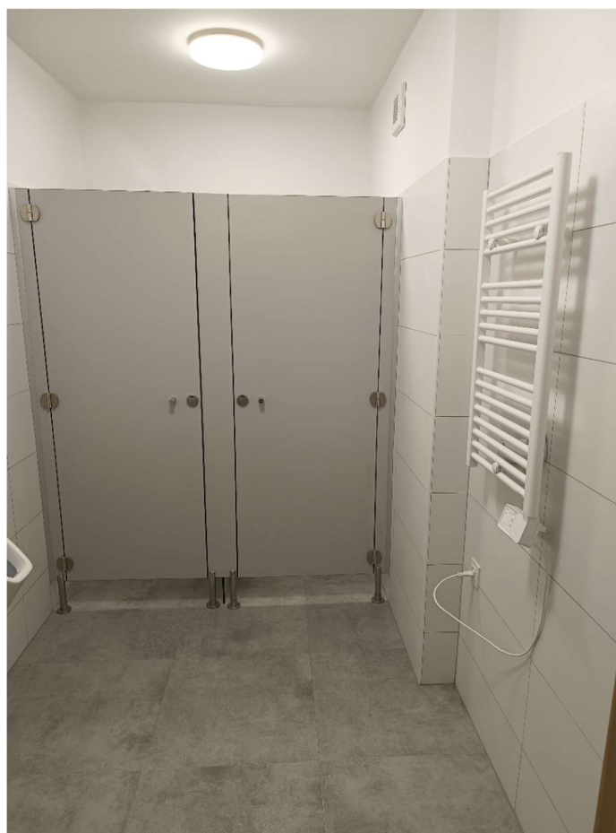
Zdjęcie 70 – Łazienka KM PSP na pierwszym piętrze
