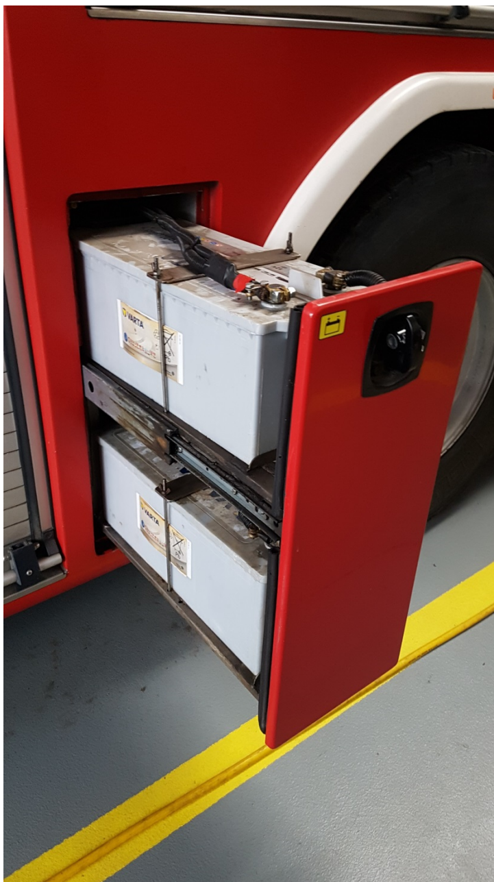
Rys. 93. Akumulatory umieszczone w niestandardowym miejscu. Tu: w wysuwanym schowku
