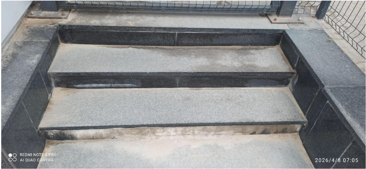
Wymiana pękniętej stopnicy w lewym biegu schodów
