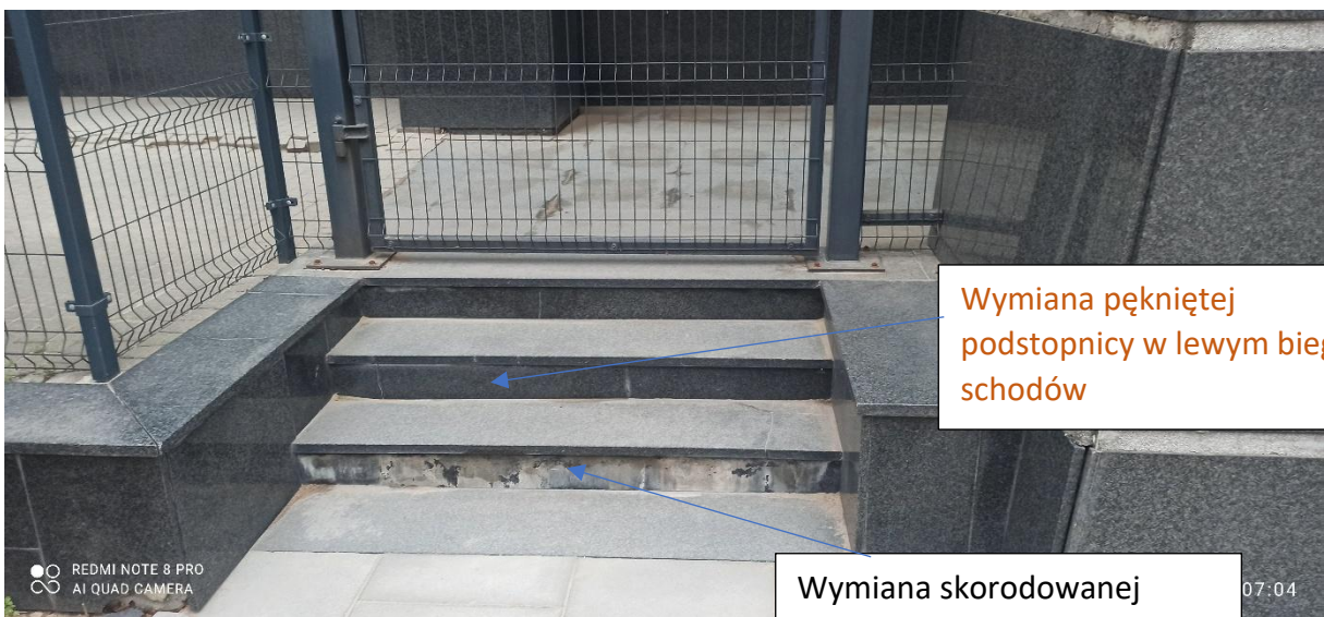
Demontaż i ponowny montaż - górny stopień środkowego biegu schodów
