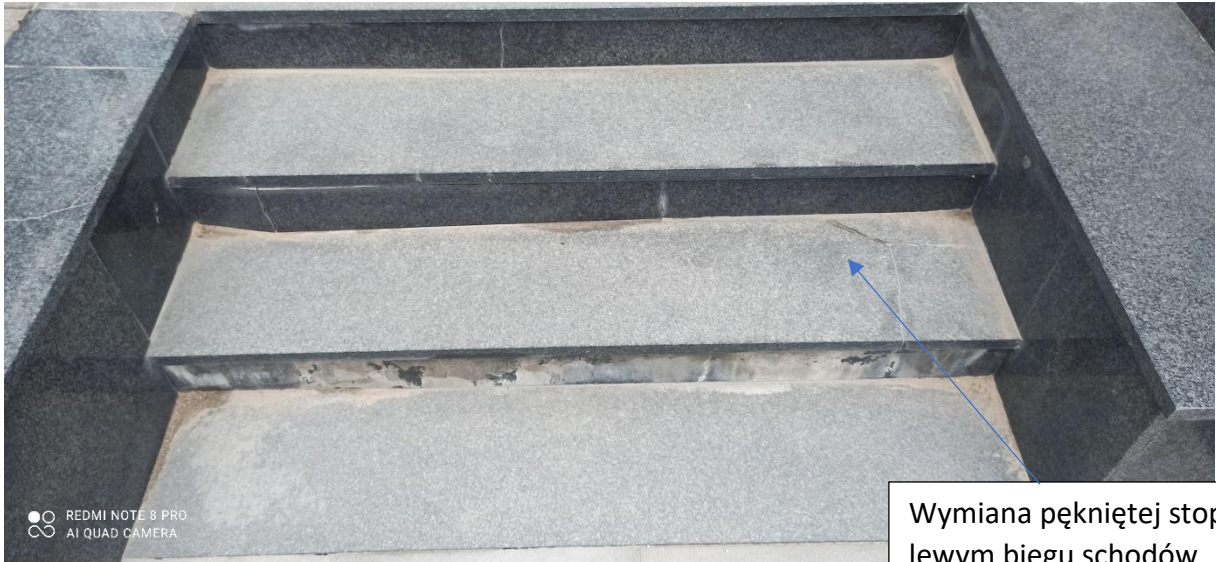
Wymiana skorodowanej podstopnicy w prawym biegu schodów
