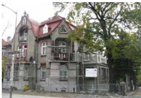
Budynek szkoły podczas termomodernizacji, 2017 r.
