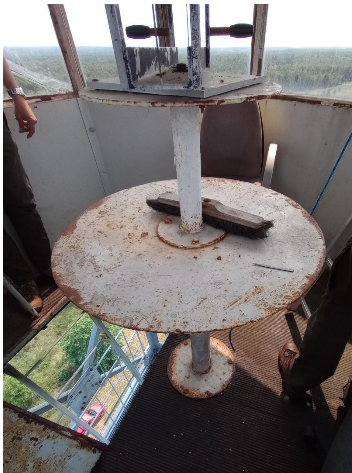
Fot. 6 – Kabina obserwacyjna – wnętrze
