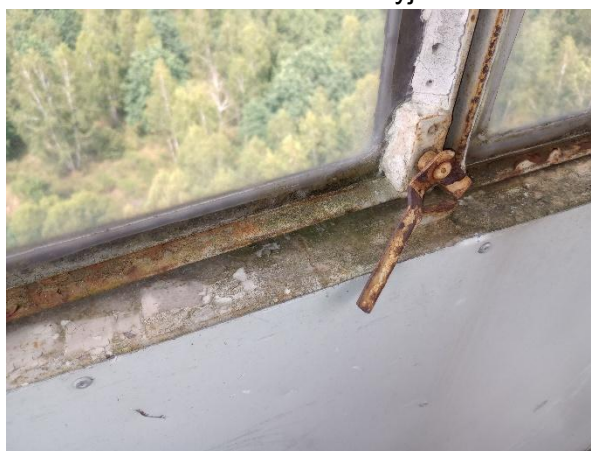
Fot. 5 – Kabina obserwacyjna – okna
