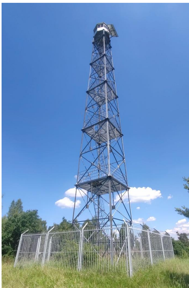
Fot. 1 – Wieża przeciwpożarowa
