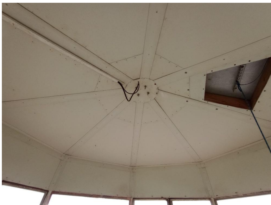
Fot. 7 – Kabina obserwacyjna – dach
