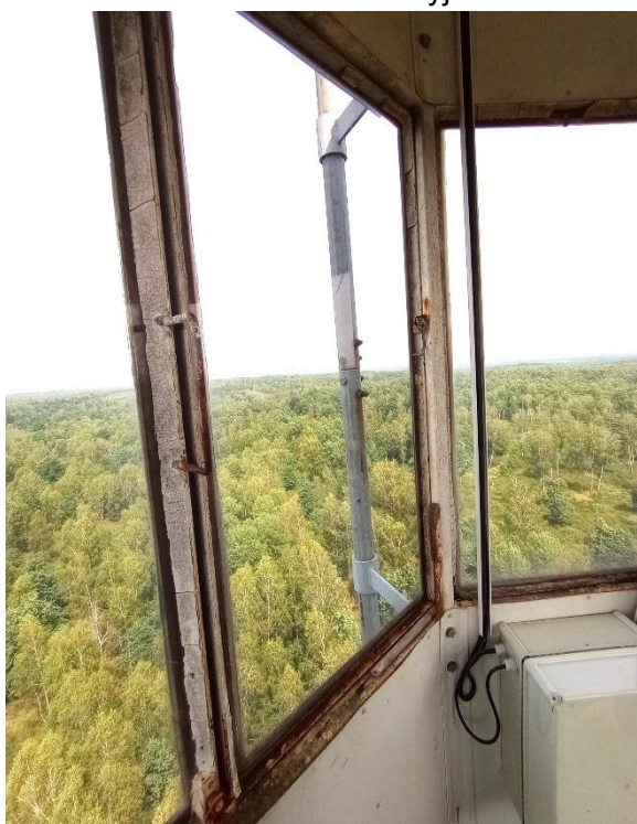
Fot. 4 – Kabina obserwacyjna – okna
