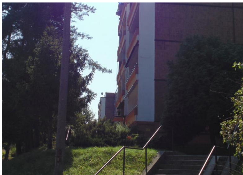
Fot. 1. Pogwizdów, RB1. Lokalizacja punktu pomiarowego (balkon budynku mieszkalnego, 1 kondygnacja)
