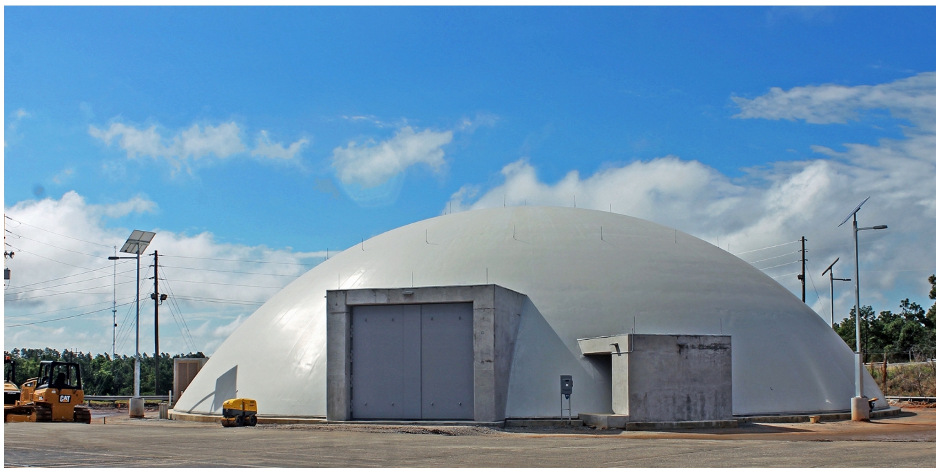
Fot. 7. Kopuła magazynu FLEX stanowi dość dobre zabezpieczenie magazynu przed katastrofami naturalnymi – np. huraganami (fot. Southern Nuclear).
