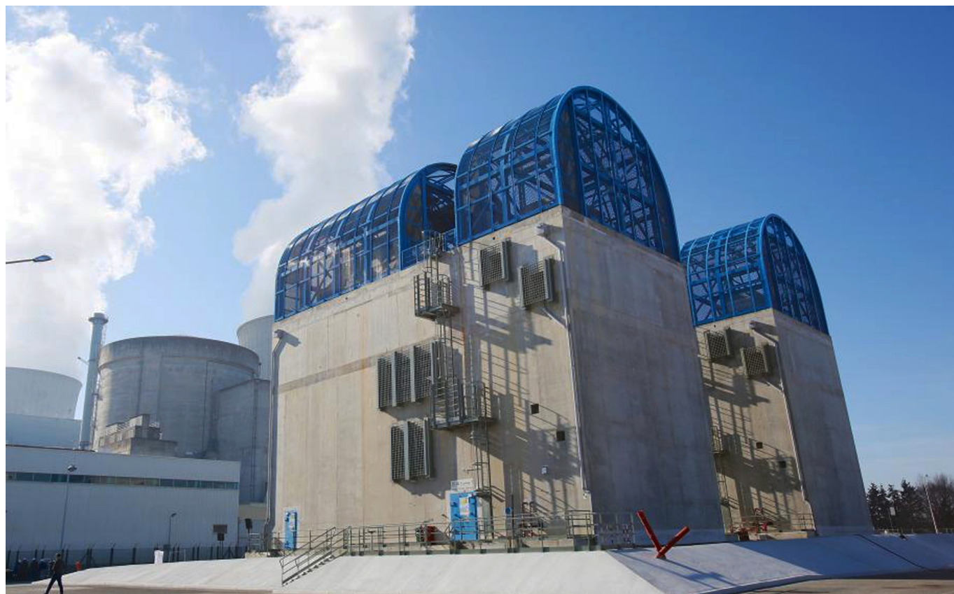
Fot. 1. Standardowe budynki zapasowych agregatów prądotwórczych we francuskich elektrowniach jądrowych (fot. Clemessy, la marque d'Eiffage Énergie Systèmes).
