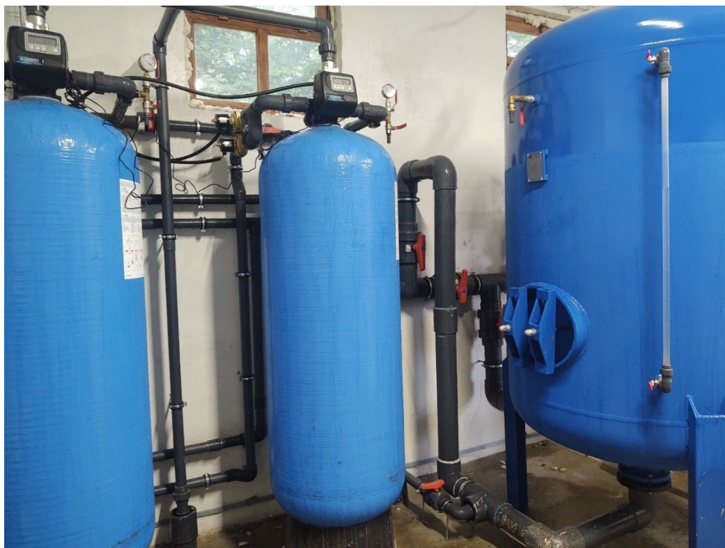
Fot.1. Stacja uzdatniania wody w Grabowie – w trakcie modernizacji (gmina Torzym), (zdjęcie własne).
