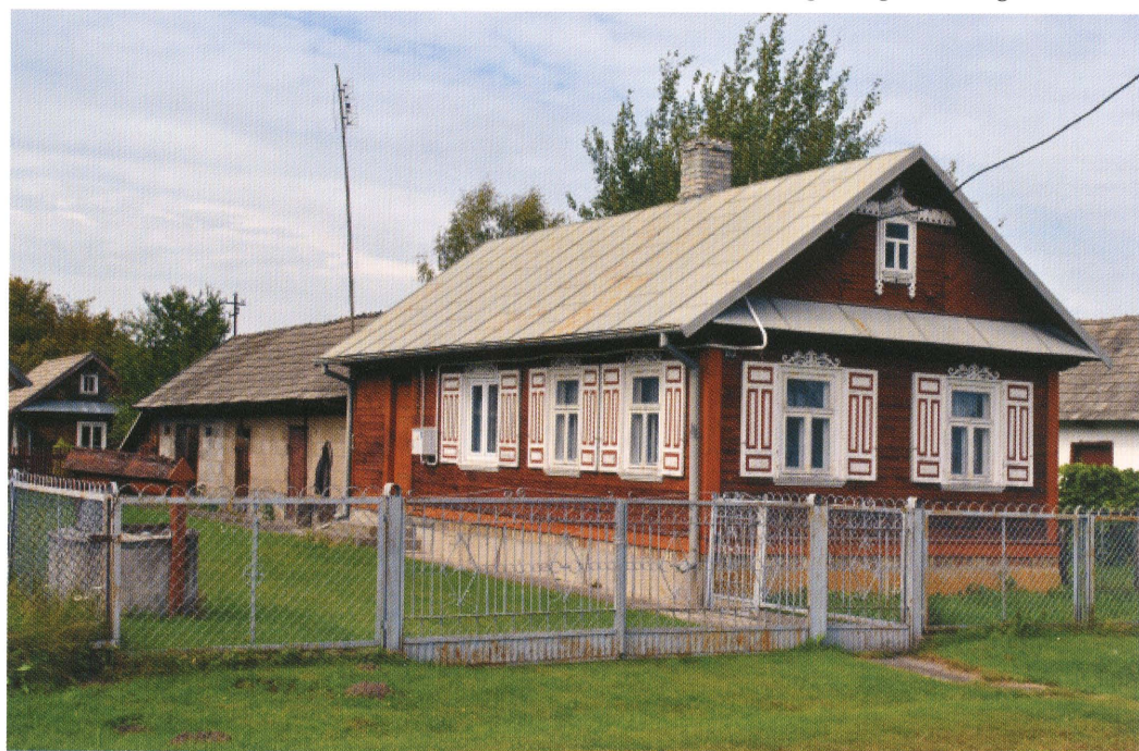
15. Dom nr 83 wraz z budynkiem inwentarskim w jednej linii zabudowy. House no. 83 together with a livestock building arranged in a single line.
