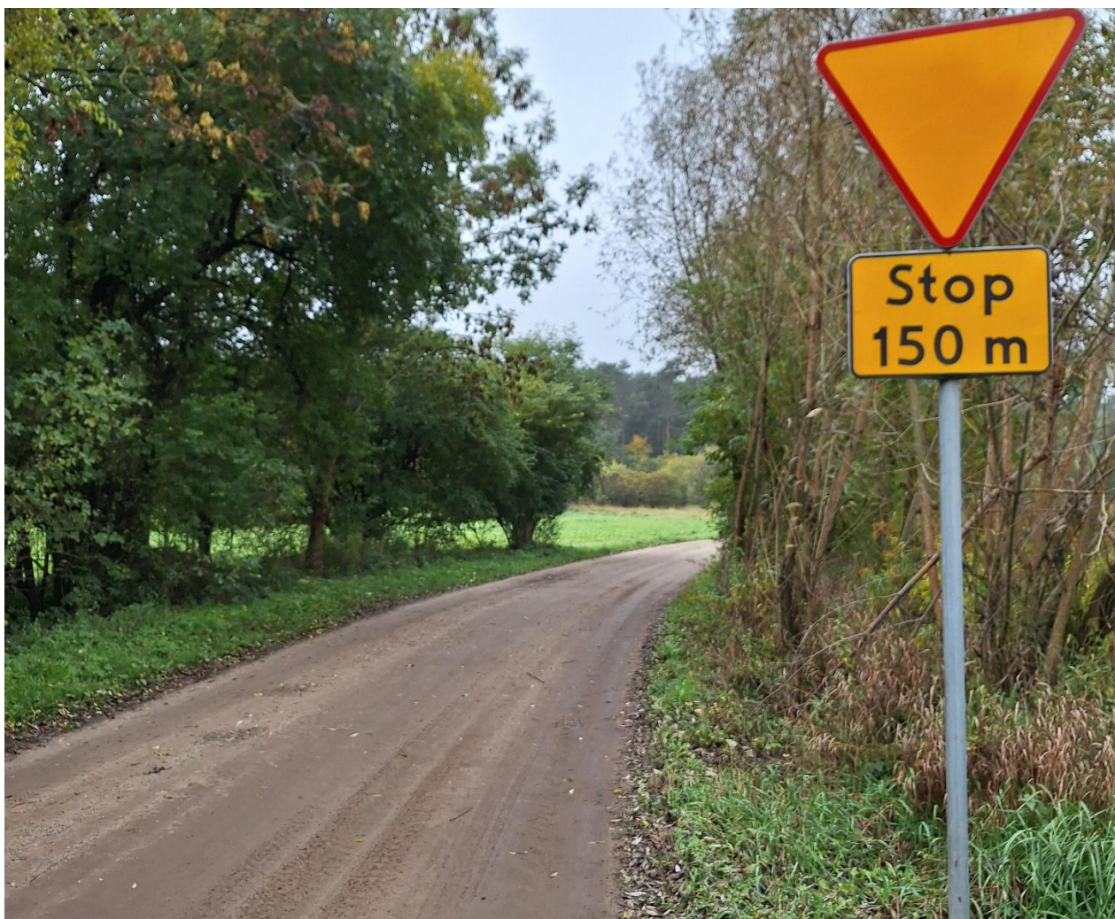
Zdjęcie 7. Znak A-7 z tabliczką „Stop 150 m”, ustawiony ok. 158 m przed przejazdem kolejowym (źródło: PKBWK).
