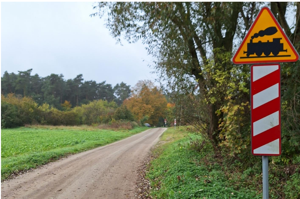
Zdjęcie 8. Znaki A-10 i G-1a ustawione ok. 128 m przed przejazdem kolejowym (źródło: PKBWK).
