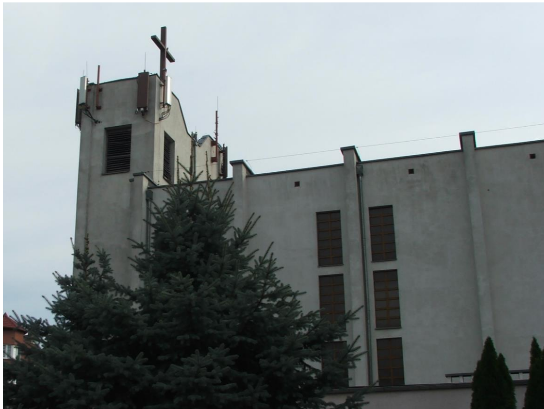
Fot. 1: Widok stacji bazowych ID: BT44281 oraz ID: 35252, zlokalizowanych przy ul. Jaskółczej 39 w Bydgoszczy
