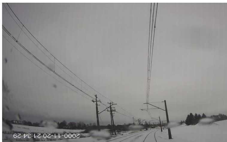
Zdjęcie 4 - Widok z kamery czołowej SA134-019 na pracującą grupę (źródło: materiały przekazane przez POLREGIO S.A.)
