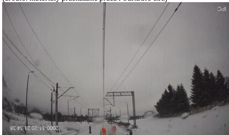
Zdjęcie 5 - Widok z kamery czołowej SA134-019 na pracującą grupę tuż przed wypadkiem (źródło: materiały przekazane przez POLREGIO S.A.)
