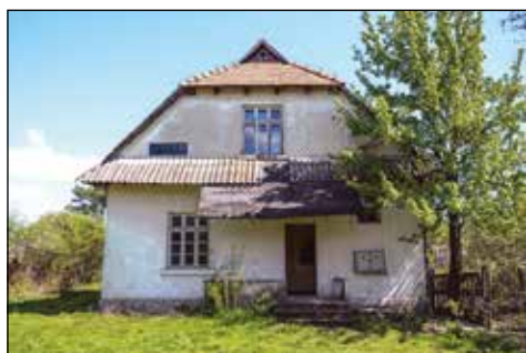
5. „Wirtówka”, elewacja południowo-zachodnia.
