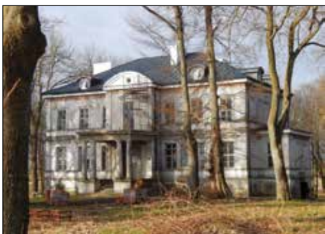
11. Chylin, dwór, stan w trakcie remontu, fot. M. Pędzińska, 2016.
