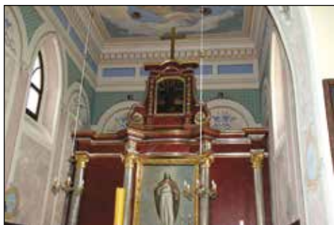
45. Zamch, kościół pw. Św. Józefa BM, fragm.. dekoracji malarskiej prezbiterium po pracach, fot. E. Gliwa-Kawecka, 2016
