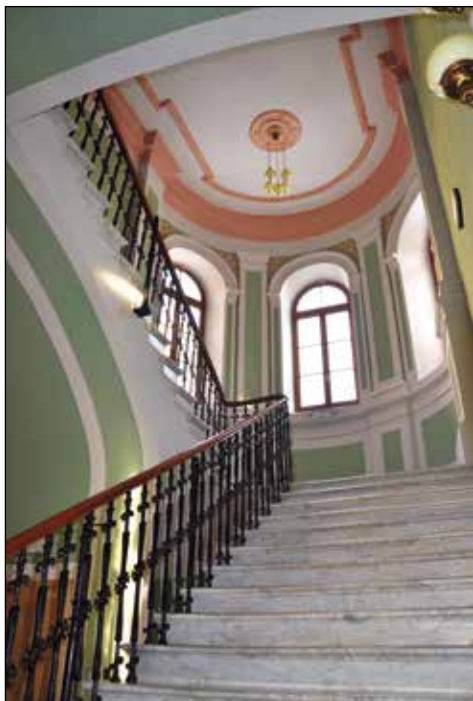
42. Lublin, ul. Krakowskie Przedmieście 43, Sąd – klatka schodowa po remoncie, fot. K. Zarzycka-Goliszek, 2016
