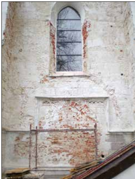
14. Kraśnik, kościół parafialny, zamurowany otwór wejściowy elewacji północnej, fot. B. Stolarz, 2009
