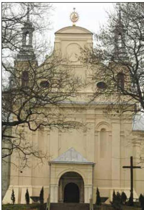
Fot. 11. Uchanie, kościół parafialny, fasada, stan po pracach, fot. M. Trocha, 2011
