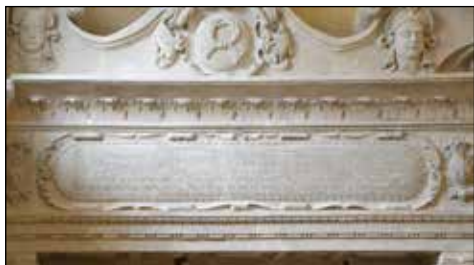
9. Kurów, kościół par., fragm. nagrobka po pracach, fot. B. Stolarz, 2017
