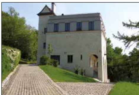
17. Kazimierz Dolny, willa Pruszkowskiego, stan w trakcie prac, fot. A. Grobelny, 2015
