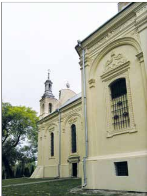
Fot. 9. Uchanie, kościół parafialny, elewacja boczna, kaplica, stan po pracach, fot. G. Żurawicka, 2015
