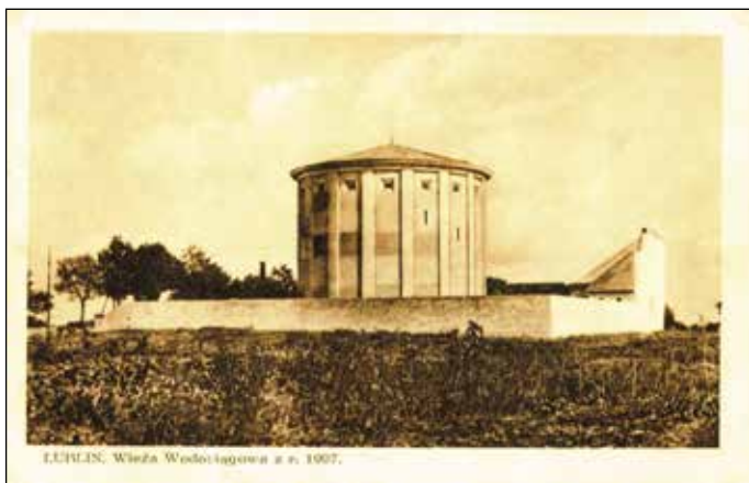
1. Lublin, Wieża Wodociągowa z r. 1927. Pocztówka z kolekcji R. Bogdziewicza w: T. Panfil, M. Wyszowski, J. Lipniewski, Lublin na dawnej pocztówce , Lublin 1997 r., s. 120, il. 269.
