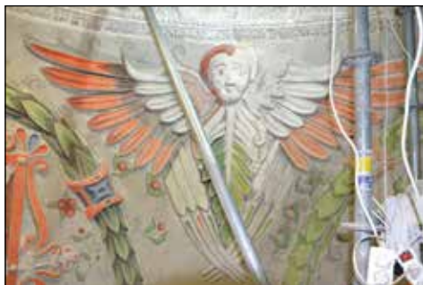
37. Lublin, kościół dominikanów, kaplica Ossołińskich, prace przy dekoracji sztukatorskiej, fot. K. Tur-Marciszek 2017
