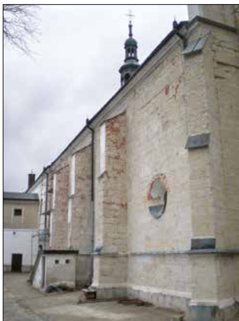
13. Kraśnik, kościół parafialny, elewacja północna w trakcie prac, fot. B. Stolarz, 2009
