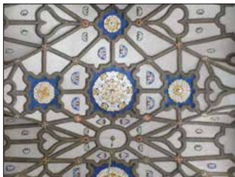
16. Kodeń, kościół św. Anny, sklepienie nawy po pracach, fot. M. Filip, 2016
