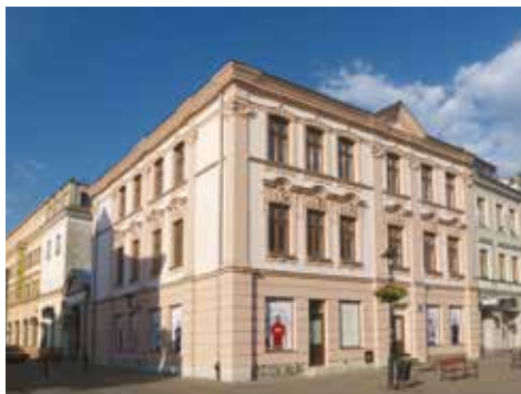
31. Lublin, ul. Krakowskie Przedmieście 20, kamienica, po remoncie elewacji, fot. A. Frąckiewicz, 2016
