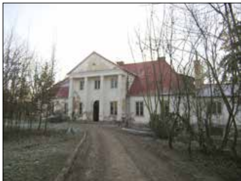
57. Średnia Wieś, dwór, stan przed remontem, fot. S. Rudnik, 2013.
