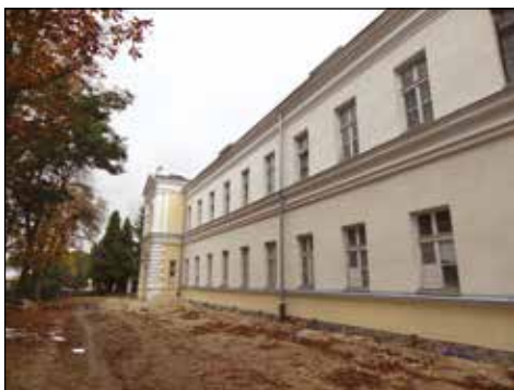
6. Chełm, ul. Hrubieszowska 102, budynek administracji i sztabu, widok ogólny w trakcie prowadzenia prac, fot. M. Pędzińska, 2016.
