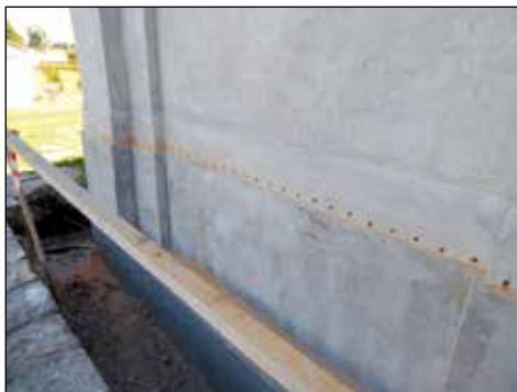
4. Buśno, kościół, w trakcie prac, fot. M. Pędzińska, 2016.
