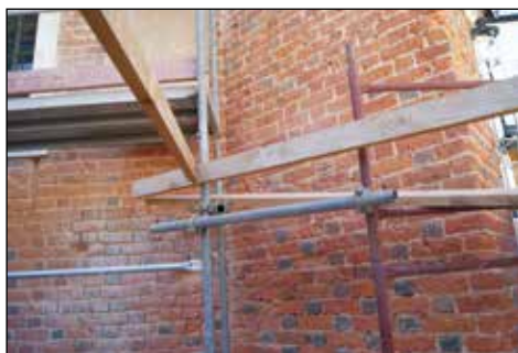
5. Kraśnik, kościół parafialny, doczyszczanie powierzchni cegieł, fot. B. Stolarz, 2008
