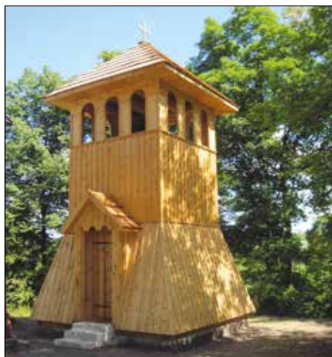
56. Susiec, dzwonnica przykościelna, po pracach remontowych, fot. M. Fornal, 2016
