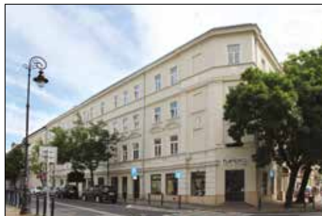
35. Lublin, ul. Kapucyńska 6, kamienica, stan po remoncie, fot. K. Rutkowski, 2017
