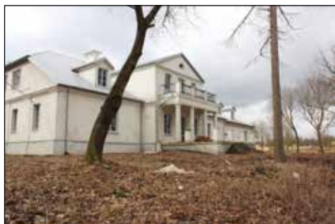
59. Wilczyska, dwór w trakcie remontu, fot.....
