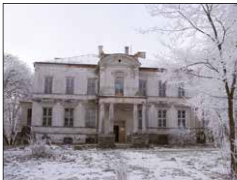
10. Chylin, dwór, stan przed remontem, fot. S. Rudnik, 2006.
