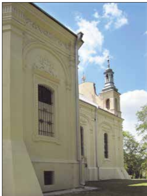
Fot. 7. Uchanie, kościół, elewacja boczna północna, G. Żurawicka, 2015
