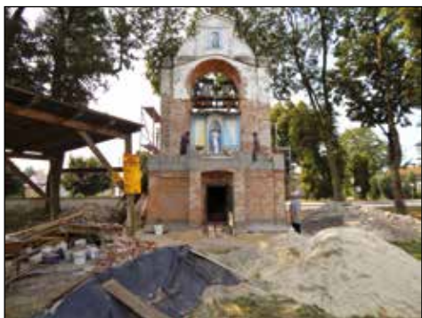
60. Wojsławice, dzwonnica, stan po zakończeniu etapu prac, fot. M. Pędzińska, 2016.
