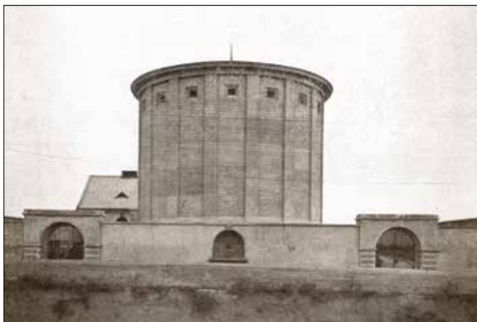
2. Widok na wieżę ciśnieniową, 1928 rok. Fotografia w: St. Michałowski, Sto lat współczesnych wodociągów w Lublinie 1899-1999 , Lublin 1999 r., s. 74. Oryginał w: Roboty Publiczne wykonane w mieście Lublinie przez firmę Ulen & Company , New York, Warszawa 1929. (fotografia wykorzystana także w: karta ewidencyjnej zabytków architektury i budownictwa oprac. przez mgr inż. J. Gubańskiego i dr inż. arch. R. Gubańską, Wodociągowa wieża ciśnieniowa , 2001 r.).
