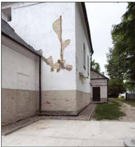
18. Klesztów, kościół, po wykonaniu prac, fot. M. Pędzińska, 2016.
