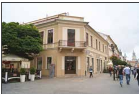
29. Lublin, ul. Krakowskie Przedmieście 25, kamienica, stan po remoncie elewacji, fot. K. Rutkowski, 2016
