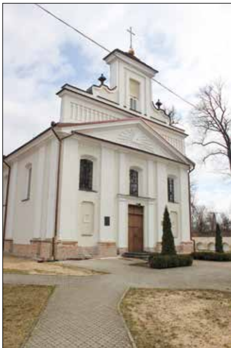
53. Sosnowica, kościół w trakcie remontu, fot. 2016
