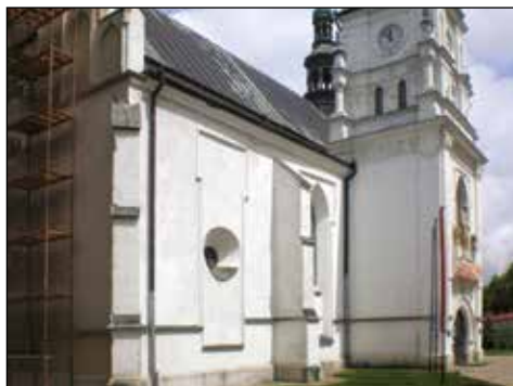
12. Kraśnik, kościół parafialny, elewacja południowa przed pracami, fot. B. Stolarz, 2009
