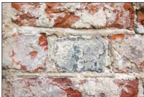
3. Kraśnik, kościół parafialny, fragment ze wstępnym doczyszczaniem powierzchni cegły, fot. B. Stolarz, 2008
