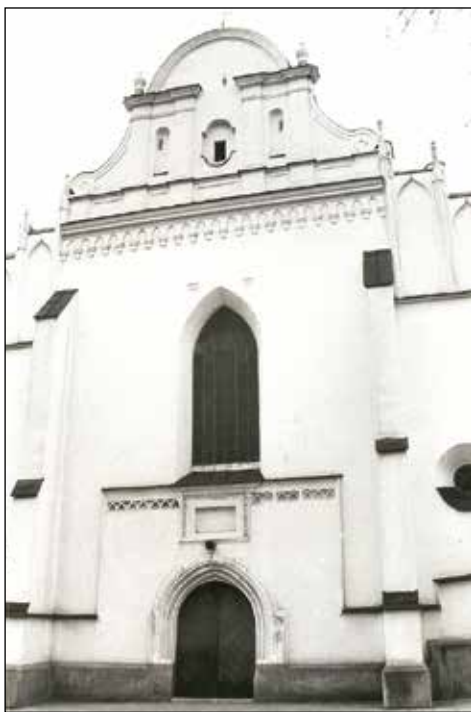
4. Kraśnik – kościół parafialny – fasada – część środkowa – stan z roku 1991, fot. J. Bożek [w:] Kościół par. w Kraśniku /architektura/, dokumentacja naukowo-historyczna z 1991 r.
