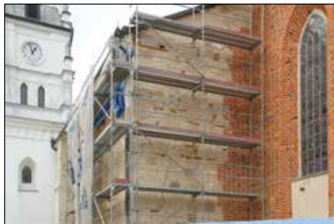
7. Kraśnik, kościół parafialny, mur kaplicy pd. po odkuciu wtórnych tynków, fot. B. Stolarz, 2008
