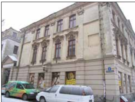
30. Lublin, ul. Krakowskie Przedmieście 20, kamienica, przed remontem, fot. K. Rutkowski, 2011
