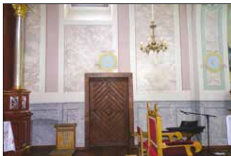
46. Zamch, kościół pw. Św. Józefa BM, fragm.. dekoracji malarskiej prezbiterium po pracach, fot. E. Gliwa-Kawecka, 2016
