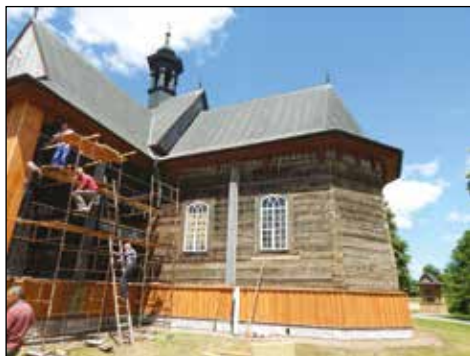
8. Chłaniów, kościół, elewacje w trakcie wymiany szalunku, fot. M. Pędzińska, 2016.
