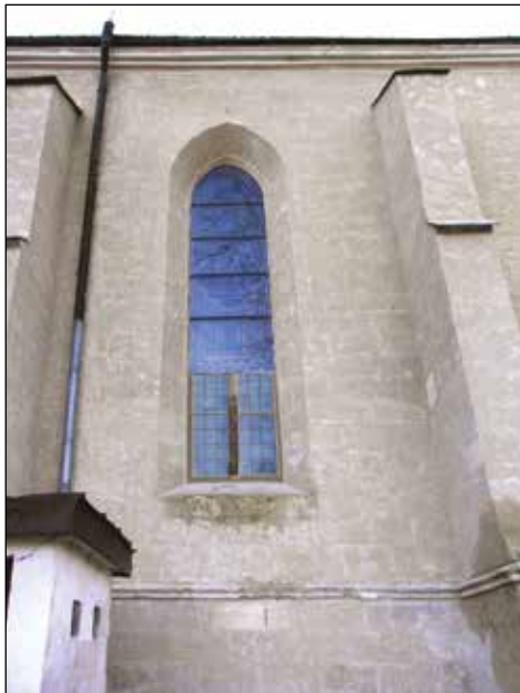
15. Kraśnik, kościół parafialny, pierwotne okno w elewacji północnej, fot. B. Stolarz, 2009
