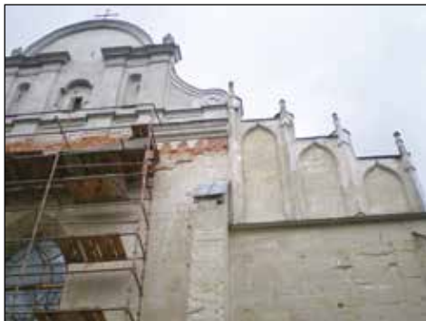
6. Kraśnik, kościół parafialny, fasada w trakcie usuwania tynków pod szczytem – stan z roku 2007, fot. B. Stolarz
