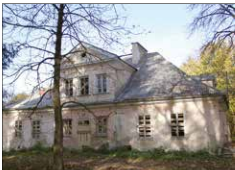
12. Dąbie, dwór przed remontem, fot. S. Rudnik, 2006.
