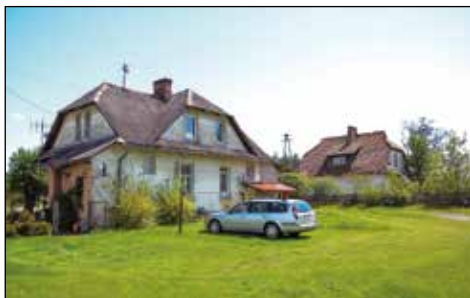
2. Budynek na dz. 262/2 - widok od podwórza, w tle „Wirtówka”.
