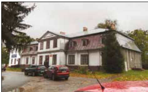
52. Siedliszcze, dwór – po przeprowadzeniu prac, fot. M. Pędzińska, 2016.
