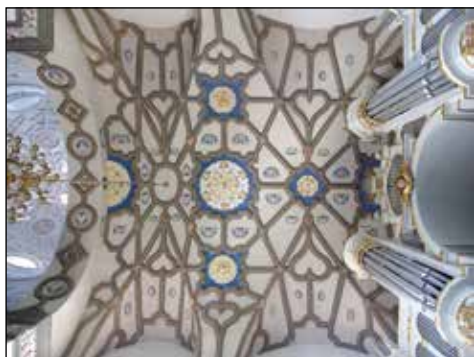
15. Kodeń, kościół św. Anny, sklepienie nawy po pracach, fot. M. Filip, 2016
