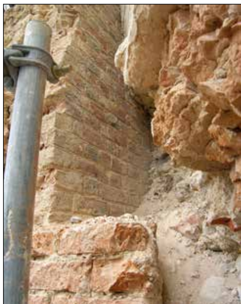
3. Kraśnik, kościół parafialny, fragment ze wstępnym doczyszczaniem powierzchni cegły, fot. B. Stolarz, 2008
