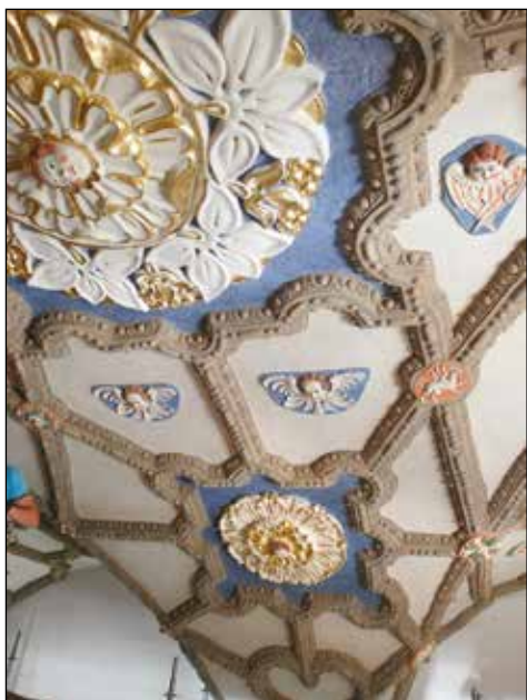
17. Kodeń, kościół św. Anny, fragment sklepienia nawy po pracach, fot. M. Filip, 2016
