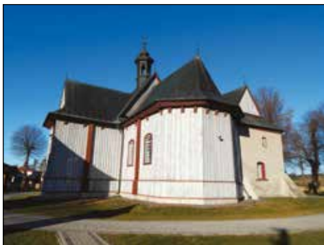
7. Chłaniów, kościół, elewacje przed wymianą szalunku, fot. P. Wira, 2016.
