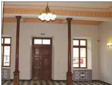
41. Lublin, ul. Krakowskie Przedmieście 43, Sąd – hall po pracach konserwatorskich, fot. K. Zarzycka-Goliszek, 2016
