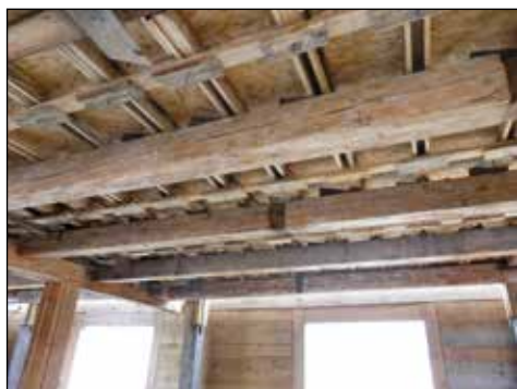
26. Kraśnik, d. szpital przykościelny, ul. Narutowicza 29, stan w trakcie odbudowy – oryginalne belki stropowe, fot. M. Kurczewicz, 2016
