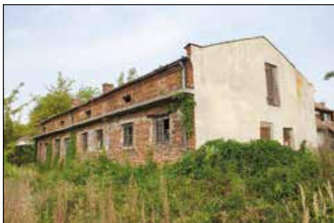
7. Budynek gospodarczy, widok od południa.
