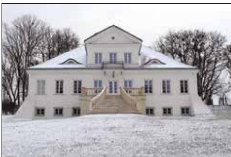
14. Dąbie, dwór, elewacja ogrodowa po remoncie, fot. M. Pędzińska, 2016.
