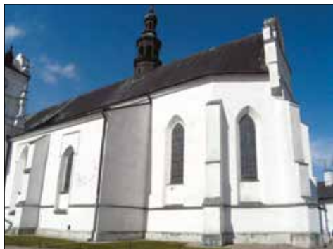
1. Kraśnik, kościół parafialny, prezbiterium przed pracami, fot. B. Stolarz, 2008
