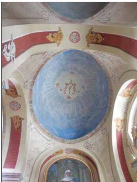
37. Tarnobrzeg, kościół pw. Przemienienia Pańskiego, malowidła ścienne, stan po pracach, fot. M. Filip, 2016
