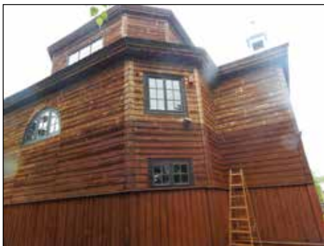
2. Borowica, kościół, elewacje w trakcie oczyszczania szalunku, fot. M. Pędzińska, 2016.
