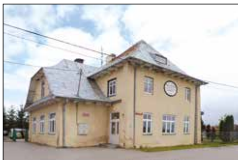
4. Szaniawy-Matysy, budynek szkoły powszechnej, fot. A. Frąckiewicz, 2016.
