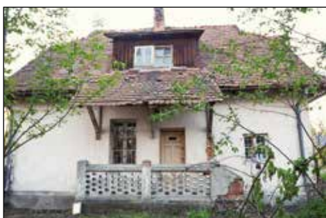
4. „Wirtówka”, elewacja południowo-wschodnia.
