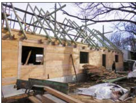
27. Kraśnik, d. szpital przykościelny, ul. Narutowicza 29, stan w trakcie odbudowy, fot. M. Kurczewicz, 2016
