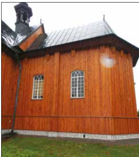
9. Chłaniów, kościół, elewacje po remoncie, fot. M. Pędzińska, 2016.
