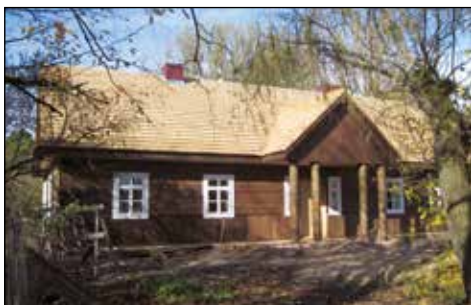
23. Korhynie, dwór w trakcie prac, fot. M. Fornal, 2016
