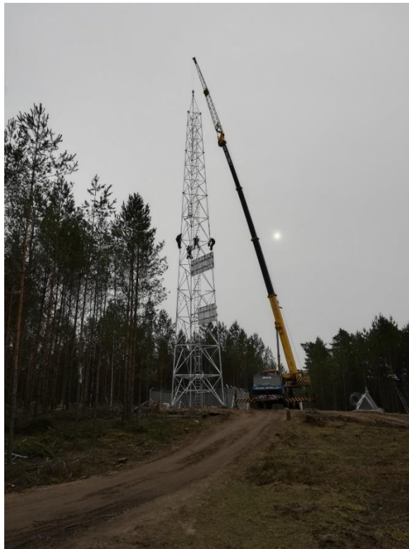
Wieża ppoż. w Leśnictwie Zacisze - budowa
