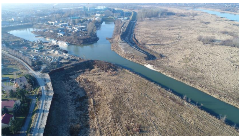
Teren planowanej inwestycji
