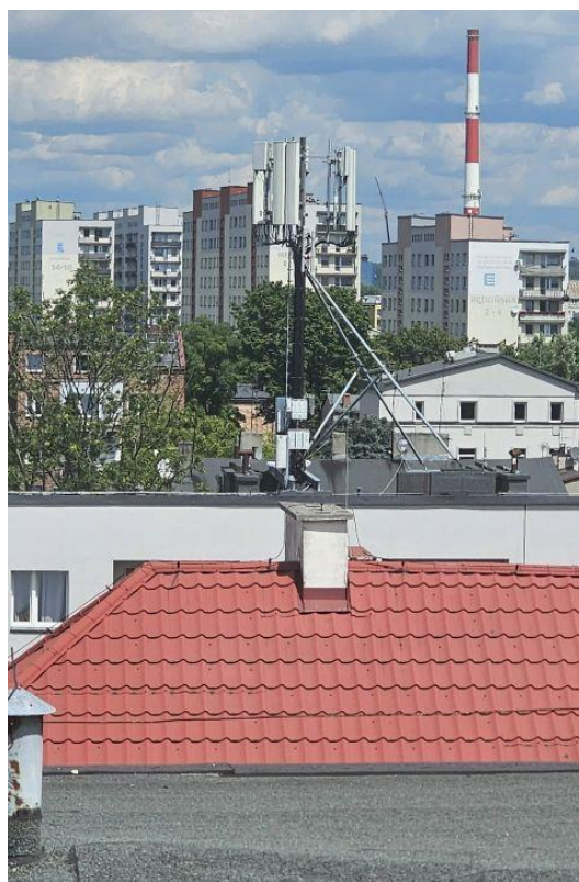
Rys. 4 Widok na SBTk z miejsca montażu SMS PEM – Biblioteka WHUŚ
