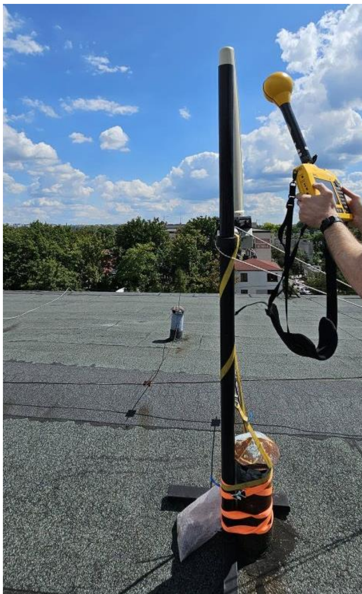
Rys. 9 Biblioteka WHUŚ – pomiary selektywne SRM-3600
