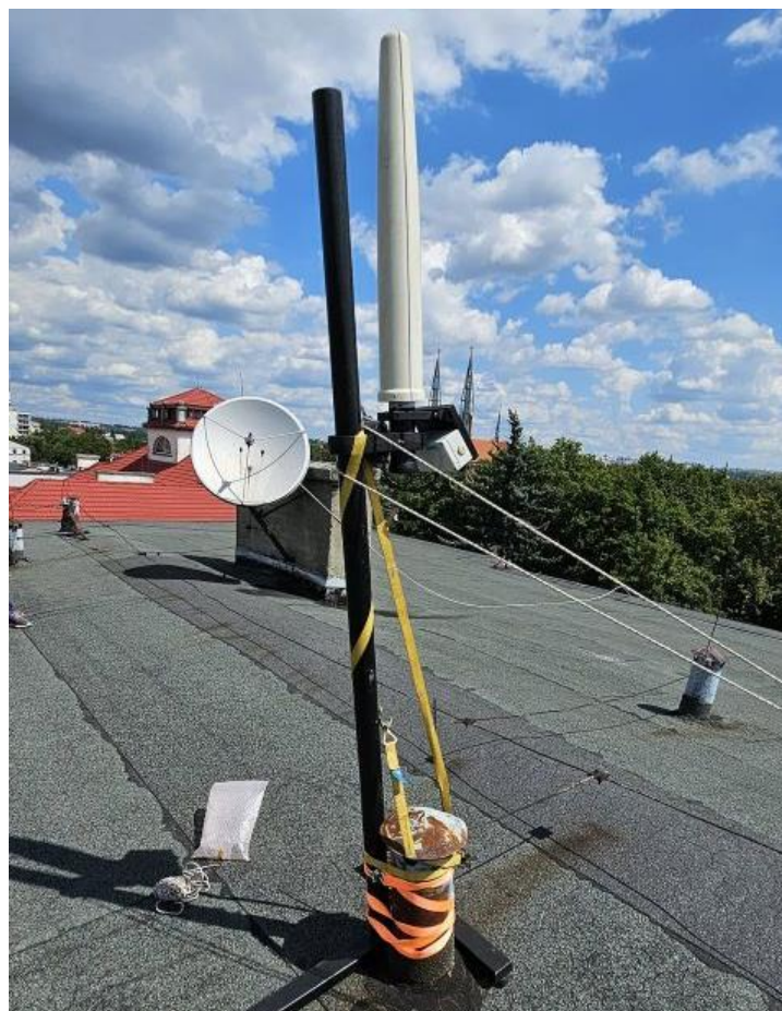
Rys. 2. Miejsce montażu SMS PEM – Biblioteka WHUŚ
