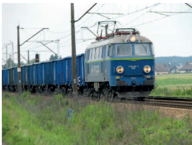
Fot. 1. Linia kolejowa na odcinku Kalety-Herby
