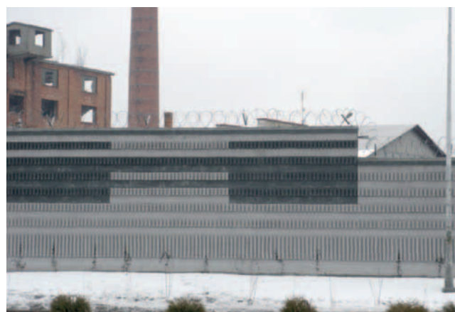
Fot. 3. Ekran akustyczny
