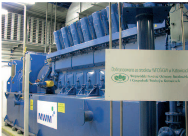
Fot. 4. Agregat prądowórczy w EC Moszczenica, zasilany gazem z odmetanowania kopalń
