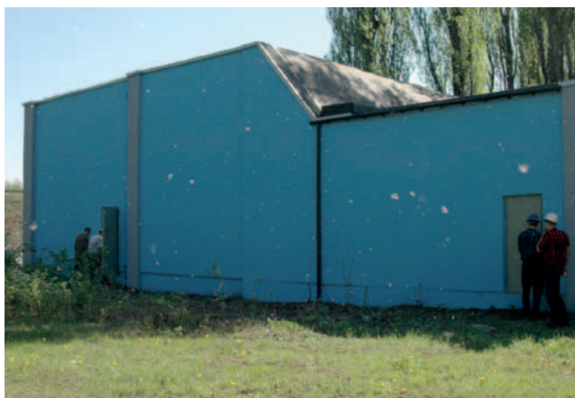
Fot. 5. Termomodernizacja ścian zewnętrznych budynku dyfuzora
