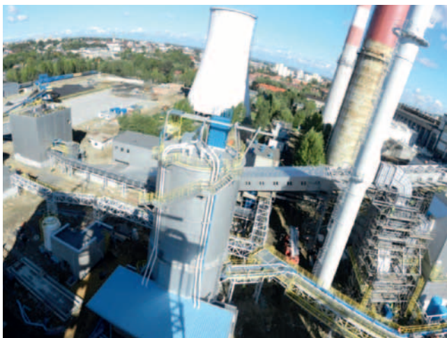
Fot. 1. Widok ogólny Elektrociepłowni Bielsko-Biała EC1
