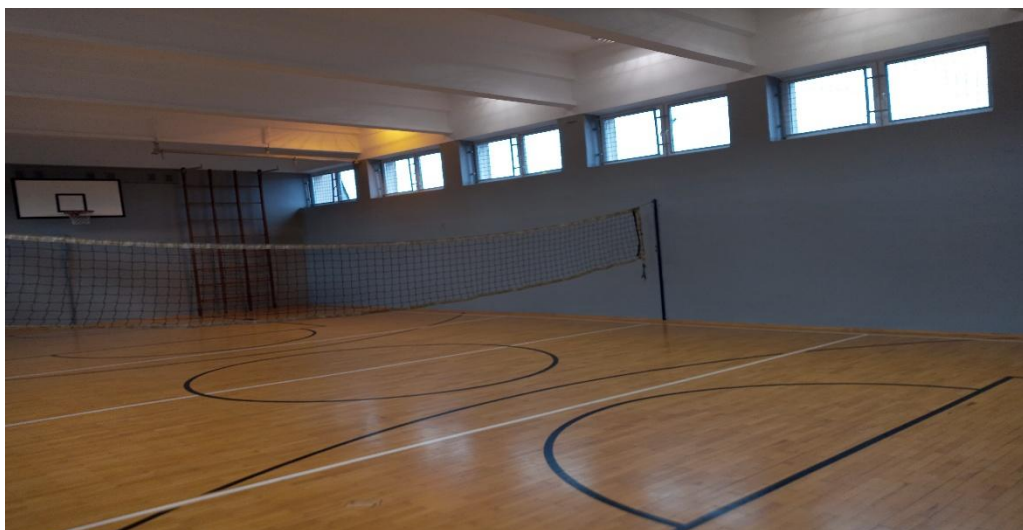
Sala gimnastyczna w Zespole Szkół Techniczno-Elektronicznych w Kaliszu (odmalowano ściany i sufit)
