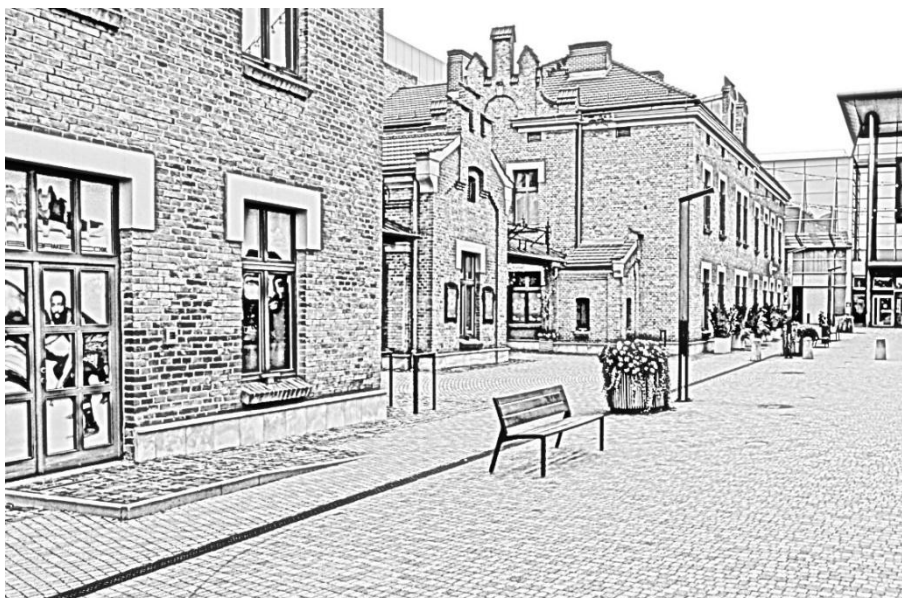
Rys. 4.3.10. Przykład placu przed galerią handlową z prowadzeniem wody opadowej ściekiem odsuniętym od wejść do budynków; na zdjęciu widoczna jest próba ukrycia (kamufażu) ścieku korytkowego elementami małej architektury
