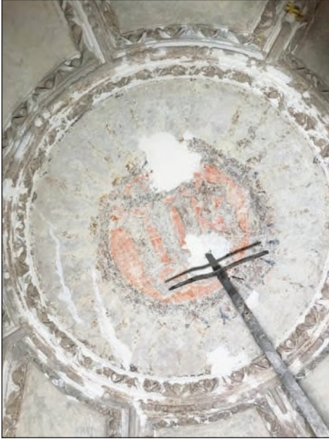
4. Dekoracja sklepienia w trakcie prac, fot. L. Lawryniuk
