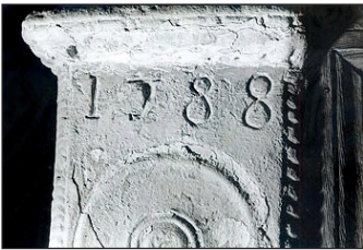
6. Kazimierz Dolny, kapliczka przy ul. Szkolnej, fragment nadstawy z odkrytą datą, fot. 1972 r. ( http://przyjacielekazimierza.pl/nowa/?p=1235 )
