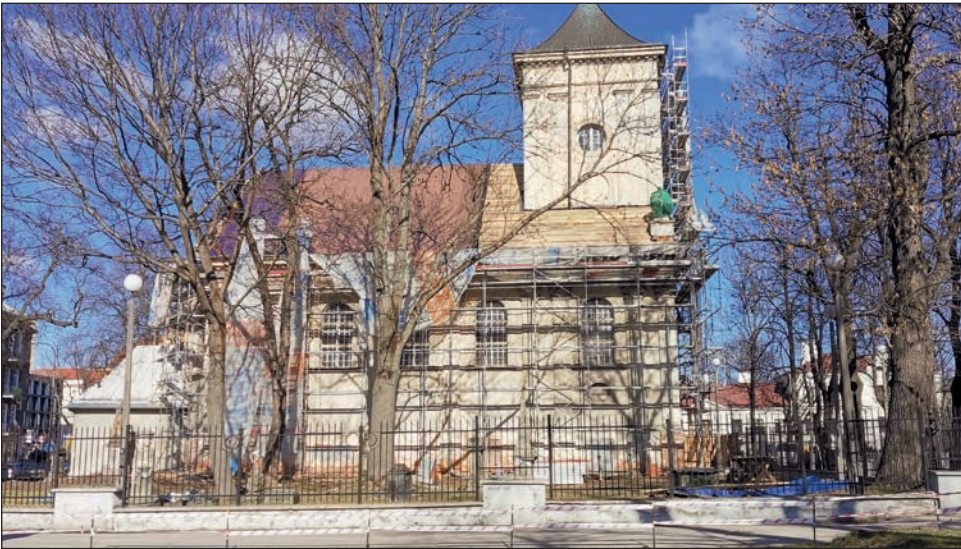
7. Kościół podczas remontu dachu i wieży, fot. B. Stolarz
