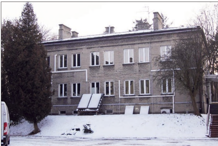
Fot. 5. Widok elewacji wschodniej budynku administracyjnego, K. Janus, 2023 r.
