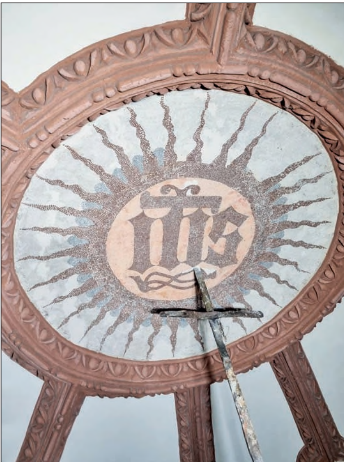
18. Dekoracja sklepienia w trakcie prac, fot. M. Jańczuk, 2023
