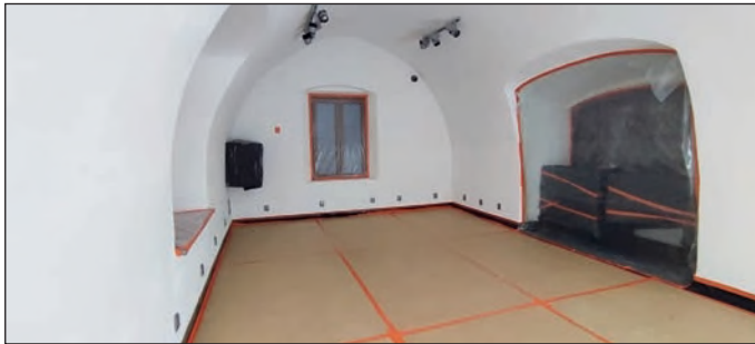
2. Kraśnik – kościół par., oratorium (cz. wsch.) przed pracami, fot. M. Filip, 2021
