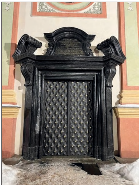
25. Barokowy portal w przyziemiu fasady po konserwacji, fot. M. Filip, 2022
