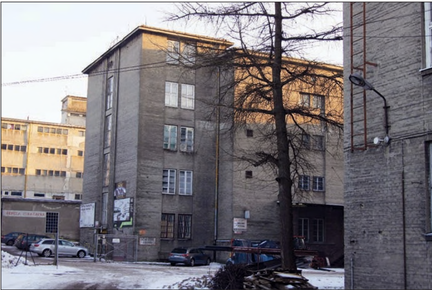
Fot. 6. Budynek E – widok od północy, 2023 r., K. Janus
