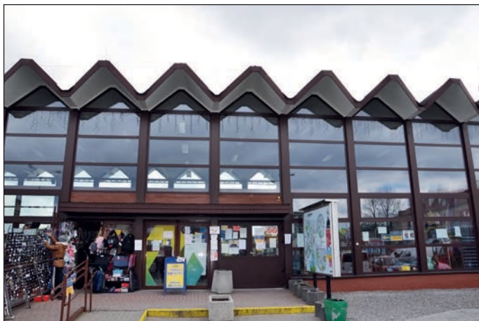
1. Lublin, hala główna dworca PKS, fot. M. Zieniewicz
