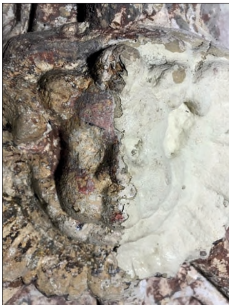
8. Detal sklepienia w trakcie prac, fot. L. Laryniuk
