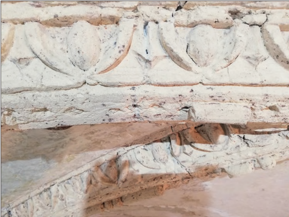
5. Dekoracja sklepienia w trakcie prac, fot. L. Lawryniuk
