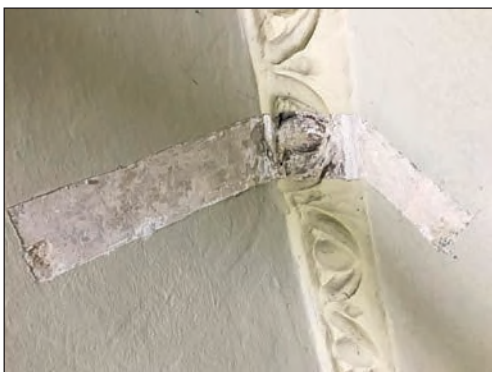
1. Detal sklepienia prezbiterium – odkrywka sondażowa, fot. L. Lawryniuk
