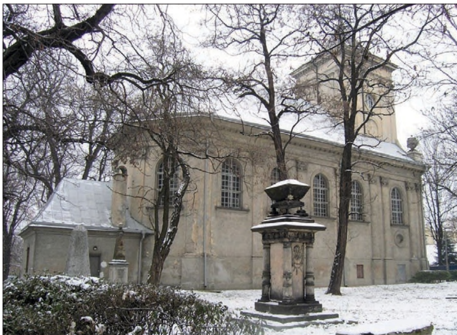
4. Elewacja kościoła przed remontem, fot. B. Stolarz
