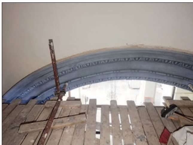
16. Fragment sklepienia w trakcie prac, fot. M. Jańczuk, 2023
