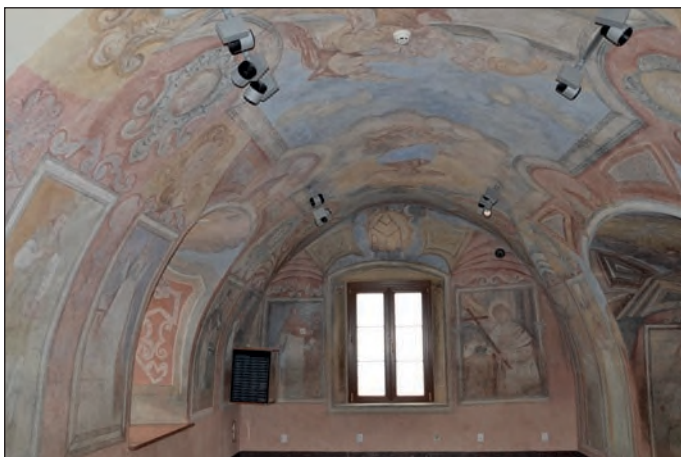
8. Kraśnik – kościół par., cz. wsch. oratorium po pracach, fot. M. Filip, 2023
