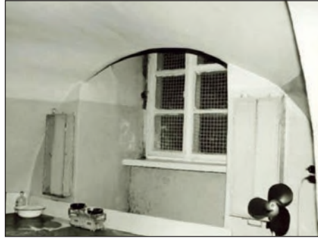
9. Pomieszczenie na parterze w skrzydle południowym
