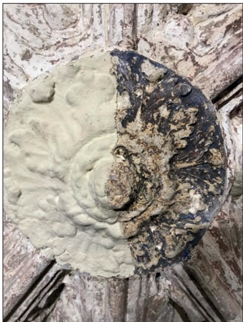
7. Detal sklepienia w trakcie prac, fot. L. Laryniuk
