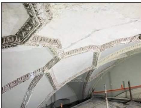
10. Detal sklepienia w trakcie prac, fot. L. Laryniuk
