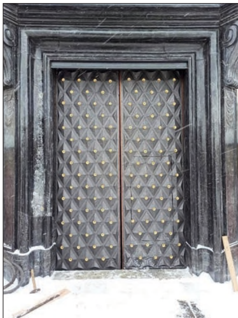
30. Drzwi główne do kościoła po konserwacji, fot. M. Filip, 2022
