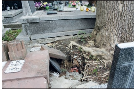
Fot. 17. Zniszczenia nagrobków powodowane przez system korzeniowy jesionu wyniosłego, rosnącego na cmentarzu przy ul. Lipowej w Lublinie (fot. B. Olszak, 2022 r.)
