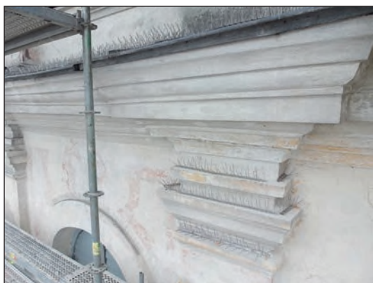
2. Oryginalna dekoracja malarska na elewacji frontowej po odsłonięciu i oczyszczeniu, fot. M. Filip, 2021
