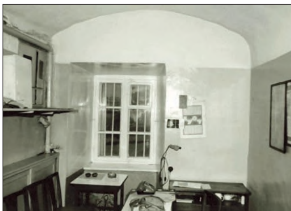
14. Pomieszczenie na parterze w środkowej części skrzydła wschodniego
