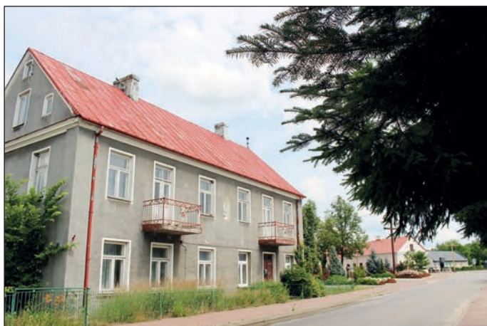
6. Komarówka Podlaska, budynek d. klasztoru, fot. M. Zieniewicz
