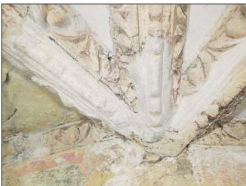
2. Detal sklepienia przed pracami, fot. L. Lawryniuk
