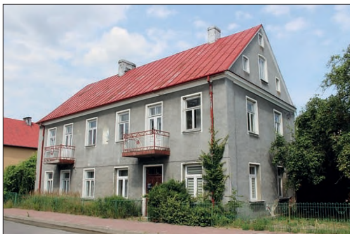
5. Komarówka Podlaska, budynek d. klasztoru, fot. M. Zieniewicz
