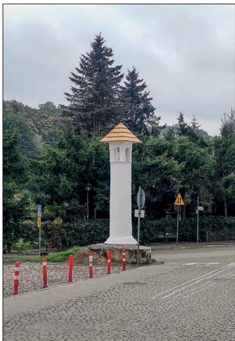
1. Kazimierz Dolny, kapliczka przy ul. Szkolnej, stan po remoncie dachu w l. 2021-22, fot. M. Kurczewicz, 2022
