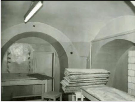
8. Pomieszczenie na parterze w skrzydle południowym
