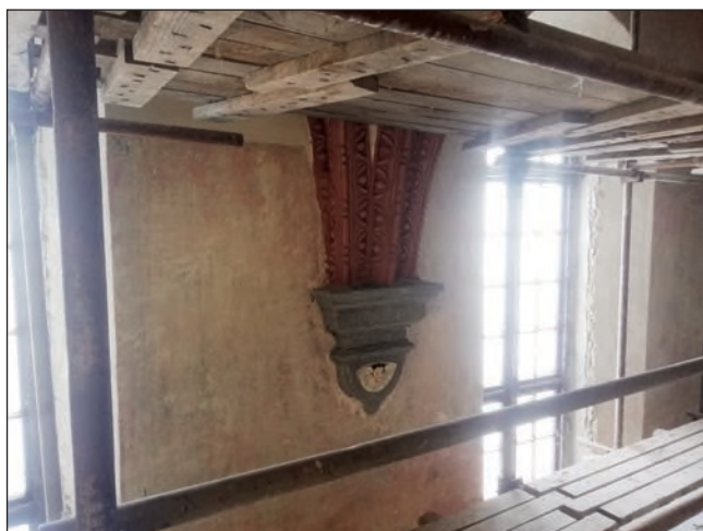
15. Fragment sklepienia w trakcie prac, fot. M. Jańczuk, 2023
