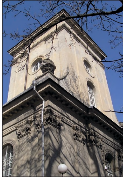
6. Elewacja kościoła przed remontem, fot. B. Stolarz
