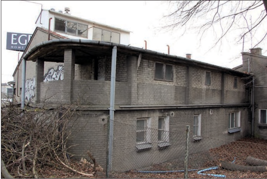
Fot. 3. Kotłownia B – widok od zachodu, 2023 r., K. Janus
