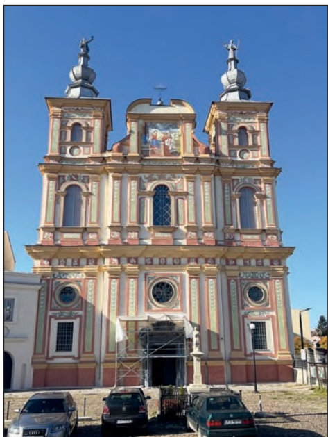
16. Elewacja frontowa kościoła, końcowy etap prac, fot. M. Filip, 2022
