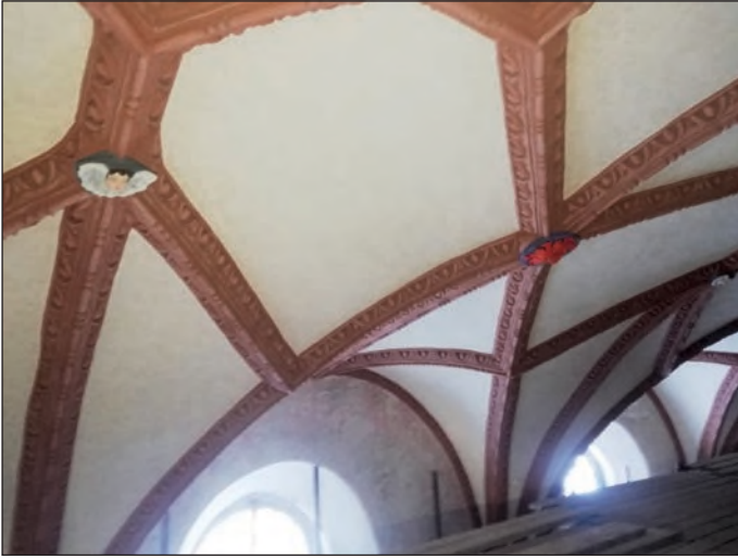
17. Fragment sklepienia w trakcie prac, fot. M. Jańczuk, 2023
