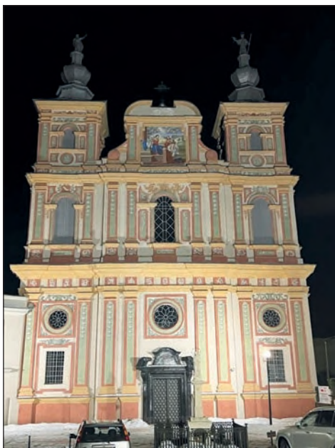
17. Elewacja frontowa kościoła po konserwacji, widok nocny, fot. M. Filip, 2022
