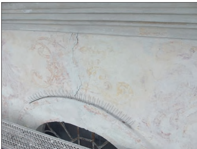
6. Oryginalna dekoracja malarska na elewacji frontowej po odsłonięciu i oczyszczeniu, fot. M. Filip, 2021
