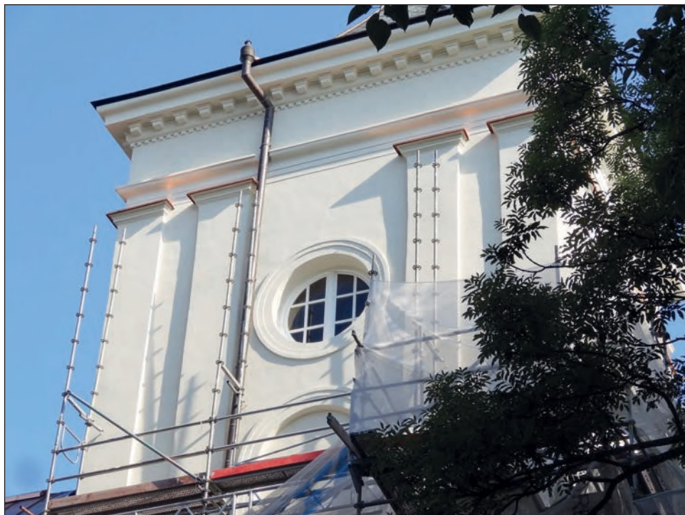
8. Wieża po remoncie, fot. B. Stolarz
