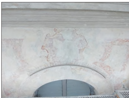
3. Oryginalna dekoracja malarska na elewacji frontowej po odsłonięciu i oczyszczeniu, fot. M. Filip, 2021
