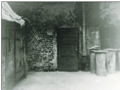
11. Dziedziniec kamienicy, widok ma ścianę zachodnią ze śladami łuku tęczowego
