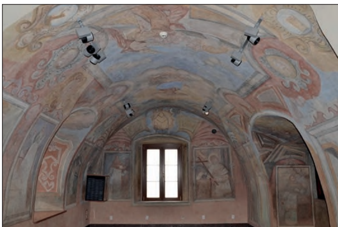
9. Kraśnik – kościół par., cz. wsch. oratorium po pracach, fot. M. Filip, 2023
