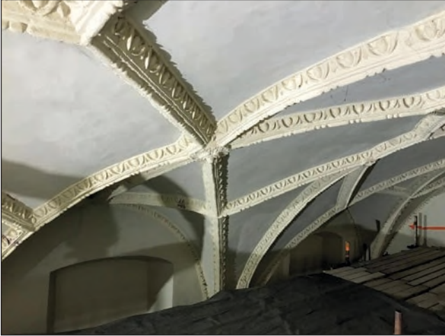
11. Detal sklepienia w trakcie prac, fot. L. Lawryniuk
