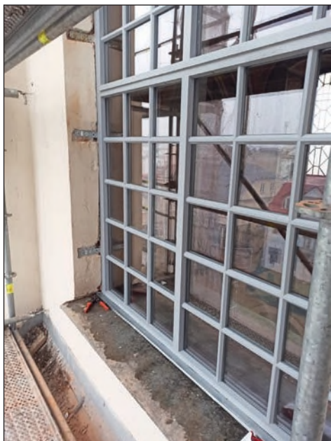
35. Zrekonstruowane okno elewacji bocznej, fot. M. Filip, 2022
