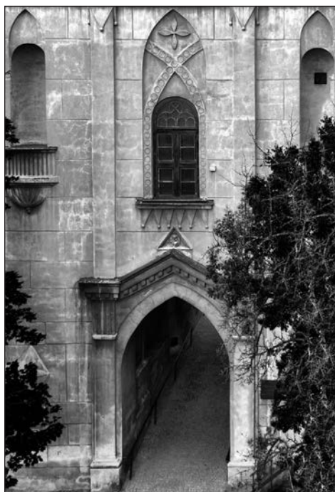
Il. 21 – Fragment elewacji Wieży Trynitaraskiej od strony placu katedralnego, fot. I. Marciszek, 2010 r.
