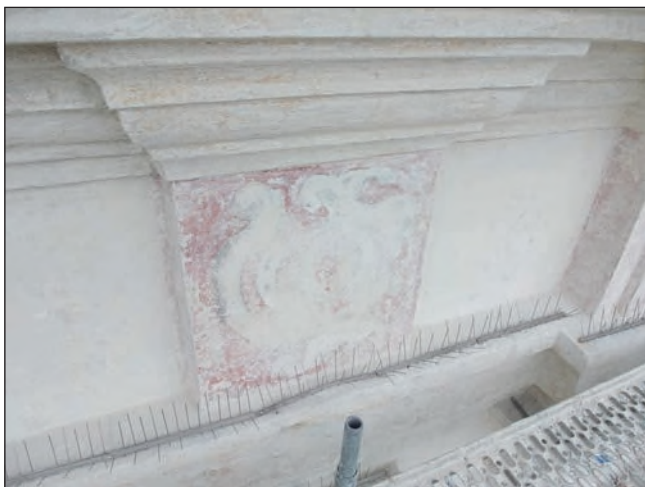
5. Oryginalna dekoracja malarska na elewacji frontowej po odsłonięciu i oczyszczeniu, fot. M. Filip, 2021
