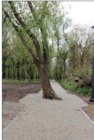
Fot. 15. Zastosowanie nawierzchni przepuszczalnej dającej możliwość zachowania drzewa. Zespół pałacowo-parkowy w Lubartowie (fot. B. Olszak, 2021 r.)
