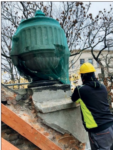
10. Wazon przygotowany do demontażu, fot. B. Stolarz
