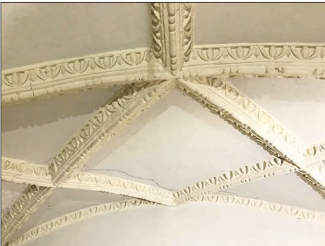
13. Detal sklepienia w trakcie prac, fot. L. Lawryniuk
