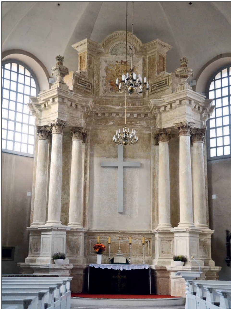
19. Ołtarz w trakcie prac konserwatorskich, fot. K. Tur-Marciszek
