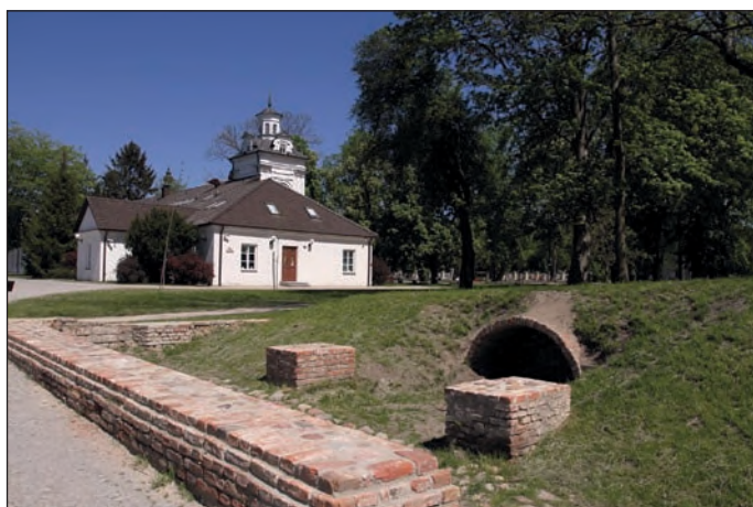
23. Biała Podlaska – zespół zamkowy, pozostałości budynku gospodarczego, w głębi oficyna zach., fot. J. Maraśkiewicz, 2022
