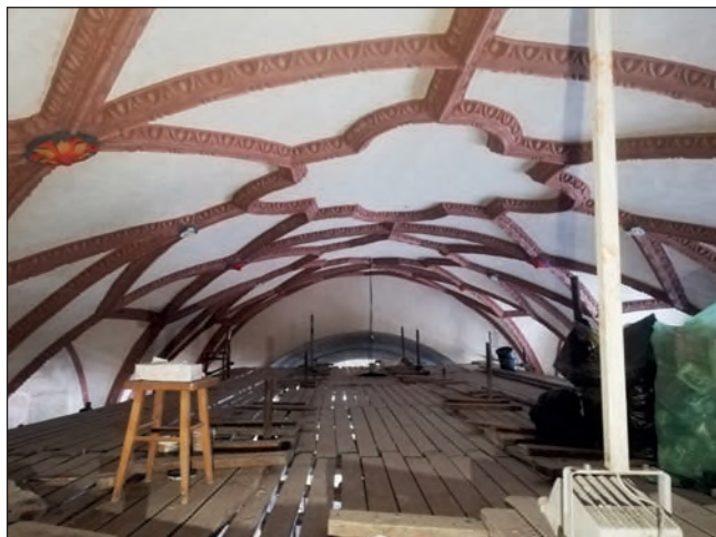
14. Fragment sklepienia w trakcie prac, fot. M. Jańczuk, 2023
