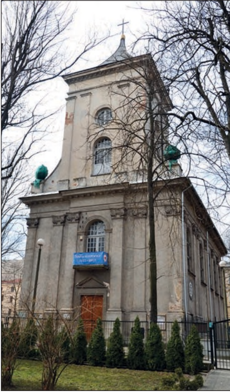
5. Elewacja kościoła przed remontem, fot. B. Stolarz
