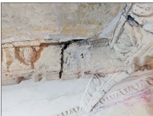
3. Detal sklepienia przed pracami, fot. L. Lawryniuk
