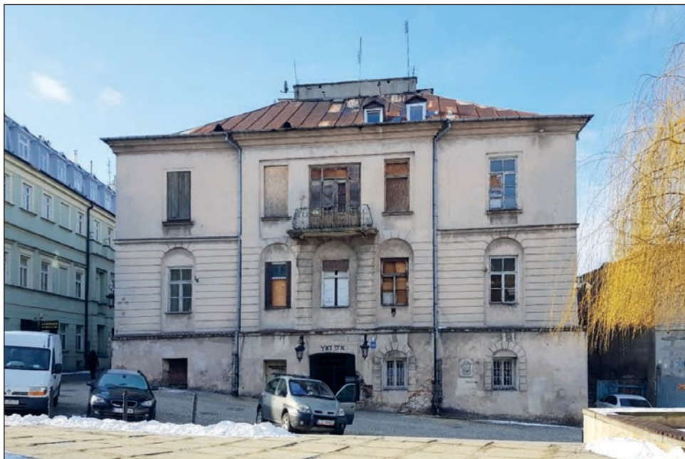
1. Pałac Pawęczkowskiego, elewacja wschodnia od Placu Rybnego
