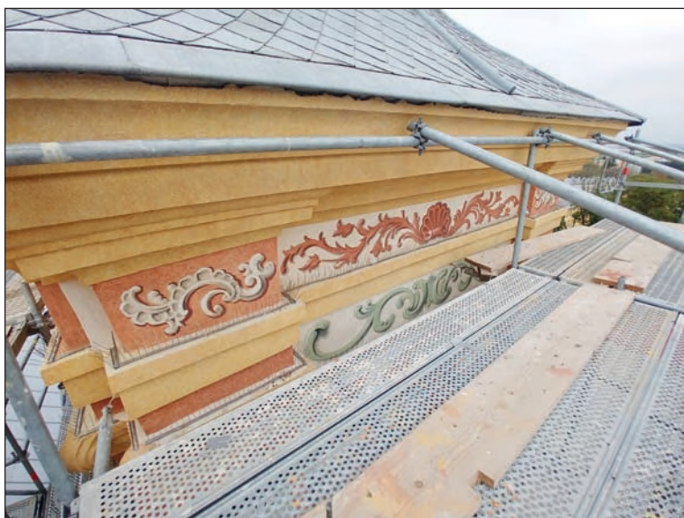
12. Dekoracja malarska elewacji w trakcie scalania kolorystycznego, fot. M. Filip, 2021
