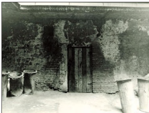
12. Dziedziniec, widok na ścianę północną ze śladami arkady
