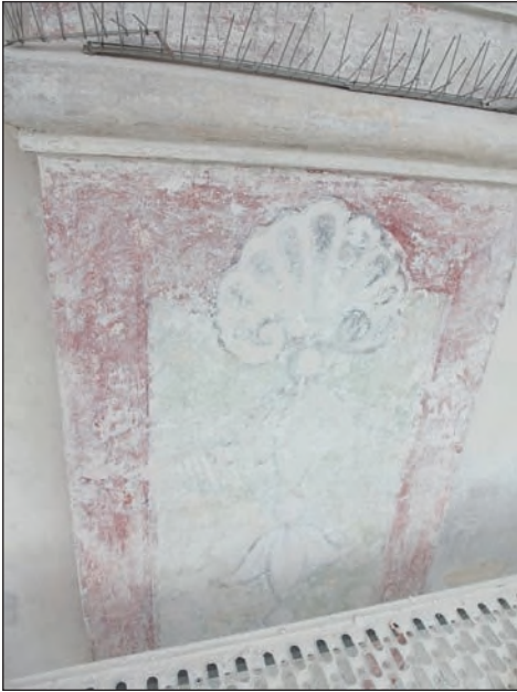
7. Oryginalna dekoracja malarska na elewacji frontowej po odsłonięciu i oczyszczeniu, fot. M. Filip, 2021.
