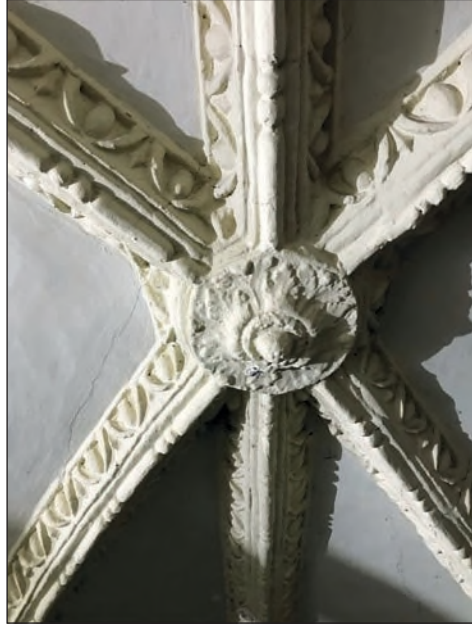
6. Detal sklepienia w trakcie prac, fot. L. Lawryniuk
