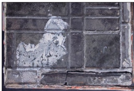
Fot. 6. Fragment kwatery z witraża, widoczna powierzchnia kwatery zakurzona i zachłapana mleczkiem cementowym, fot. K. Kuchno, 2021
