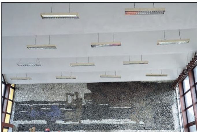
2. Lublin, hala główna dworca PKS – wnętrze, fot. M. Zieniewicz
