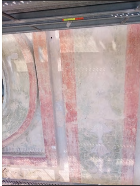
8. Oryginalna dekoracja malarska na elewacji frontowej po odsłonięciu i oczyszczeniu, fot. M. Filip, 2021
