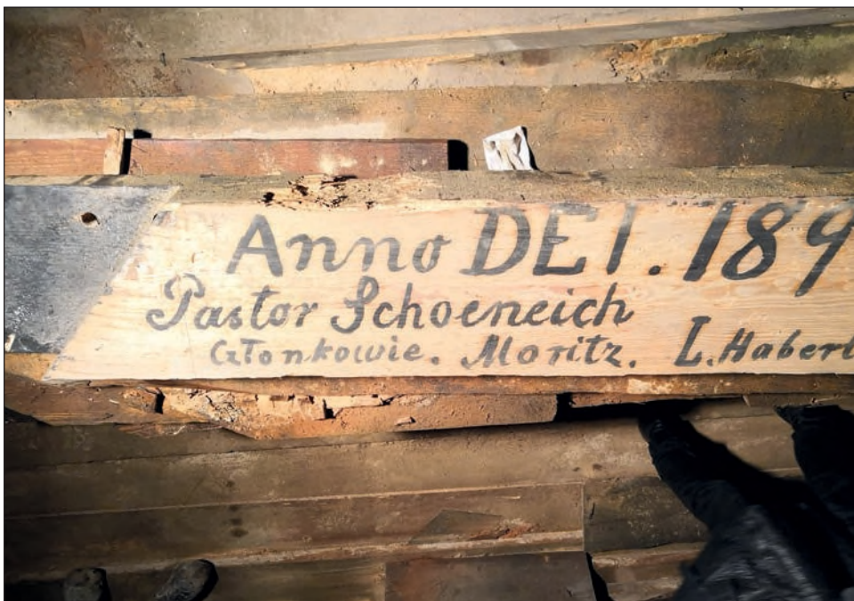
27. Belka dachowa z datą remontu kościoła z podpisem Pastora i członków Rady Parafialnej, fot. Wykonawca prac
