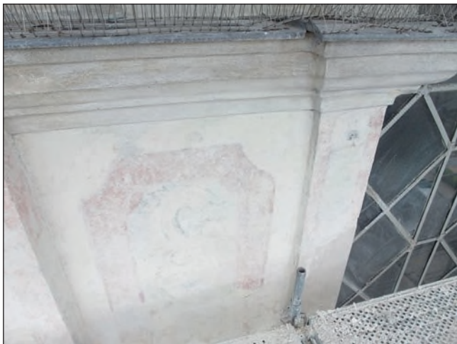
4. Oryginalna dekoracja malarska na elewacji frontowej po odsłonięciu i oczyszczeniu, fot. M. Filip, 2021
