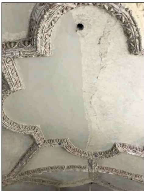
9. Detal sklepienia w trakcie prac, fot. L. Laryniuk
