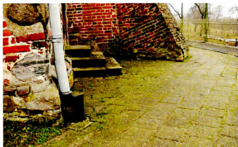
Ryc. 5. Ten gotycki kościół jest położony na pagórku, który od strony wschodniej ostrą, pionową skarpią (kilkunastometrowej wysokości) opada ku drodze. Wzdłuż ściany południowej kościół zachował oryginalne opracowanie terenu – spadek i trawę. Chodnik położony pod koniec lat 70. lub w latach 80. XX w. jest na tyle niski, że nie zatrzymuje większych ilości wody. Ściana jest sucha. Fot. B.J. Rouba
