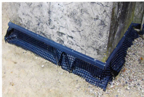
Ryc. 15. Rok 2012 – owijanie sztywną folią fundamentów kościoła zbudowanych z olbrzymich głazów narzutowych. Tak ułożona folia będzie zatrzymywać i uniemożliwiać odparowanie wody, a jeśli w ramach prac spoiny wypełniono zaprawą, to stworzy warunki do wędrowki wody w górę i w rezultacie zwiększy zawilgocenie kościoła. Pokazany tu przypadek nie jest niestety odosobniony! Fot. B.J. Rouba
