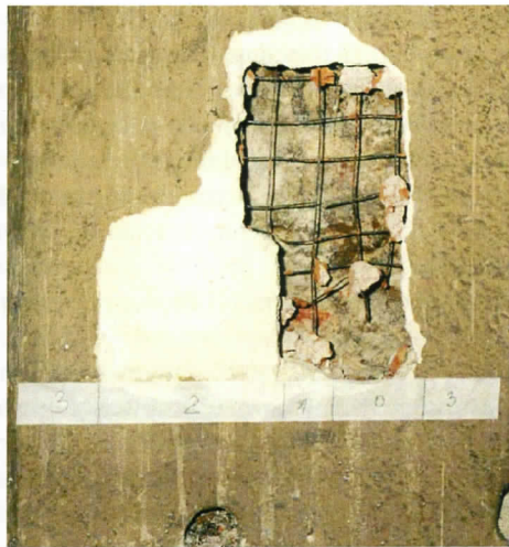
Ryc. 10. W kościele katedralnym w Zielonej Górze ekrany wentylacyjne wykonane zostały (również przed II wojną) z kształtek ceramicznych na siat- ce drucianej, pokrytych następnie tynkiem. Fot. M. Kiepuszewska
