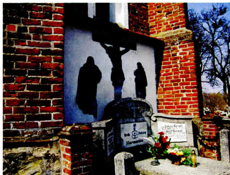
Ryc. 4. W tym samym kościele na ścianie wschodniej znajduje się XIX-wieczna grupa Ukrzyżowania malowana na blasze. Woda skapująca z osłaniającego ją daszku trafia latami dokładnie na nagrobek zasłużonej rodziny dobrodziejów kościoła i fundatorów grupy Ukrzyżowania . Najintensywniejsze zniszczenia ściany i postaci powstałe w wyniku uderzeń kropli odbijanych od twardego kamienia układają się w kształt łuku, powtarzającego dokładnie łuk górnej części nagrobka. Fot. B.J. Rouba
