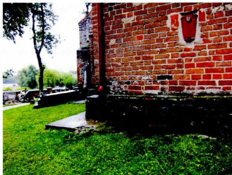
Ryc. 2. Kościół znajduje się na wzniesieniu, a najbliższy teren opada „od ścian”, jednak pozytywny efekt jest całkowicie niwelowany działaniem opaski odpornej za odbijanie i narzucanie wody na ściany, skąd poprzez zaprawę migruje ona do wnętrza, stanowiąc trzeci element procesu zawilgocenia gotyckiej budowli. Popękane rynny, zbyt krótkie rury spustowe zakończone równie krótkimi kolankami oraz brak rynsztoków przejmujących i odprowadzających wodę szybko od kościoła – to czwarty element zwiększający zawilgocenie. Także źle rozwiązane odprowadzanie wody z dachu zakrystii, moczenie ścian i rozrost glonów pogarszają stan kościoła. Widoczna na fotografii sytuacja sprawiła, że doszło już najprawdopodobniej do rozmiękczenia gruntu pod narożnikiem zakrystii, o czym świadczy głębokie pęknięcie widoczne na północnym cokole, na fotografii z prawej strony. Fot. B.J. Rouba
