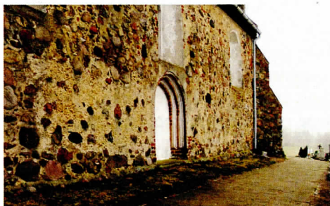
Ryc. 5. Ten gotycki kościół jest położony na pagórku, który od strony wschodniej ostrą, pionową skarpią (kilkunastometrowej wysokości) opada ku drodze. Wzdłuż ściany południowej kościół zachował oryginalne opracowanie terenu – spadek i trawę. Chodnik położony pod koniec lat 70. lub w latach 80. XX w. jest na tyle niski, że nie zatrzymuje większych ilości wody. Ściana jest sucha. Fot. B.J. Rouba
