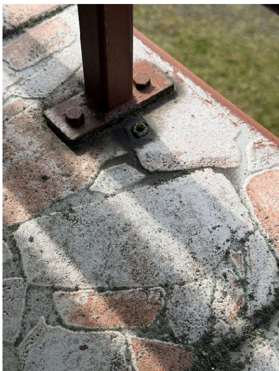
Zdj. nr 6 i 7 – korozja elementów metalowych balustrady
