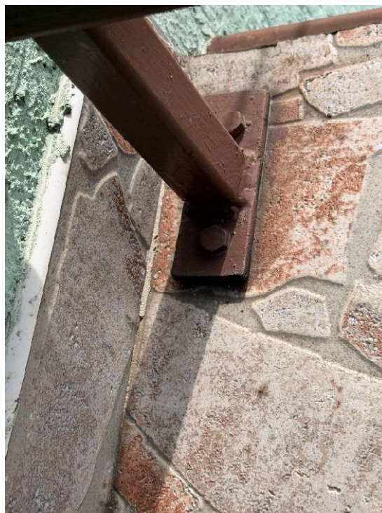
Zdj. nr 6 i 7 – korozja elementów metalowych balustrady
