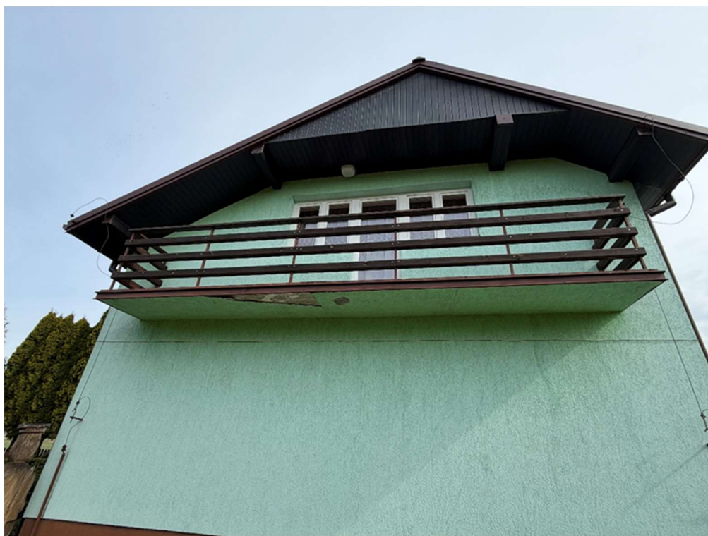
Zdj. nr 1 – widok elewacji południowo-zachodniej z balkonem
