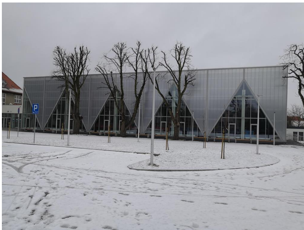
Fot. nr 11. Sala gimnastyczna Liceum Ogólnokształcącego Nr I im. mjr Henryka Sucharskiego w Kępnie.
