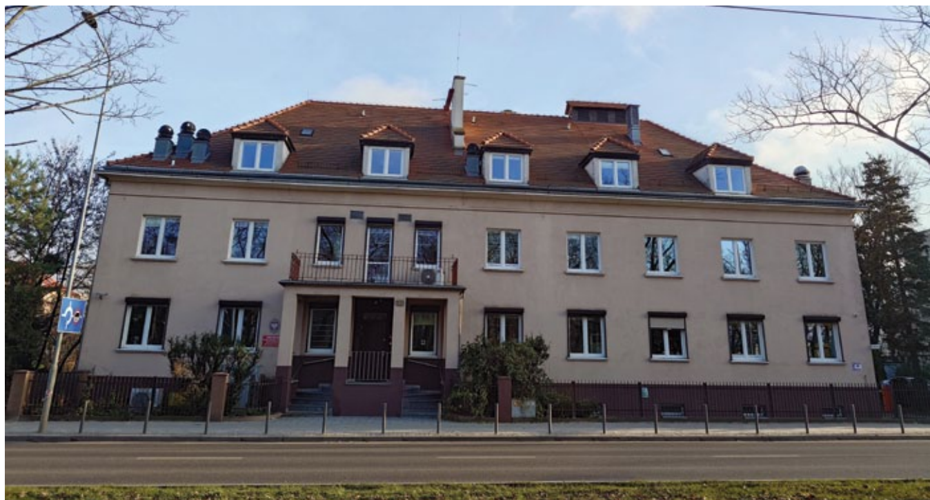
Budynek Laboratorium w Poznaniu
