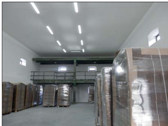
1. Wnętrze dawnego spichlerza z pozostawionym fragmentem drewnianej konstrukcji, fot. E. Podkościelny, 2014.
