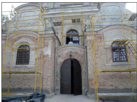
4. Wymiana tynków na przybudówkach w elewacji frontowej, fot. St. Rudnik, 2012.
