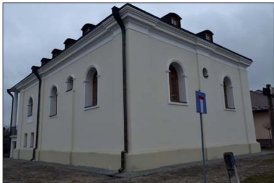
1. Elewacje synagogi po pracach konserwatorskich, fot. D. Kopciowski, 2015.
