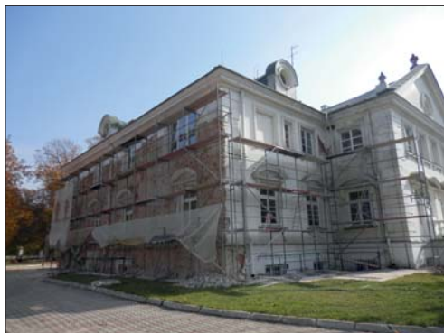
4. Elewacja boczna (od płn.) w trakcie prac konserwatorskich, fot. A. Kasiborski, 2013.
