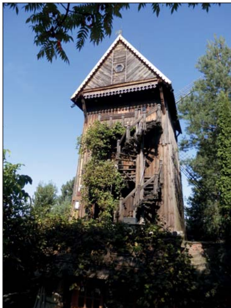
35. Męcierz, wiatrak z Osin, obiekt po remoncie dachu, fot. K. Zarzycka-Goliszek, 2014.
