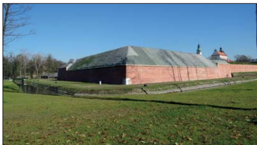
7. Zamość, Bastion III, stan po zakończeniu prac przy murach bastionu, fot. E. Furlepa, 2015.
