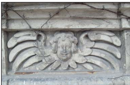
29. Lublin, kościół oo dominikanów, kaplica Firlejów-detale przed pracami, fot. M. Filip, 2014.
