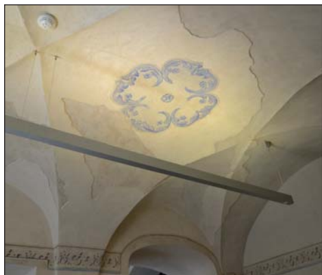
22. Lublin, kamienica Grodzka 30, wystrój malarski pomieszczeń na parterze, po konserwacji, fot. A. Frąckiewicz, 2014.
