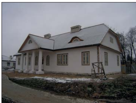
18. Krasnystaw, dwór w zespole dworsko-folwarcznym, ul. Sikorskiego 10, stan w trakcie prac, fot. S. Rudnik, 2014.
