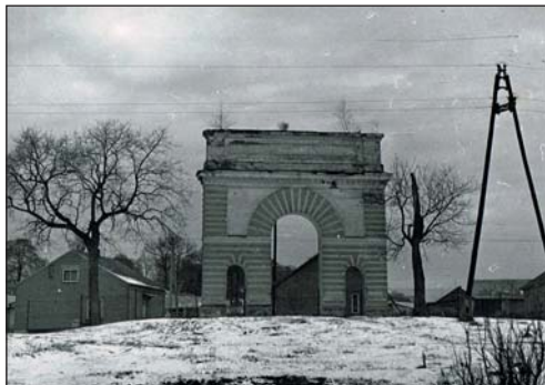
3. Łuk triumfalny na zakończeniu alei głównej, stan z 1973 r. (w archiwum WUOZ w Lublinie).
