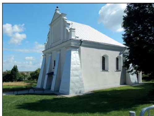
52. Podgórze, kościół rzymskokatolicki pw. Chrystusa Pana Zbawiciela, stan po wykonaniu prac, fot. M. Pędzińska, 2014.
