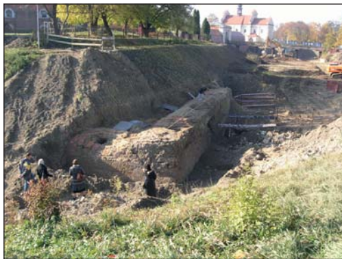
1. Zamość, Bastion VI, fragment muru słoni- czoła, stan w trakcie odsłonięcia, fot. L. Ku- śmierz, 2011.
