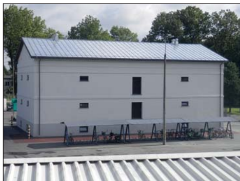
3. Elewacje spichlerza po pracach remontowych, fot. E. Podkościelny, 2014.
