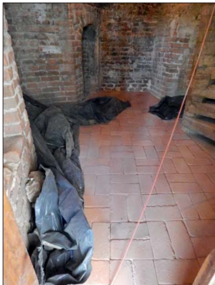
48. Orchówek, kościół parafialny pw. św. Jana Jaluźnika – dzwonnica, stan w trakcie remontu, fot. M. Pędzińska, 2014.
