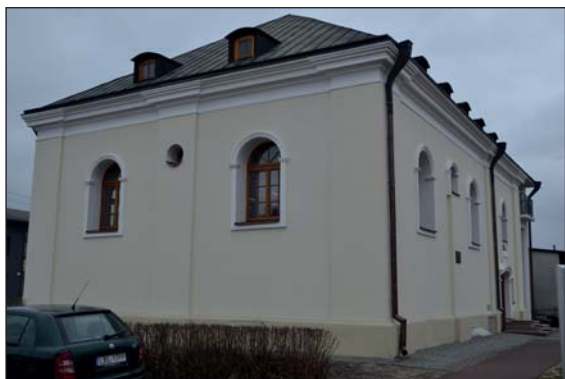
2. Elewacje synagogi po pracach konserwatorskich, fot. D. Kopciowski, 2015.
