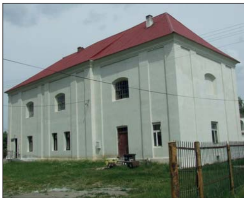
34. Mełgiew, budynek starego kościoła parafialnego – po remoncie elewacji, fot. J. Matys, 2015.
