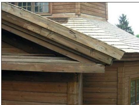
6. Borowica, kościół pw. Przemienienia Pańskiego w trakcie prac konserwacyjnych i zabezpieczających pokrycie dachowe, fot. S. Rudnik, 2014.
