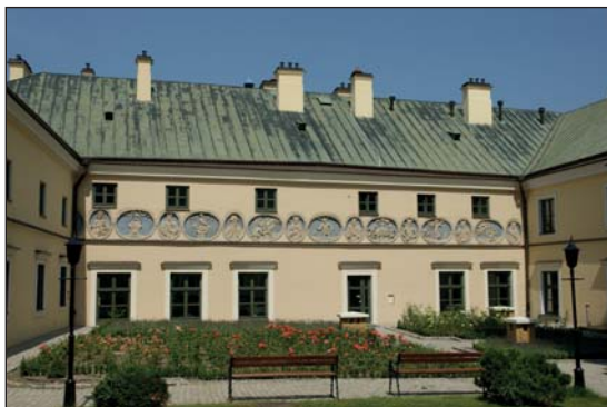
5. Elewacja dawnego pałacu Suchorabskich-Radziwiłłów (obecnie Metropolitalne Seminarium Duchowne) od strony dziedzińca – po pracach konserwatorskich, fot. D. Kopciowski, 2014.
