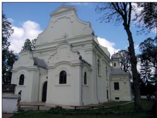
8. Widok kościoła od strony pld.-zach. po pracach remontowych, fot. St. Rudnik, 2014.
