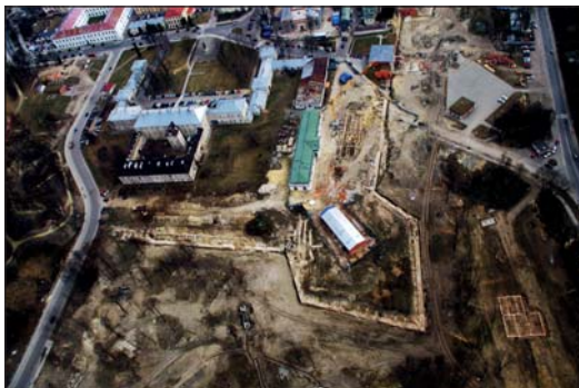
Fot. 9. Zdjęcie lotnicze Bastionu III w trakcie robót budowlanych i badań archeologicznych (fot. K. Garbula, 2012).
