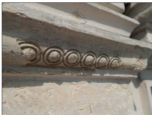
61. Wojsławice, kościół rzymskokatolicki pw. św. Michała Archanioła, stan w trakcie prowadzenia prac przy kaplicach bocznych, fot. S. Rudnik, 2014.
