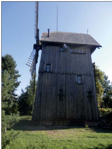
36. Męcierz, wiatrak z Osin, obiekt po remoncie dachu, fot. K. Zarzycka-Goliszek, 2014.
