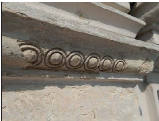
6. Elementy dekoracyjnego gzymsu odsłonięte w trakcie prac konserwatorskich przy detalu architektonicznym, fot. St. Rudnik, 2014.
