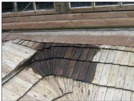
7. Borowica, kościół pw. Przemienienia Pańskiego w trakcie prac konserwacyjnych i zabezpieczających pokrycie dachowe, fot. S. Rudnik, 2014.
