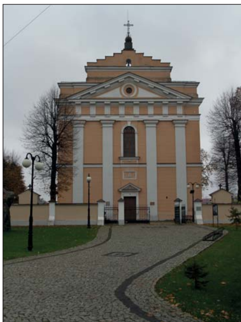
37. Miedzyrzec Podlaski – kościół pw. św. Mikołaja, stan przed remontem, fot. J. Maraśkiewicz, 2013.
