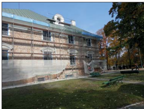
6. Elewacja boczna (od płd.), w trakcie prac konserwatorskich, fot. A. Kasiborski, 2013.
