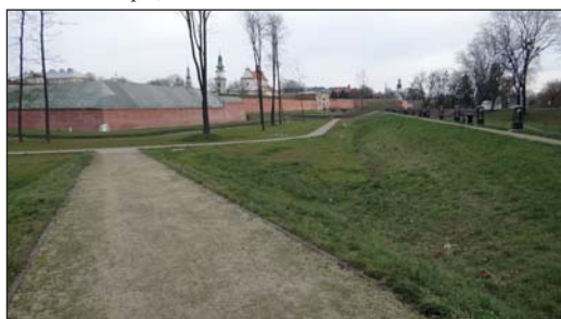
13. Zamość, widok ogólny południowego narysu po pracach, fot. E. Furlepa, 2015.
