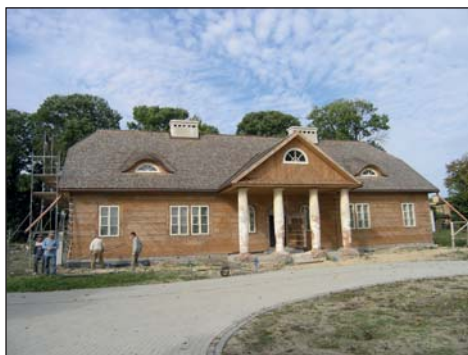
19. Krasnystaw, dwór w zespole dworsko-folwarcznym, ul. Sikorskiego 10, stan w trakcie prac, fot. S. Rudnik, 2014.
