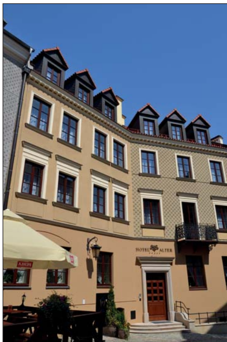
21. Lublin, kamienica Grodzka 30, elewacja frontowa po remoncie, fot. A. Frąckiewicz, 2014.
