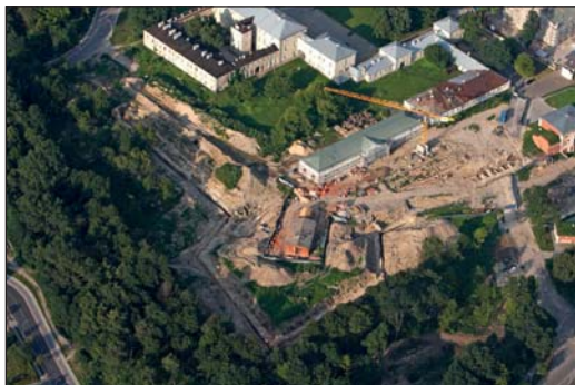
10. Zamość, Obiekt pod wałem, stan w trakcie odsłonięcia reliktyw, fot. W. Lipiec, 2011, archiwum UM Zamość.
