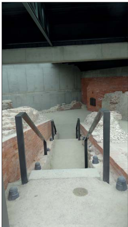
6. Zamość, Bastion, lapidarium, stan po zakończeniu prac, wewnątrz, fot. E. Furlepa, 2015.
