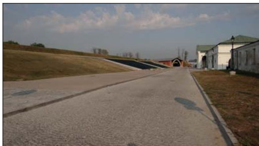
9. Zamość, Obiekt pod wałem, stan po zakończeniu prac, fot. E. Furlepa, 2015.
