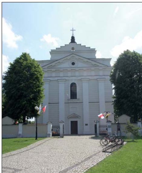
39. Miedzyrzec Podlaski – kościół pw. św. Mikołaja, stan po remoncie, fot. J. Maraśkiewicz, 2014.
