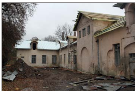
42. Miedzyrzec Podlaski – stajnia w zespole pałacowo-parkowym, w trakcie prac remontowych, fot. J. Maraśkiewicz, 2013.
