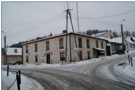
2. Budynek Urzędu Gminy w Janowcu, po odsłonięciu kamiennego lica elewacji, fot. D. Kopciowski, 2012.
