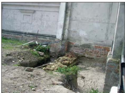
2. Prace przy izolacji fundamentów kościoła. Widoczny fragment muru budowli przylegającej do kościoła od strony płu.-wsch. Fot. B. Kruk, 2011.
