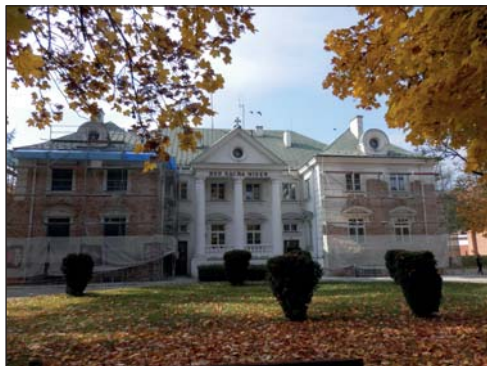
5. Elewacja frontowa (od wsch.), w trakcie prac konserwatorskich, fot. A. Kasiborski, 2013.
