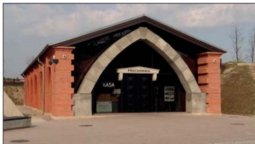
12. Zamość, Prochownia, stan po zakończeniu prac, fot. E. Furlepa, 2015.
