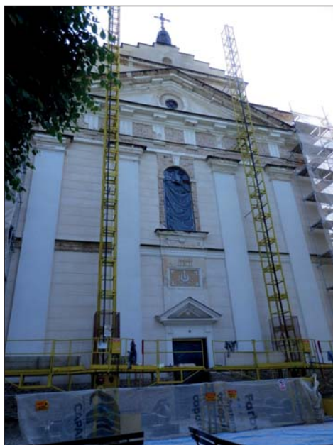
38. Miedzyrzec Podlaski – kościół pw. św. Mikołaja, w trakcie prac remontowych, fot. J. Maraśkiewicz, 2014.
