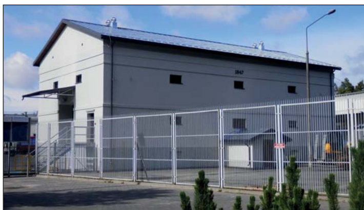
4. Spichlerz po pracach remontowych, fot. E. Podkościelny, 2014.
