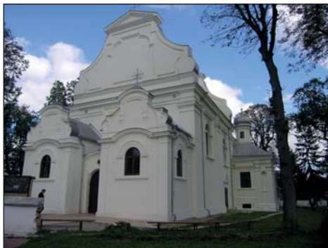
58. Wojsławice, kościół rzymskokatolicki pw. św. Michała Archanioła, widok elewacji frontowej, stan po zakończeniu robót, fot. S. Rudnik, 2014.
