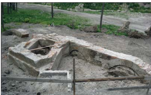
Fot. 13. Murowane konstrukcje i przepust w rawelinie kurtyny II-III na wysokości Arsenału (fot. H. Szkutnik – Muzeum Zamojskie w Zamościu).
