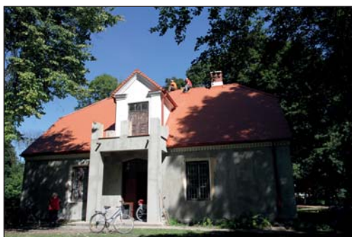
54. Siemień – dwór, w trakcie prac remontowych, fot. J. Maraśkiewicz, 2014.
