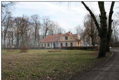
53. Siemień – dwór, stan przed remontem, fot. J. Maraśkiewicz, 2013.
