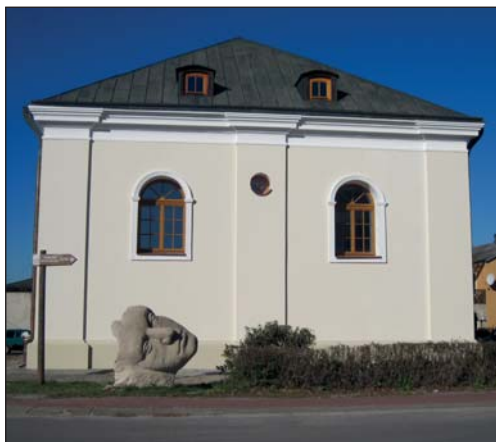
17. Józefów – bożnica, stan po remoncie, fot. M. Fornal, 2015.
