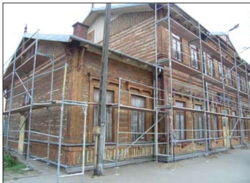
44. Minkowice, dworzec kolejowy, budynek przed remontem, fot. K. Zarzycka-Goliszek, 2014.
