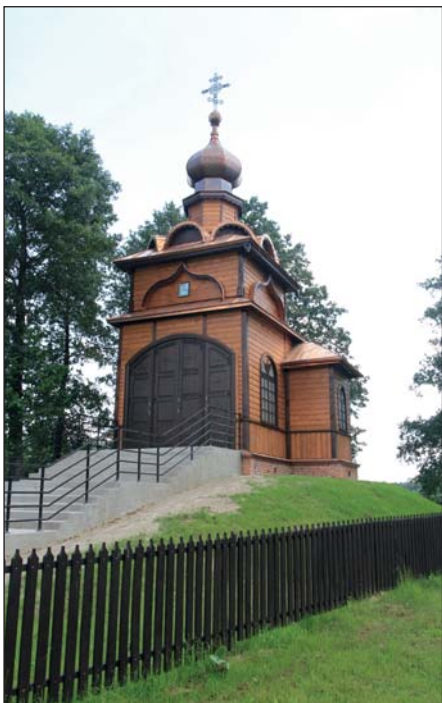
16. Jabłeczna – kaplica pw. św. Ducha w założeniu klasztorным, po pracach remontowych, fot. J. Maraśkiewicz, 2014.
