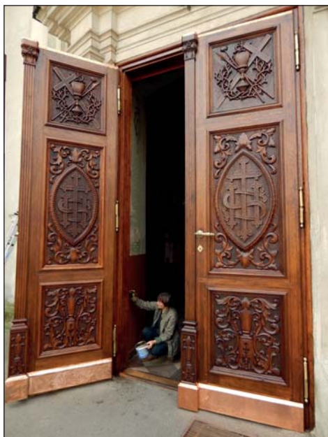
4. Drzwi, stan po konserwacji. Kończenie prac przy futrynie, fot. P. Wira, 2014.
