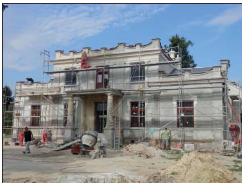
13. Dys Bernatówka, dwór, stan w trakcie remontu, fot. M. Kurczewicz, 2014.
