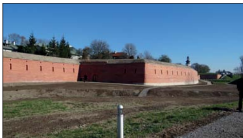
3. Zamość, Bastion II, stan po zakończeniu prac, fot. E. Furlepa, 2015.
