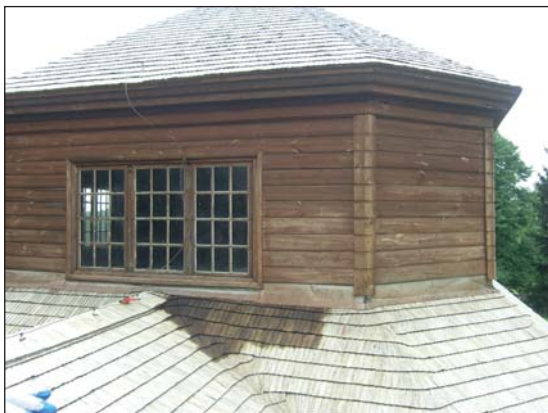
5. Borowica, kościół pw. Przemienienia Pańskiego w trakcie prac konserwacyjnych i zabezpieczających pokrycie dachowe, fot. S. Rudnik, 2014.
