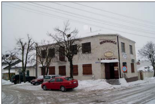
1. Dom chleba przy Rynku w Janowcu, po pracach związanych z odsłonięciem kamiennego lica elewacji, fot. D. Kopciowski, 2012.
