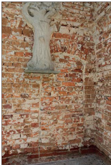
5. Leśna Podlaska – zespół klasztorny oo. Paulinów, kaplica Zjawienia, pd. elewacja prezbiterium, fot. J. Maraśkiewicz, 2014.
