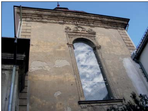
27. Lublin, kościół oo dominikanów, kaplica Firlejów przed pracami, fot. M. Filip, 2014.
