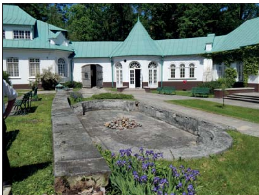
1. Adamów, pałac Zamoyskich, fontanna i mury oporowe, stan przed remontem, fot. S. Rudnik, 2014.
