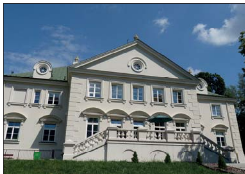
8. Elewacja ogrodowa (od zach.), stan zakończeniu prac remontowo-konserwatorskich, fot. A. Kasiborski, 2014.
