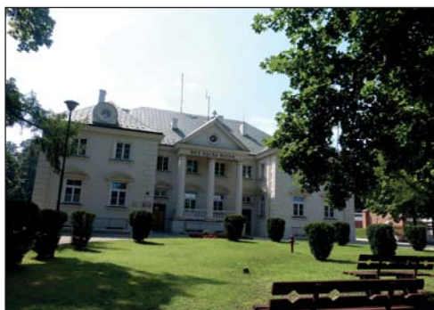
7. Elewacja frontowa (od wsch.), stan zakończeniu prac remontowo-konserwatorskich, fot. A. Kasiborski, 2014.
