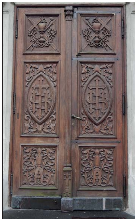
2. Drzwi główne, stan przed konserwacją, fot. P. Wira, 2014.
