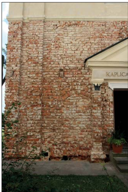
7. Leśna Podlaska – zespół klasztorny oo. Paulinów, kaplica Zjawienia, elewacja wsch., część pd., fot. J. Maraśkiewicz, 2014.
