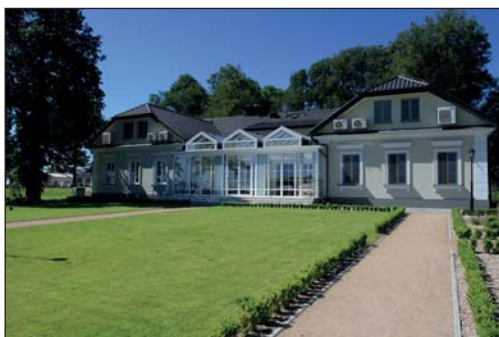
11. Droblin - dwór, po pracach remontowych, fot. J. Maraśkiewicz, 2014.
