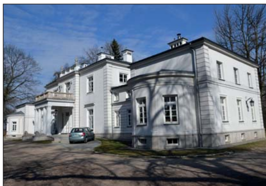
3. Pałac w Czesławicach po pracach konserwatorskich, fot. D. Kopciowski, 2014.
