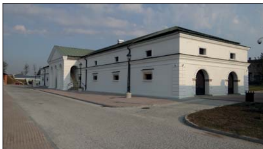
8. Zamość, Arsenal, stan po zakończeniu prac, fot. E. Furlepa, 2015.
