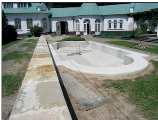
2. Adamów, pałac Zamoyskich, remont fontanny i murów oporowych, stan w trakcie robót, fot. S. Rudnik, 2014.
