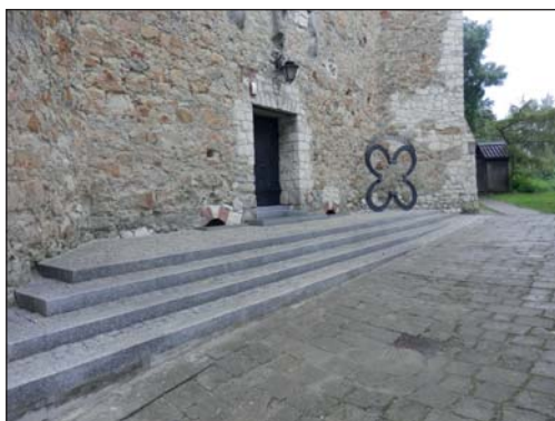
55. Wojciechów, wieża arińska, schody boczne po remoncie, fot. M. Kurczewicz, 2014.
