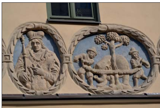
6. Jeden z medalionów na elewacji dawnego pałacu Suchorabskich-Radziwiłłów, po pracach konserwatorskich, fot. D. Kopciowski, 2014.
