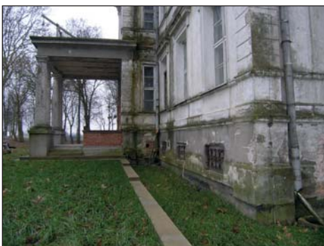
8. Chylin, założenie dworsko-parkowe, stan po wykonaniu muru oporowego, fot. S. Rudnik, 2014.
