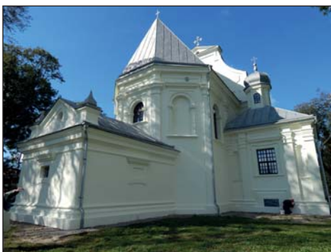
60. Wojsławice, kościół rzymskokatolicki pw. św. Michała Archanioła, stan po pracach, fot. S. Rudnik, 2014.
