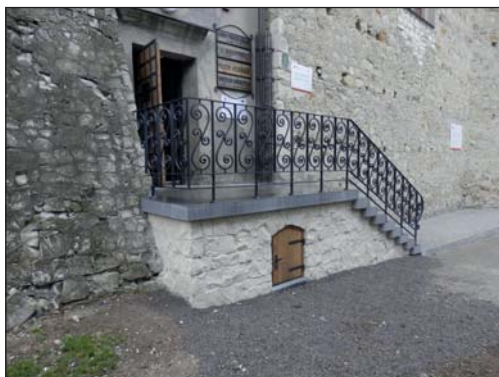
56. Wojciechów, wieża arińska, schody główne po remoncie, fot. M. Kurczewicz, 2014.
