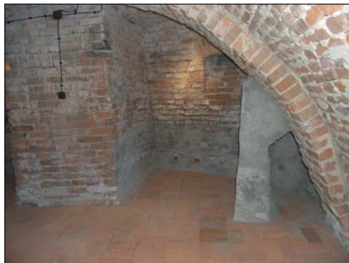
49. Orchówek, kościół parafialny pw. św. Jana Jaluźnika – pomieszczenia podziemia, stan po remoncie, fot. M. Pędzińska, 2014.
