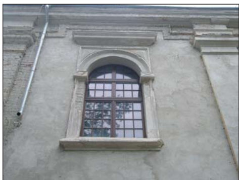
3. Fragment elewacji bocznej podczas prac remontowych.
