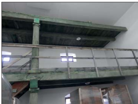
2. Fragment zachowanej drewnianej konstrukcji, fot. E. Podkościelny, 2014.
