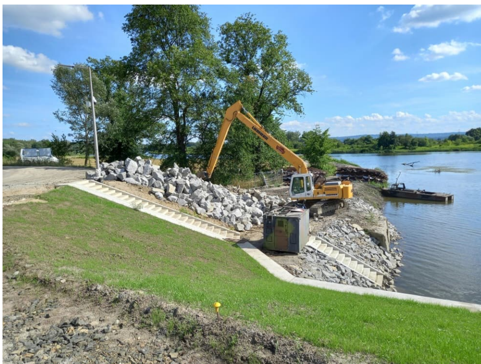
Foto. 42. Narzut kamienny do ubezpieczania dna i skarp kanału portu Kujawy, stan w trzeciej dekadzie lipca 2023 r. (widok w kierunku południowym).
