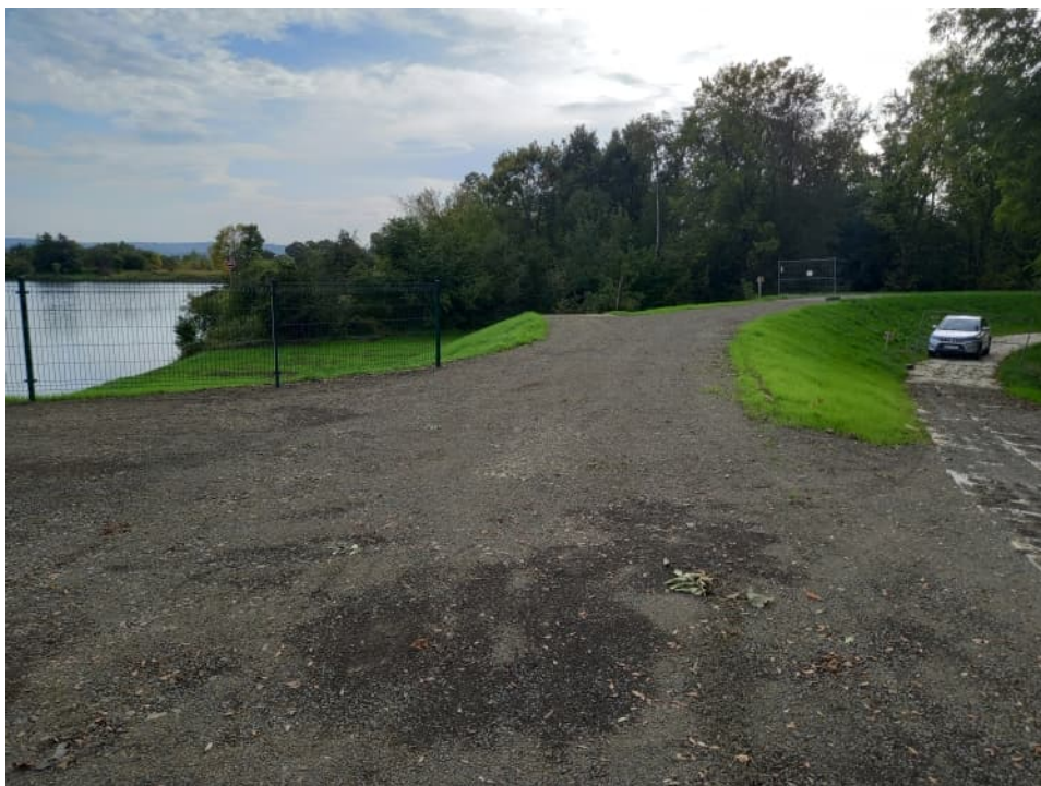
Foto. 52. Stan terenu budowy w pierwszym miesiącu okresu zgłaszania wad – wał przeciwpowodziowy na zachodnim brzegu kanału portu Kujawy, stan w drugiej dekadzie października 2023 r. (widok w kierunku południowym).
