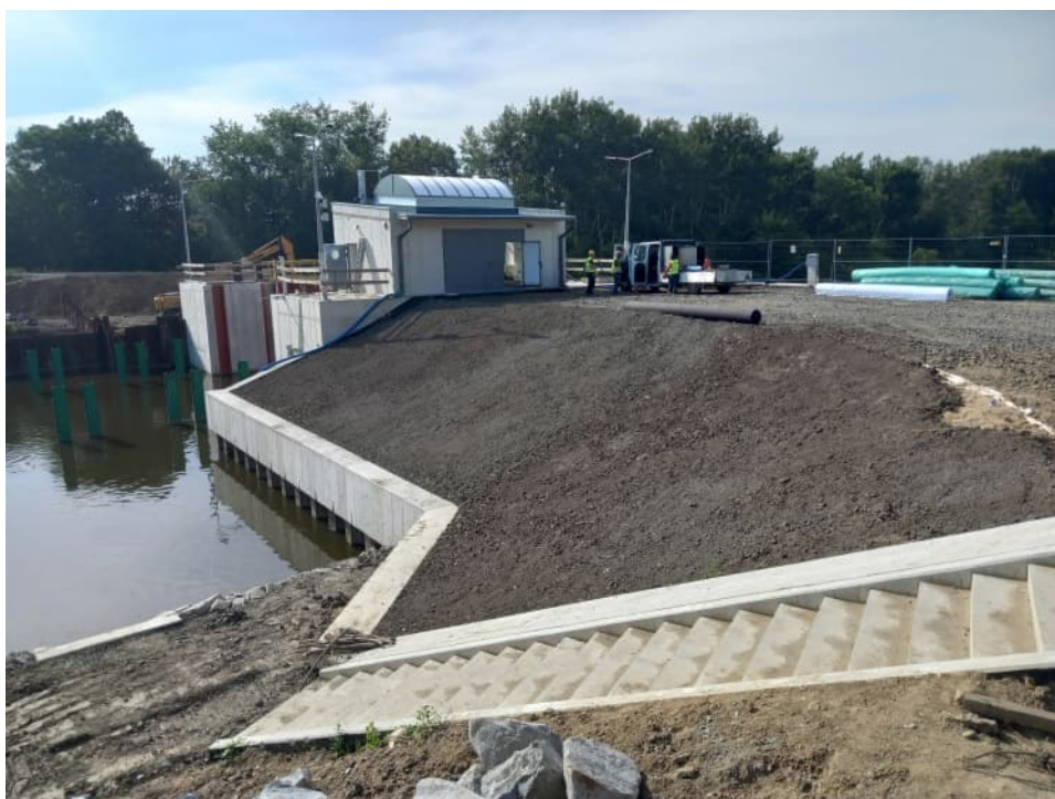
Foto. 34. Teren budowy bramy przeciwpowodziowej i dowiązania wału na wschodnim brzegu kanału portu Kujawy, stan w drugiej dekadzie lipca 2023 r. (widok w kierunku zachodnim).
