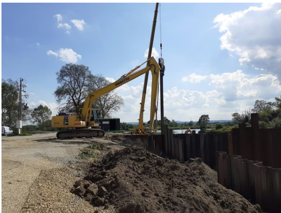
Foto. 28. Pograżanie ścianek szczelnych w korycie kanału portu Kujawy, stan w trzeciej dekadzie sierpnia 2022 r. (widok w kierunku południowym).
