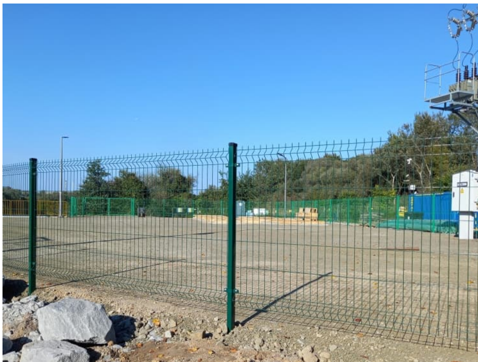
Foto. 48. Ogrodzenie placu manewrowego na wschodnim brzegu kanału portu Kujawy, stan w trzeciej dekadzie września 2023 r. (widok w kierunku północno-wschodnim).
