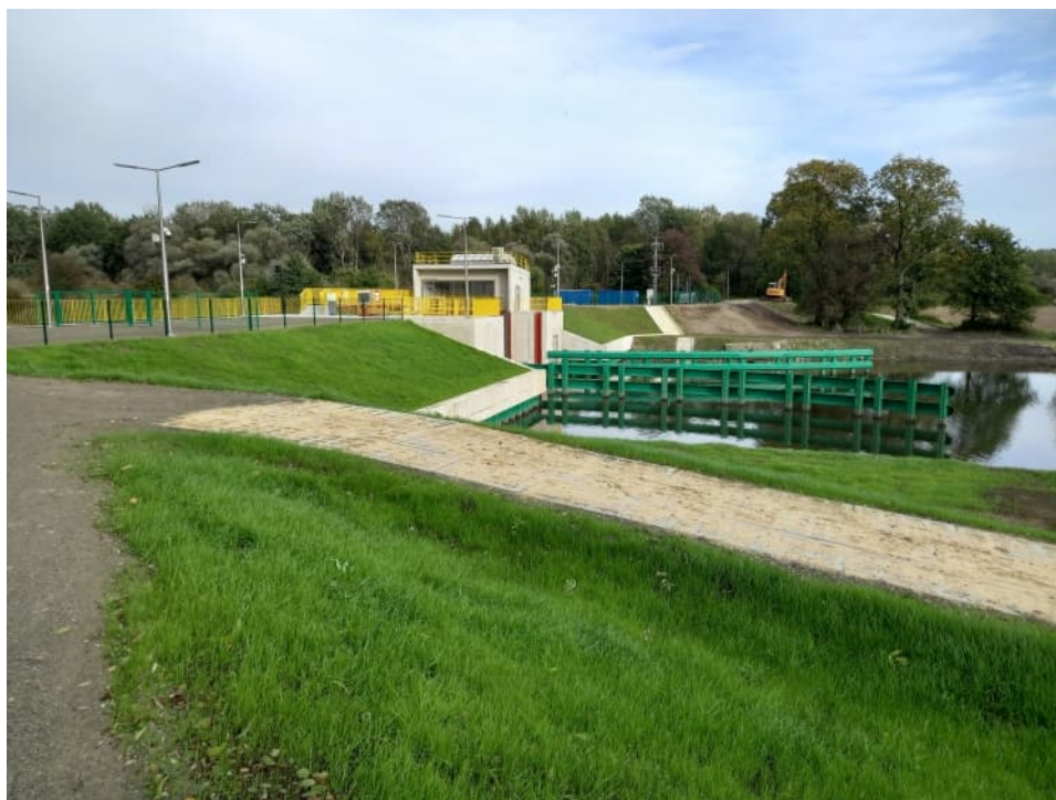
Foto. 53. Stan terenu budowy w pierwszym miesiącu okresu zgłaszania wad – brama przeciwpowodziowa na kanale portu Kujawy – część południowa, stan w drugiej dekadzie października 2023 r. (widok w kierunku wschodnim).
