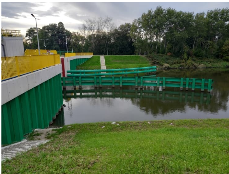
Foto. 58. Stan terenu budowy w pierwszym miesiącu okresu zgłaszania wad – brama przeciwpowodziowa na kanale portu Kujawy – część północna, stan w drugiej dekadzie października 2023 r. (widok w kierunku zachodnim).
