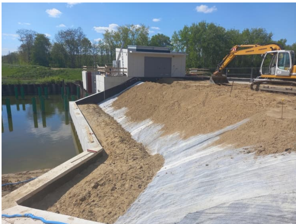
Foto. 33. Teren budowy bramy przeciwpowodziowej i dowiązania wału na wschodnim brzegu kanału portu Kujawy, stan w drugiej dekadzie maja 2023 r. (widok w kierunku zachodnim).
