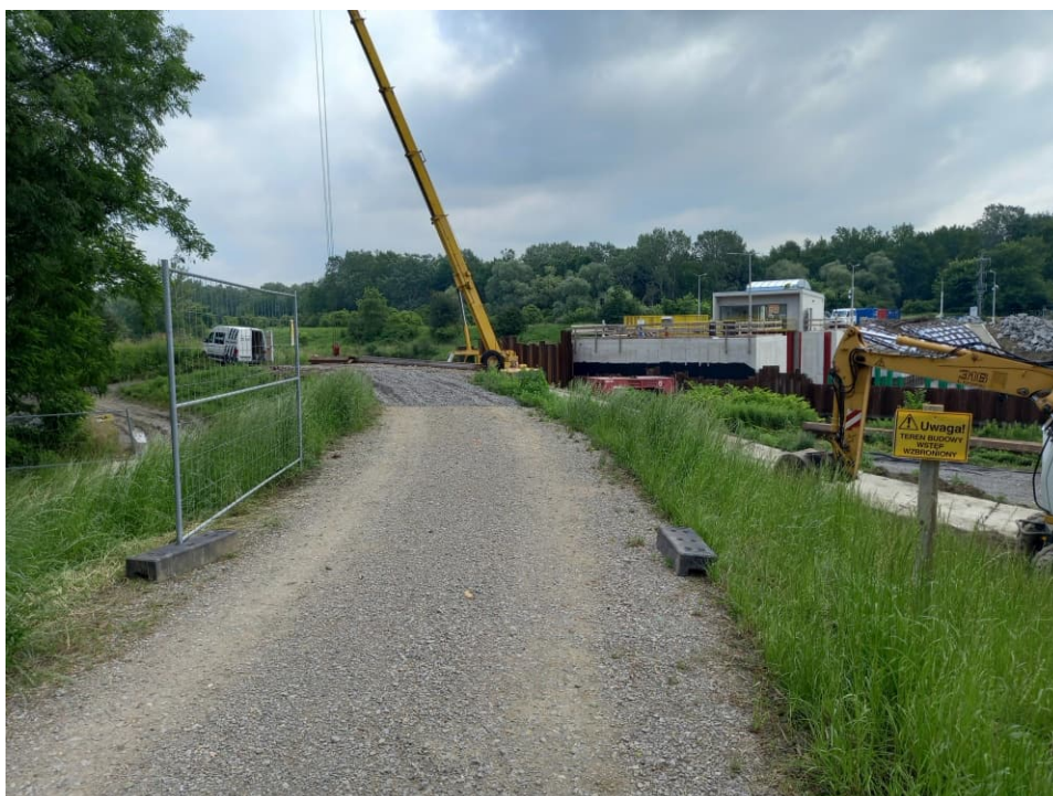
Foto. 16. Oznakowanie terenu budowy na zachodnim brzegu kanału portu Kujawy, stan w trzeciej dekadzie czerwca 2023 r. (widok w kierunku północno-wschodnim).
