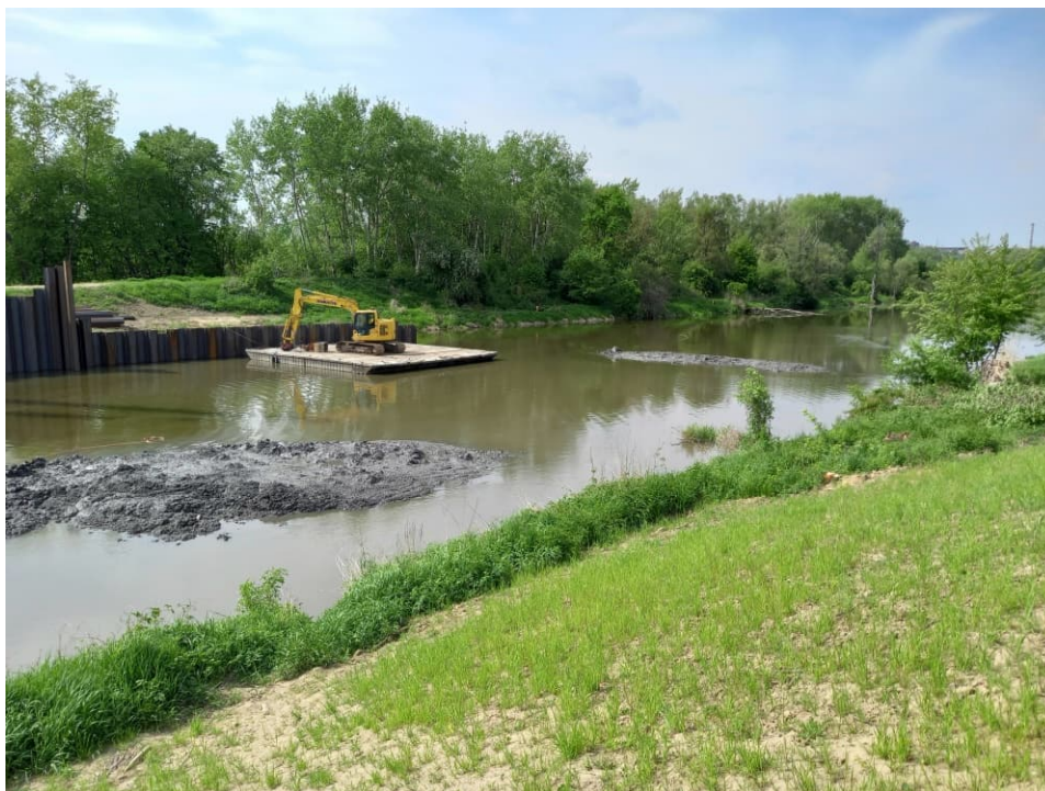
Foto. 26. Pogłębianie dna kanału portu Kujawy na północ od bramy przeciwpowodziowej, stan w drugiej dekadzie maja 2022 r. (widok w kierunku północnym).
