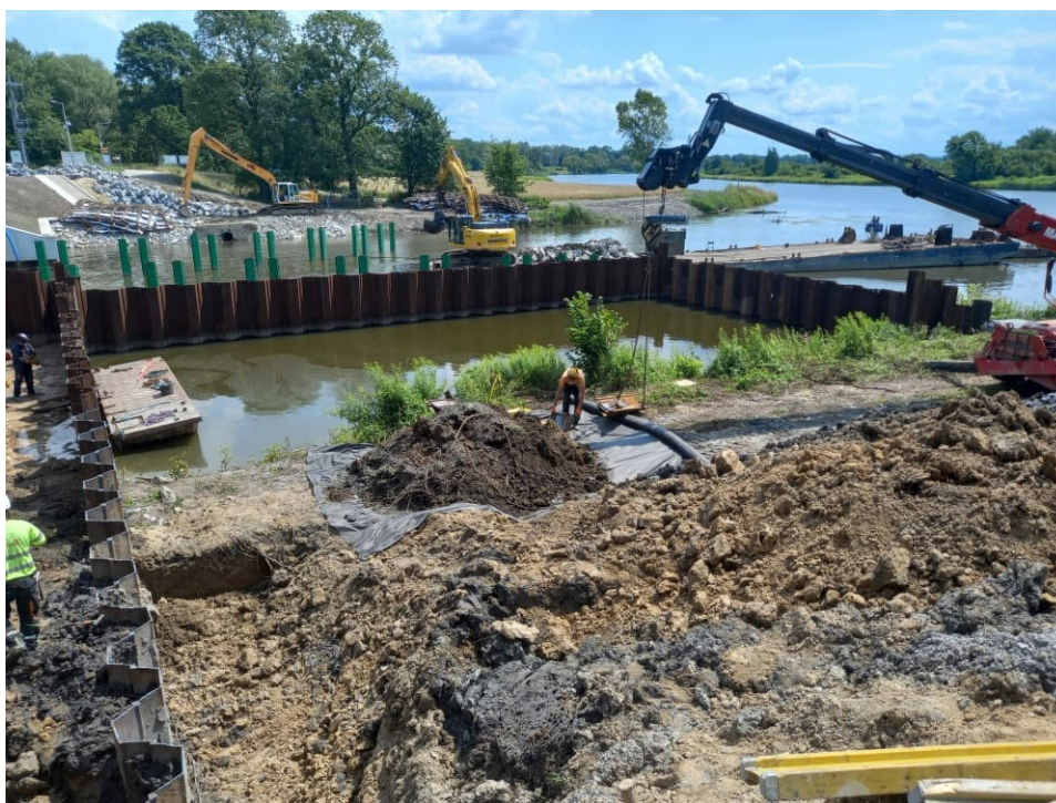
Foto. 22. Zapobieganie rozprzestrzenianiu obcych gatunków roślin inwazyjnych – zabezpieczenie mas ziemnych z wykopanymi korzeniami rdestowca, stan w drugiej dekadzie lipca 2023 r. (widok w kierunku wschodnim).
