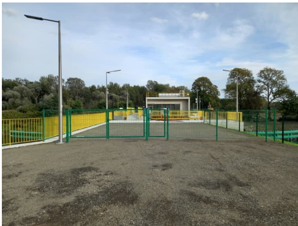
Foto. 55. Stan terenu budowy w pierwszym miesiącu okresu zgłaszania wad – brama przeciwpowodziowa na kanale portu Kujawy – część środkowa, stan w drugiej dekadzie października 2023 r. (widok w kierunku wschodnim).
