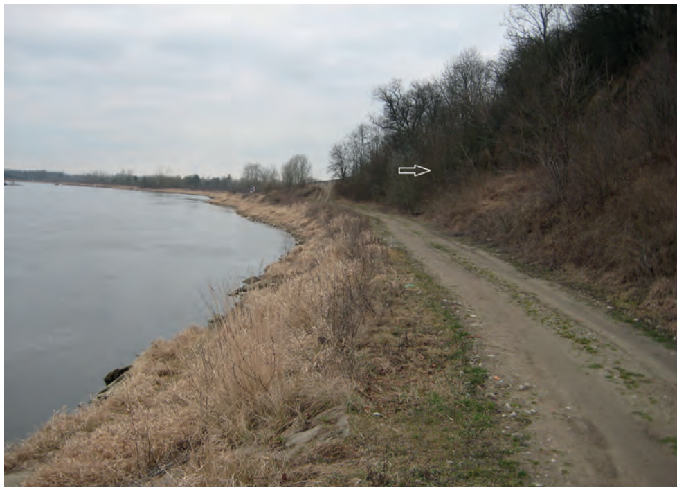
12. Drohiczyn. Skarpa przy zniszczonym narożniku muru zespołu katedralnego z zasypnym wejściem do siedemnastowiecznego tunelu ewakuacyjnego (oznaczone strzałką). Stan z 2015 r.
