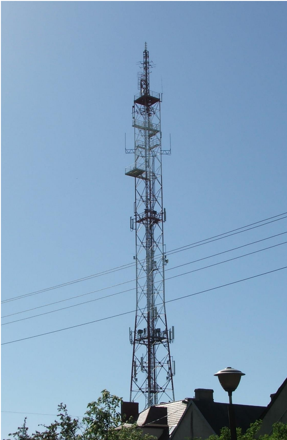
Fot. 1: Widok stacji bazowych ID: BYD1042C oraz ID: 0868, zlokalizowanych przy ul. Chodkiewicza 61 w Bydgoszczy
