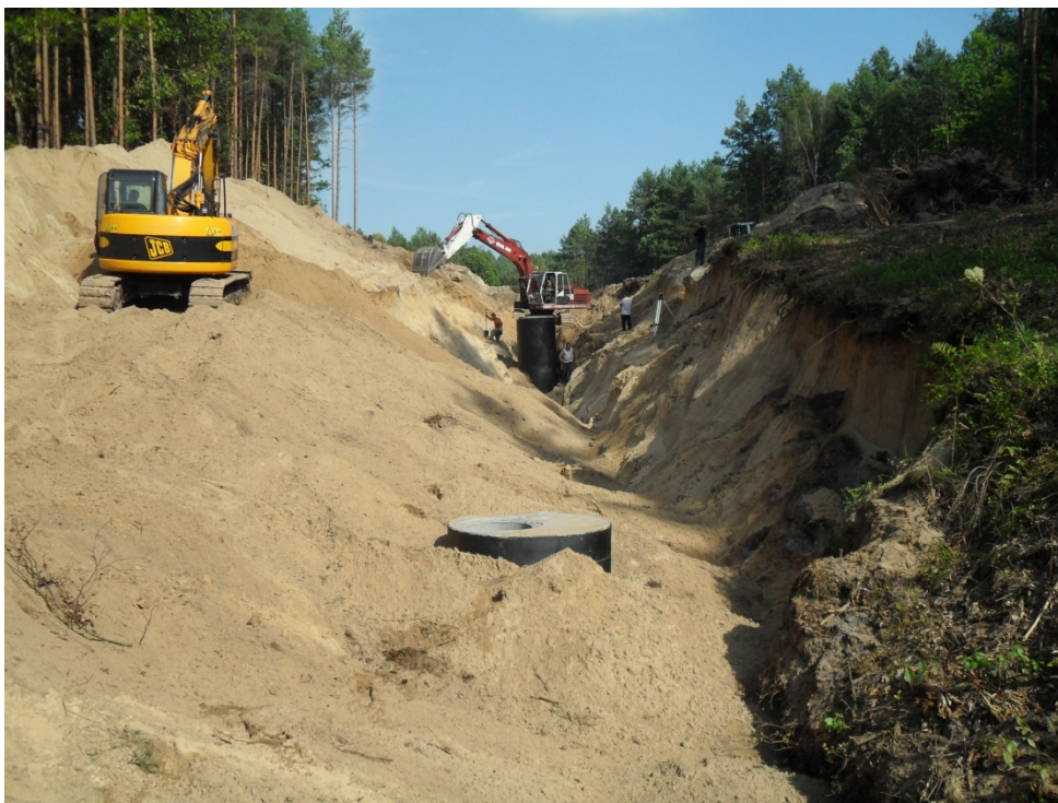
Ryc. 21. Studnie rewizyjne przed zbiornikiem Z1 w budowie.
