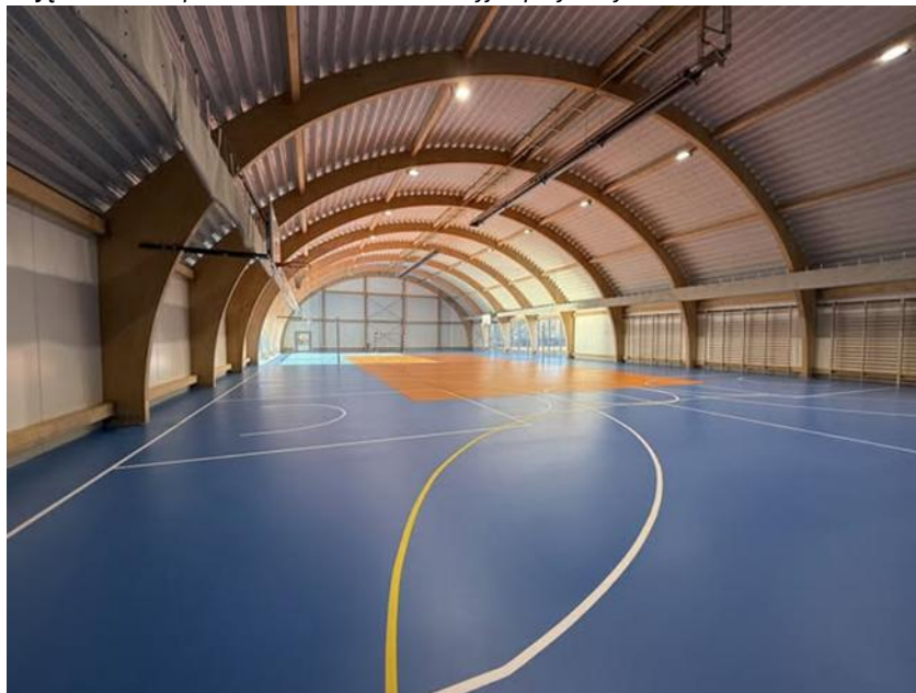
Zdjęcie 6. Nowopowstałe boisko wielofunkcyjne przy budynku liceum.
