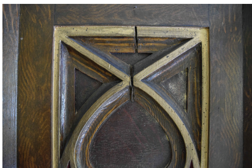
30. Ambona z kościoła pw. św. Wojciecha Biskupa i Męczennika w Uhowie – przed pracami konserwatorskimi – zbliżenie na spękania oraz ubytki. Fot. M. Ponikowska-Preseisen Pulpit from the Church of St. Adalbert, Bishop and Martyr, in Uhowo – before conservation work – close-up of cracks and losses. Photo by M. Ponikowska-Preseisen
