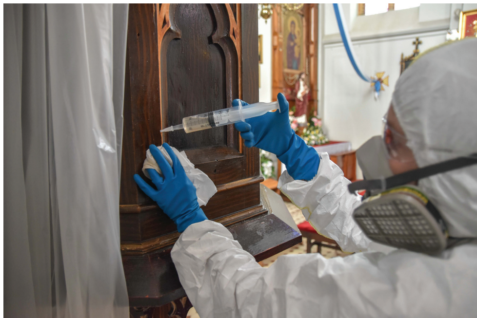
33. Ambona z kościoła pw. św. Wojciecha Biskupa i Męczennika w Uhowie – stan w trakcie prac konserwatorskich – dezynsekcja. Fot. M. Ponikowska-Preseisen Pulpit from the Church of St. Adalbert, Bishop and Martyr, in Uhowo – condition during conservation work – disinfestation. Photo by M. Ponikowska-Preseisen
