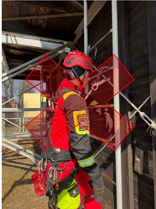
Rysunek 23. Nieprawidłowe prowadzenie ramion lonży typu Y z absorberem, co skutkuje brakiem możliwości zadziałania absorbera energii – przykład 2
