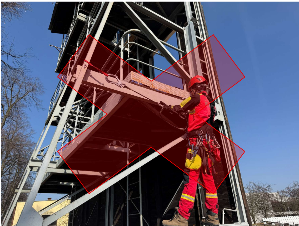
Rysunek 17. Niepożądana sytuacja, w której może dojść do wystąpienia efektu wahadła
