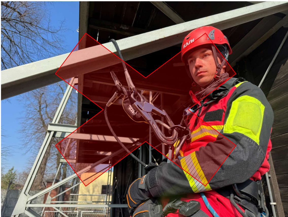
Rysunek 26. Nieprawidłowe dopięcie do upręży karabinka łoży typu Y z absorberem, co skutkuje brakiem możliwości zadziałania absorbera energii – przykład 5
