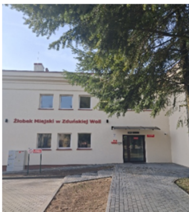
Zdjęcie Nr 10 – Wejście do Żłobka
