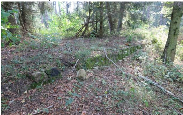
Fotografia 38. Fundament budynku w nieistniejącej osadzie służbowej Oleśno (Alsen), leśn. Nieradź, oddział 119
