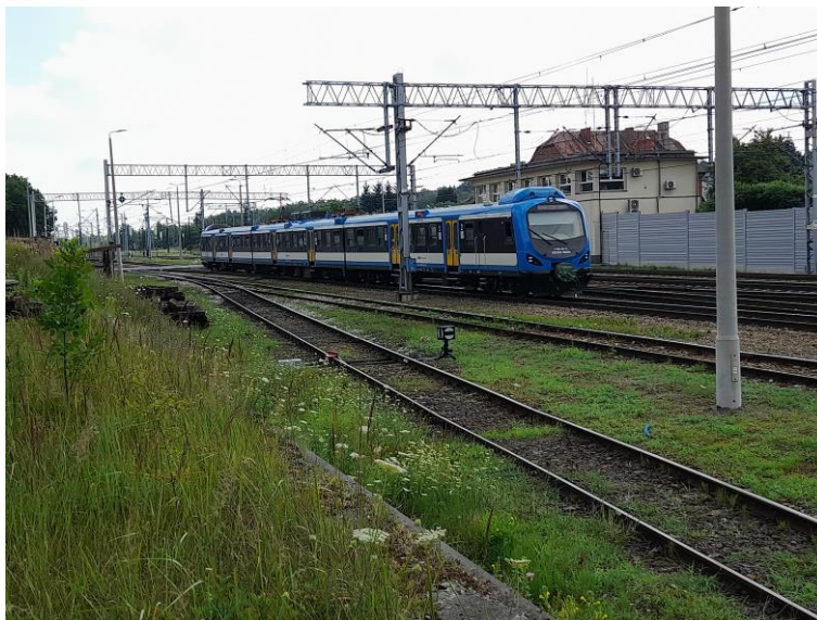
Fot. 1. Herby, RB1. Badane odcinki linii kolejowych nr 61, 687, 704 w kierunku Częstochowy.
