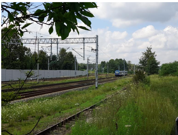
Fot. 2. Herby, RB1. Badane odcinki linii kolejowych nr 61, 687, 704 w kierunku Lublińca.
