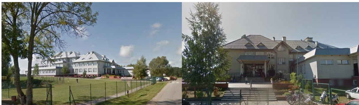
Budynek Szkoły Podstawowej im. Ignacego Krasickiego w Świątynie po termomodernizacji
