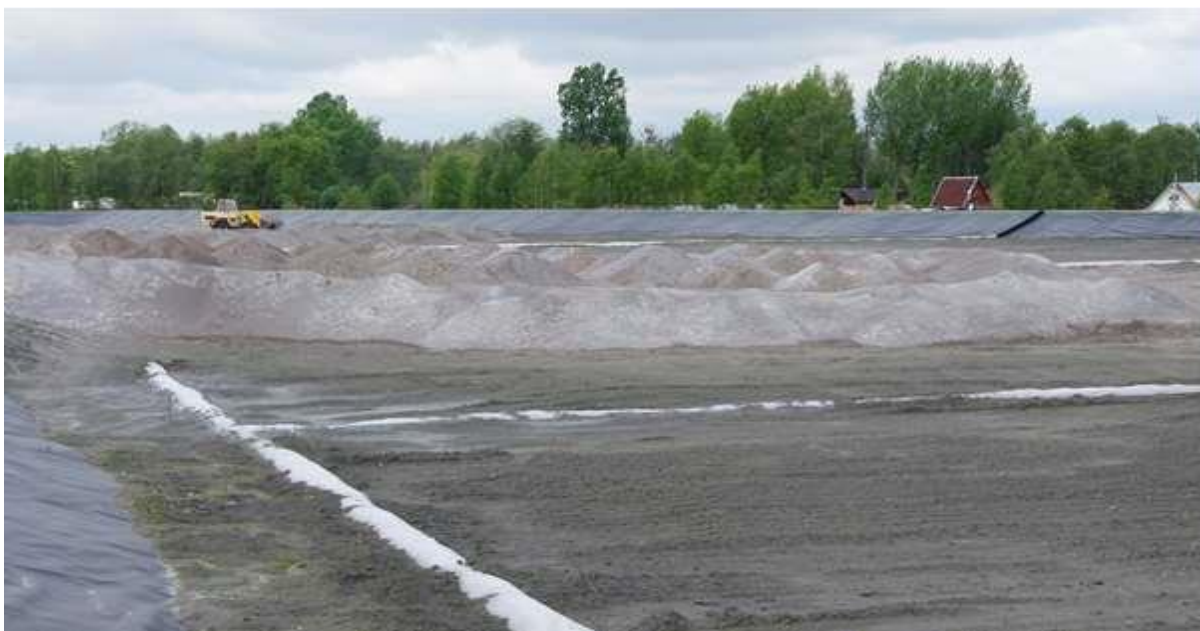
Fot.2 Składowisko odpadów Elektrociepłowni Szczecin. Materiały własne.
