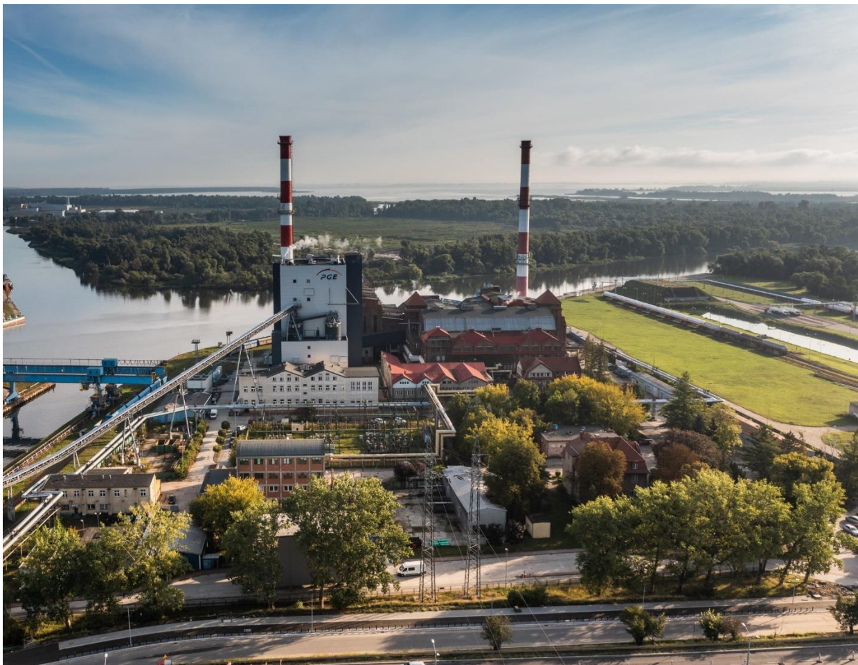
Fot.1 Elektrociepłownia Szczecin. Materiały własne.
