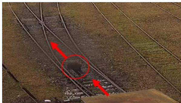
Zdjęcie 11 - Kierunek marszu pracownika ochrony po otwarciu bramy przy rozjeździe nr 205. U dołu nadjeżdżający skład manewrowy z platformą załadowaną kontenerem technicznym (źródło: materiał przekazany przez komisję kolejową)
