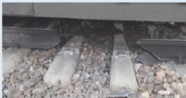
Zdjęcie 19 - Skutki zdarzenia - wykruszona szyna w miejscowości Mika stwierdzona w dniu 16-11-2025 (źródło: materiały przekazane przez komisję kolejową)
