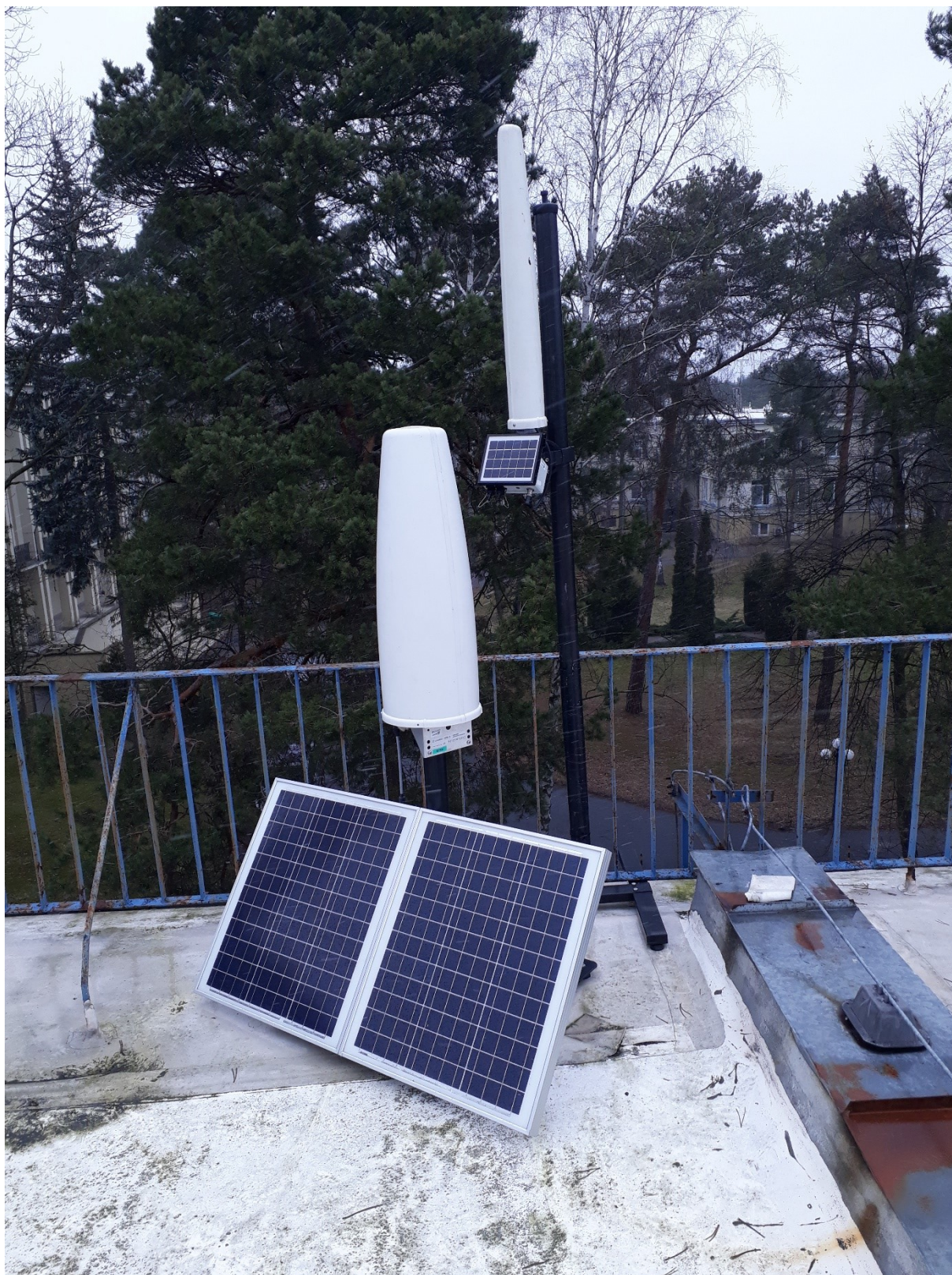
Rys. 5 Miejsce montażu SELMS PEM – IŁ-PIB w Warszawie – lokalizacja 2
