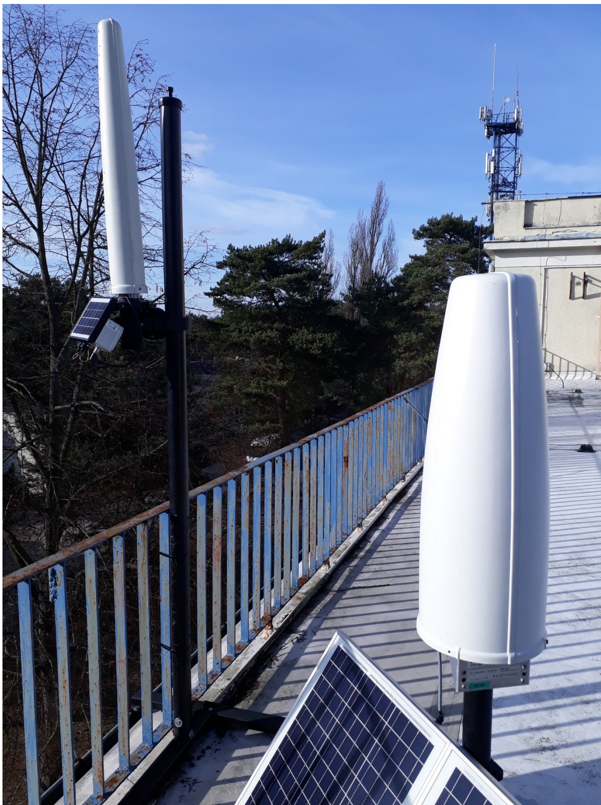
Rys. 4 Miejsce montażu SELMS PEM – Ik-PIB w Warszawie – lokalizacja 1, widok na SBTk
