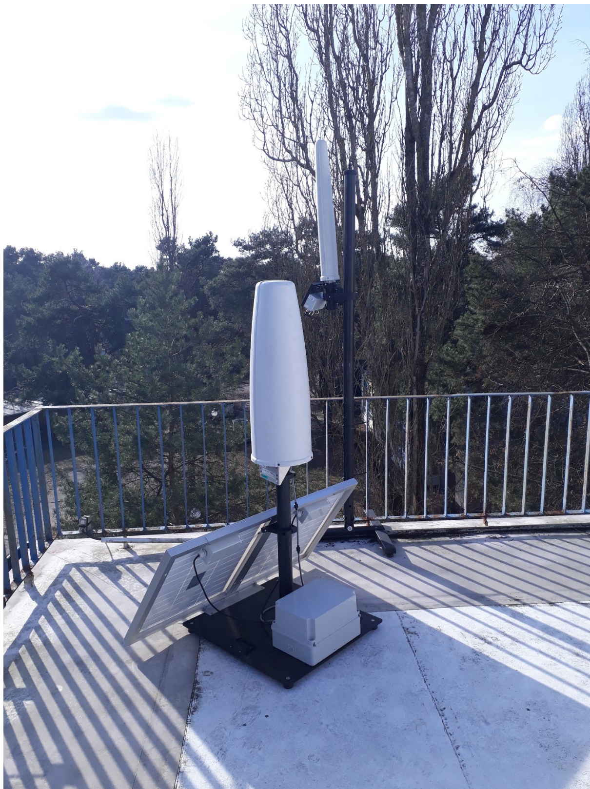
Rys. 3 Miejsce montażu SELMS PEM – IŁ-PIB w Warszawie – lokalizacja 1
