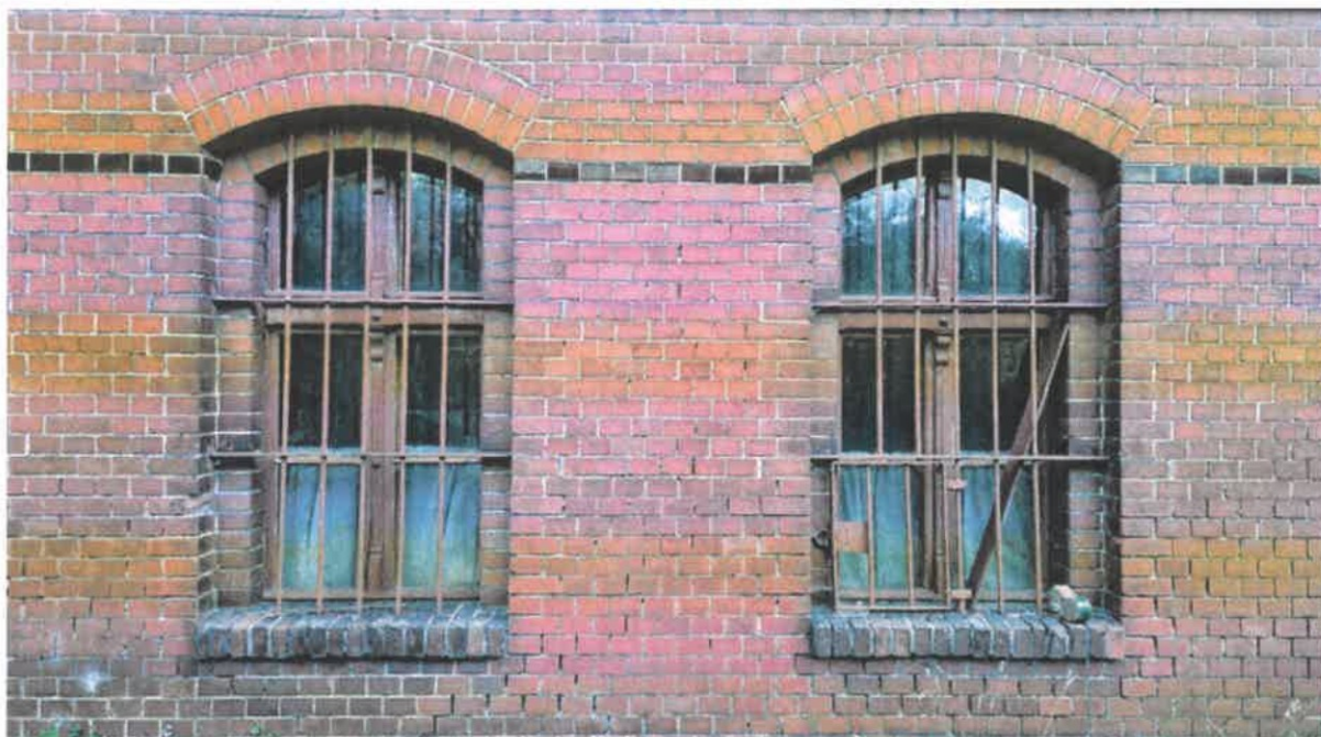
Budynek gospodarczy, elewacja północnej. Zauważalny detal stolarki okiennej, obróbka murarska łuków okien oraz pas elewacyjny z cegły szklanej.
