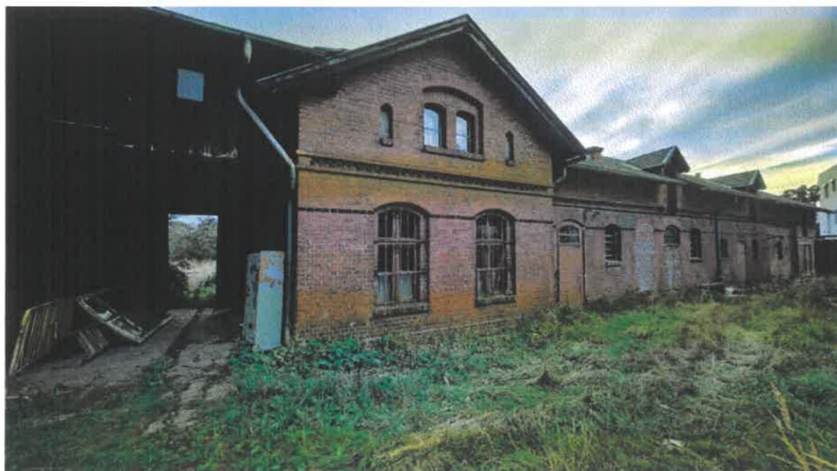
Budynek gospodarczy, elewacja północna, widok w kierunku południowo-zachodnim. Widoczna górna elewacja z charakterystycznymi szczytami. Wyraźnie widoczny fryz zębaty na całej długości ceglanej elewacji i poniżej pas z cegieł szklwionych łączący łuki okien.
