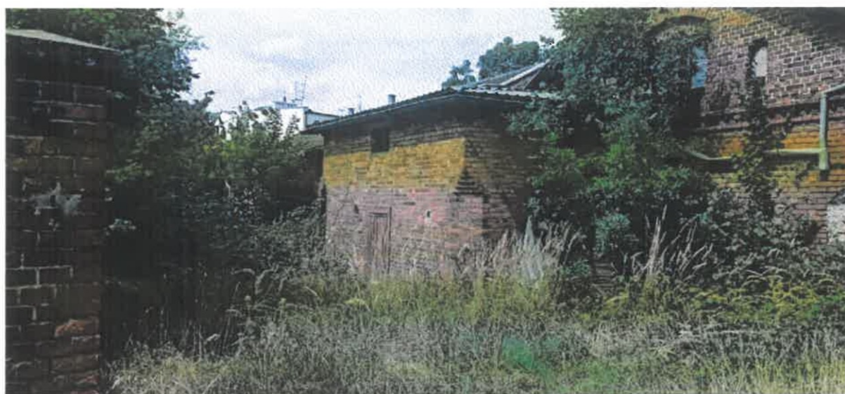
Budynek gospodarczy, elewacja południowa, widok w kierunku północnym. Widoczne lico elewacji z neogotyckim detalem ukształtowanymi cegłą klinkierową i glazurowaną.
