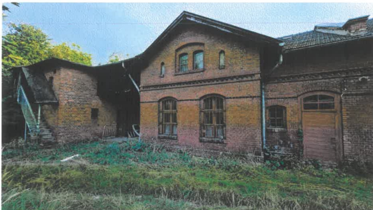
Budynek gospodarczy, elewacja północna, fragment w części wschodniej. Widoczna drewniana górna kondygnacja usytuowana nad przejazdem bramowym.
