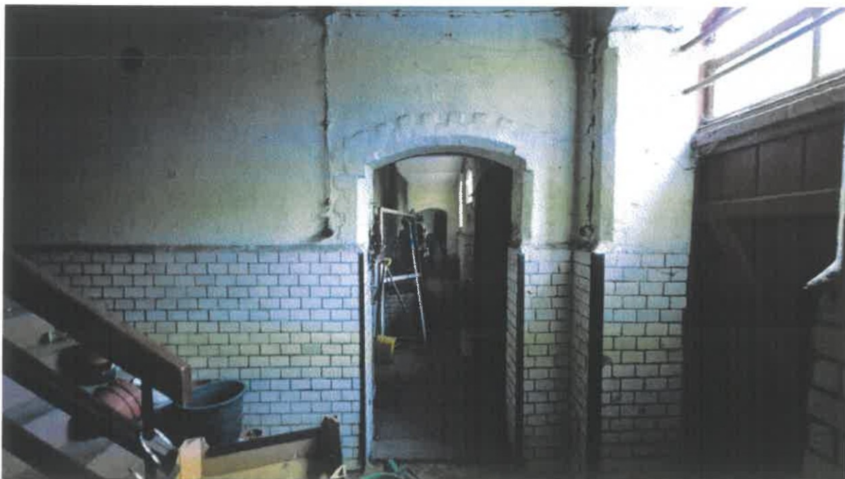
Budynek gospodarczy. Wnętrze. Lamperia z kształtek ceramicznych szklwionych. Widoczna obróbka nadproża otworu drzwiowego, wtórnie przykryta warstwą farby.
