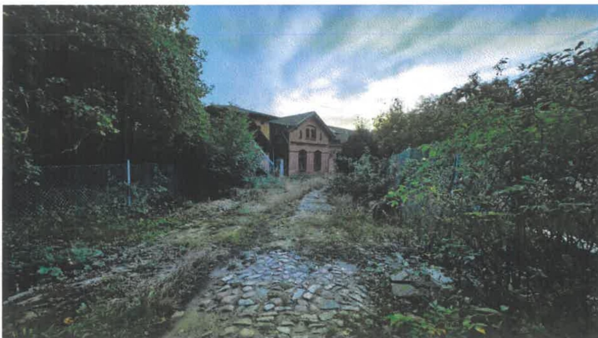
Budynek gospodarczy, elewacja północna, widok w kierunku zachodnim. Widoczna również historyczna brukowana droga wiodąca z parku klasztornego na wnioskowany obszar dawnego gospodarstwa.
