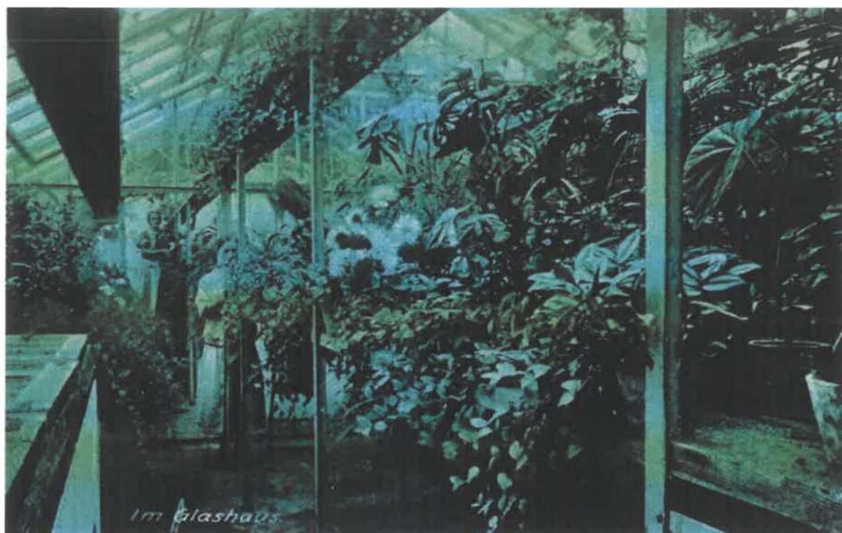
Fotografia z początku XX wieku z wnętrzem budynku szklarni.
