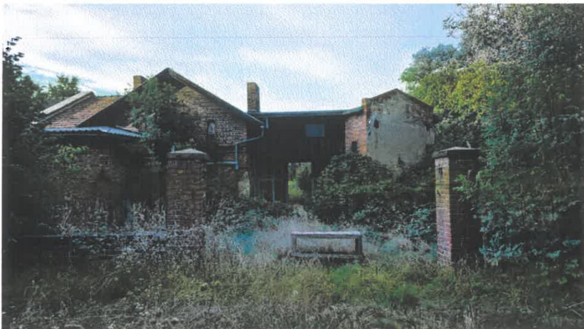
Budynek gospodarczy, elewacja południowa z widocznym przejazdem. Przed elewacją dwa słupy murowane z kapami kamiennymi, jako część dawnego kutego ze stali wyгородzenia wewnętrznego z podmurówką.
