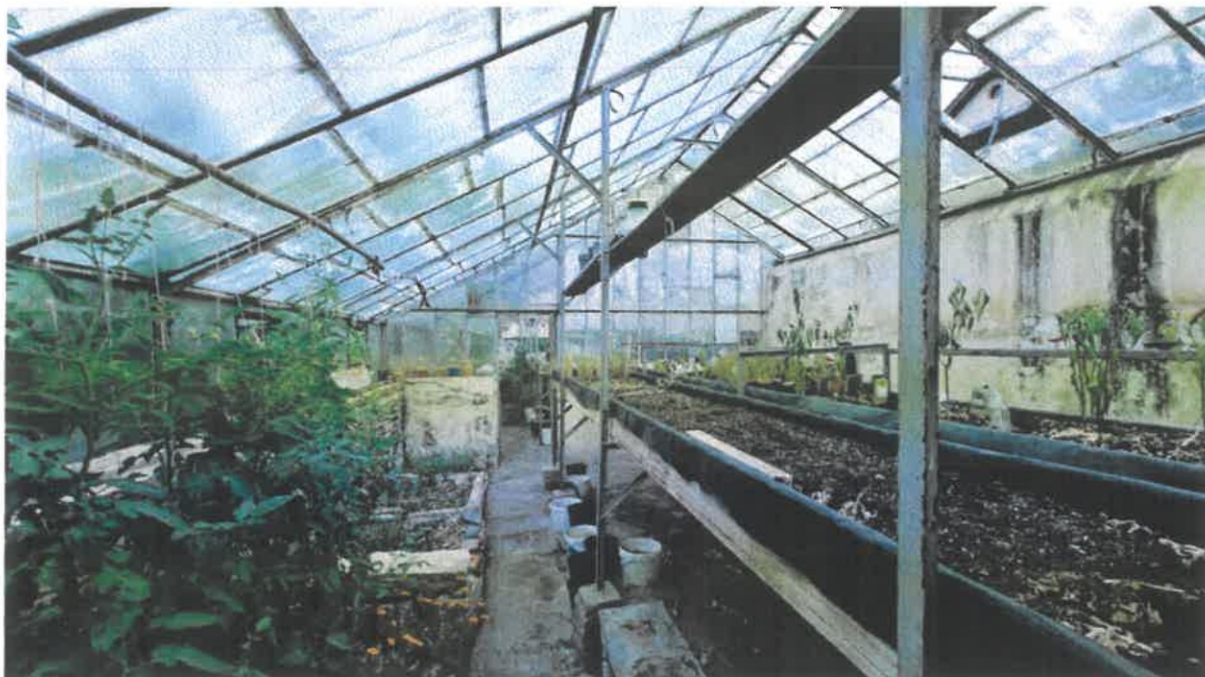
Szklarnia. Wnętrze. Zachowane w niezmienionym kształcie od momentu budowy.
