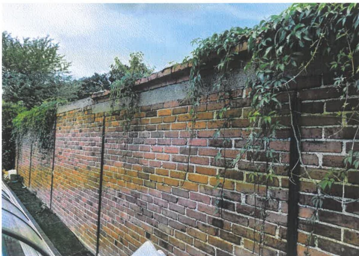
Fragment muru wzdłuż granicy wschodniej działki. Widoczna dobrze zachowana konstrukcja ceglanego muru od strony wschodniej.
