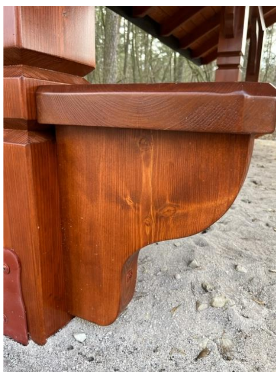
Zdjęcie nr 5 – detal podparcia ławki bocznej
