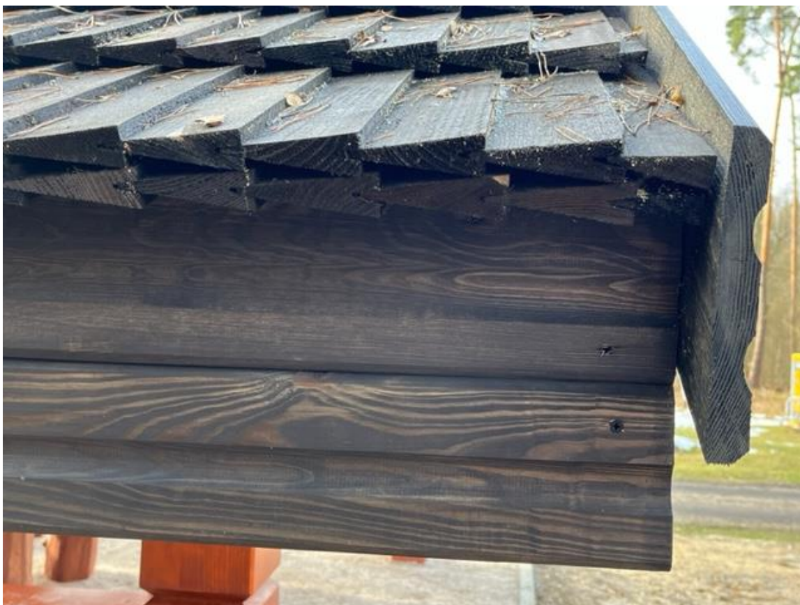
Zdjęcie nr 9 – detal deski okapowej
