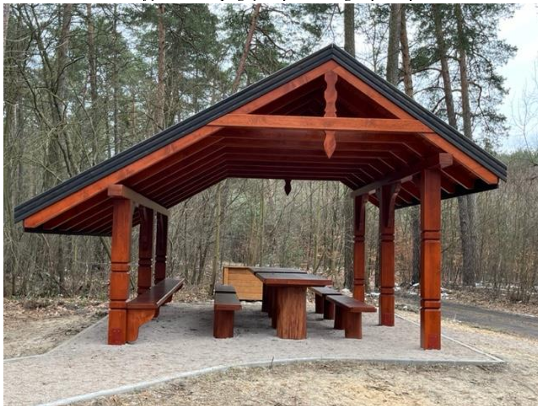
Zdjęcie nr 2 – elewacja frontowa wiaty
