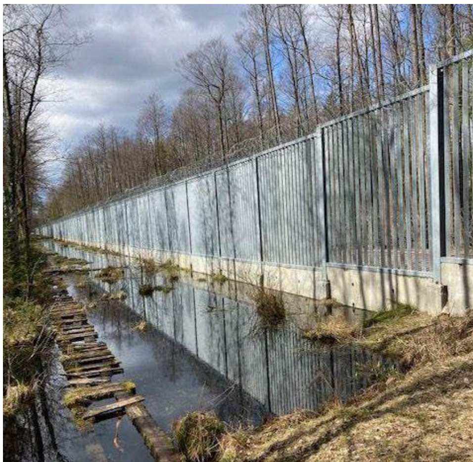
Zdjęcie 6. Wiosenny przepływ wód powierzchniowych (marzec 2024 r.) z Białorusi do Polski w obrębie obiektu zakłócony przez polską barierę ochronną i przyległą drogę serwisową (źródło: Glenn Plumb).
