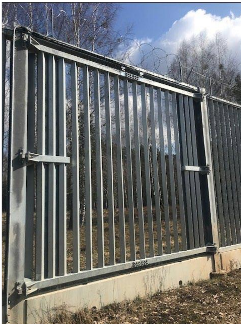
Zdjęcie 3. Duże bramy o szerokości 5 m i wysokości 4,5 m, które teoretycznie można otworzyć, aby ułatwić przemieszczanie się większych zwierząt (źródło: Guy Debonnet).
