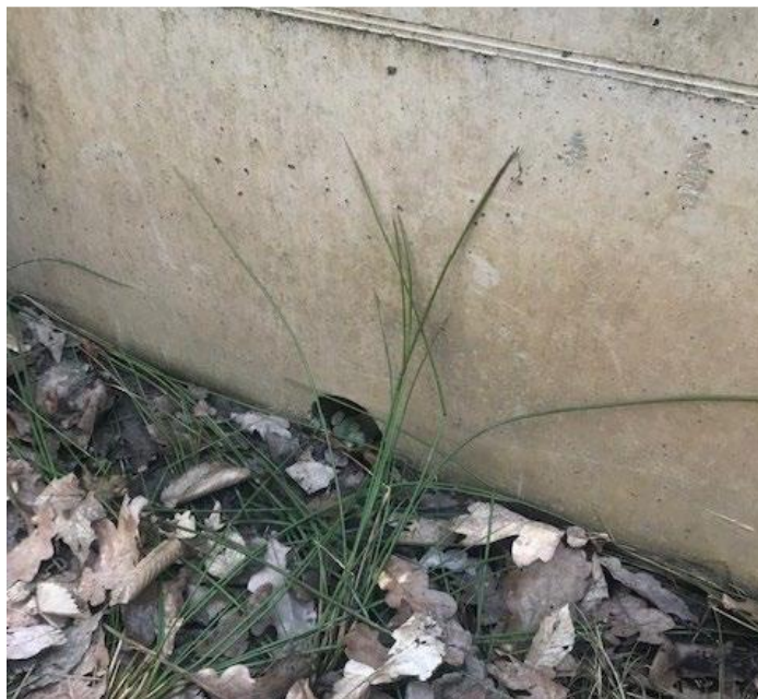
Zdjęcie 2. Co 5 metrów w betonowej podstawie bariery znajdują się dwa małe otwory (źródło: Guy Debonnet).
