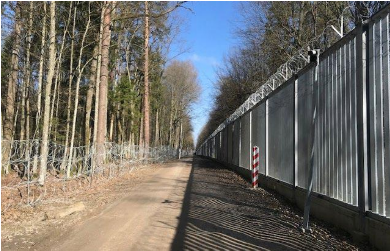
Zdjęcie 1. Nowo wybudowana bariera graniczna składa się z 5-metrowych stalowych słupów z 0,5-metrowym fundamentem, zwieńczonych 0,5-metrowym drutem harmonijkowym kolczastym. Obok głównej bariery granicznej znajduje się droga serwisowa, a za nią druga bariera (źródło: Guy Debonnet).
