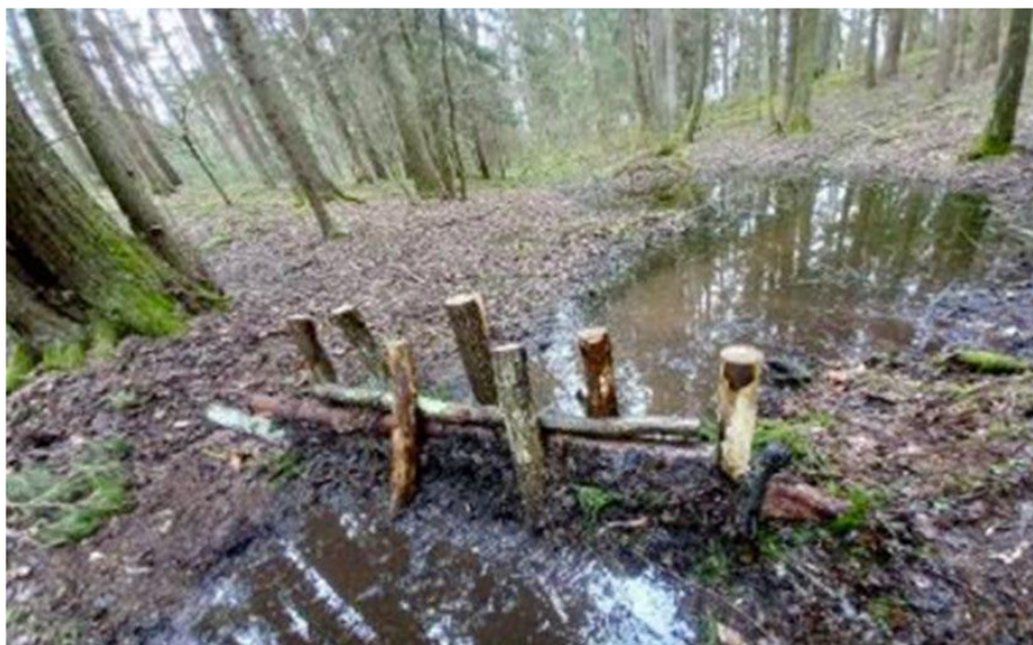
Rys. 20. Przykład małej tamy zbudowanej z naturalnych materiałów w Strefie 4 polskiej części obiektu (źródło: PGLLP).
