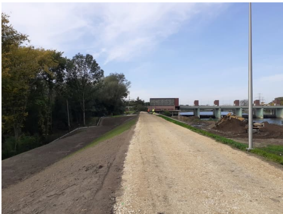
Foto. 61. Stan terenu budowy w ostatnim kwartale okresu realizacji robót – wał przeciwpowodziowy Wisły powyżej portu Płaszów – część dolna, stan w drugiej dekadzie października 2023 r. (widok w kierunku zachodnim).
