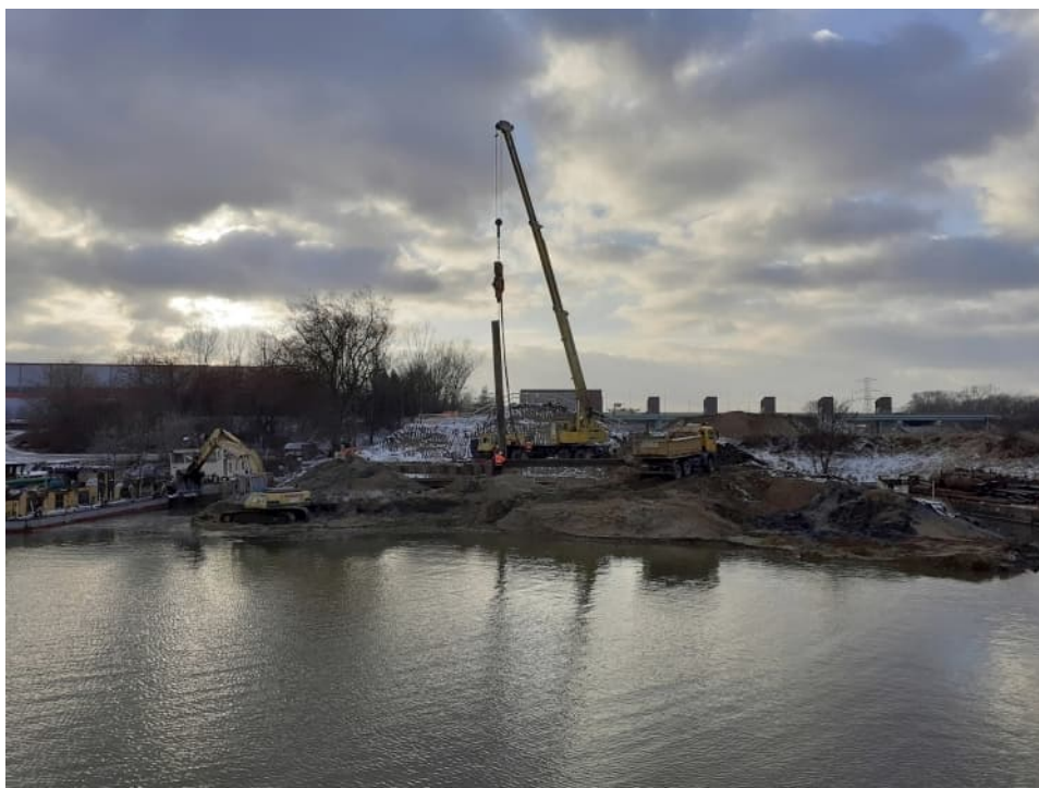
Foto. 35. Pograżanie ścianek szczelnych na zachodnim brzegu kanału portu Płaszów, stan w drugiej dekadzie stycznia 2022 r. (widok w kierunku zachodnim).
