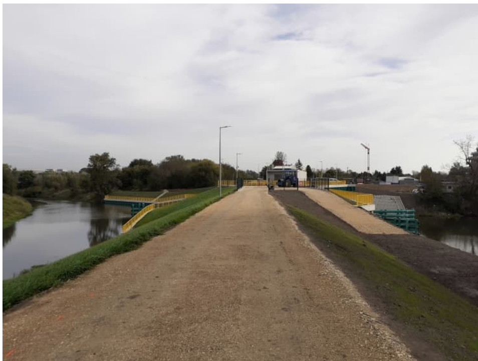
Foto. 62. Stan terenu budowy w ostatnim kwartale okresu realizacji robót – wał przeciwpowodziowy Wisły powyżej portu Płaszów – część dolna, stan w drugiej dekadzie października 2023 r. (widok w kierunku wschodnim).
