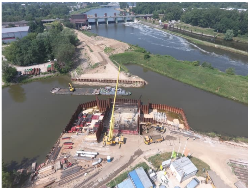
Foto. 34. Pogłębianie dna kanału portu Płaszów na południe od bramy przeciwpowodziowej, stan w trzeciej dekadzie czerwca 2022 r. (widok w kierunku zachodnim).
