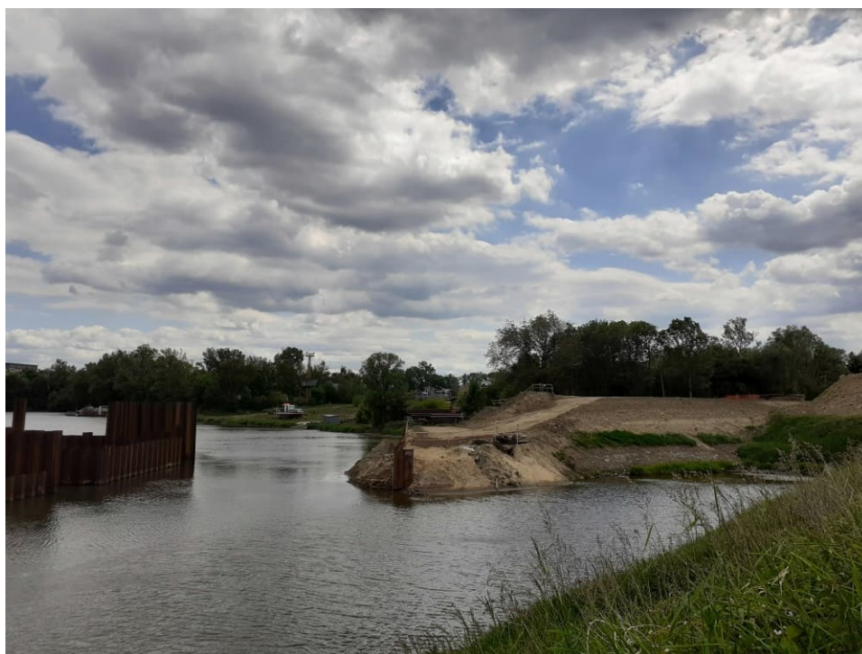
Foto. 28. Utrzymywanie drożności kanału portu Płaszów w okresie robót, stan w trzeciej dekadzie maja 2022 r. (widok w kierunku południowym).
