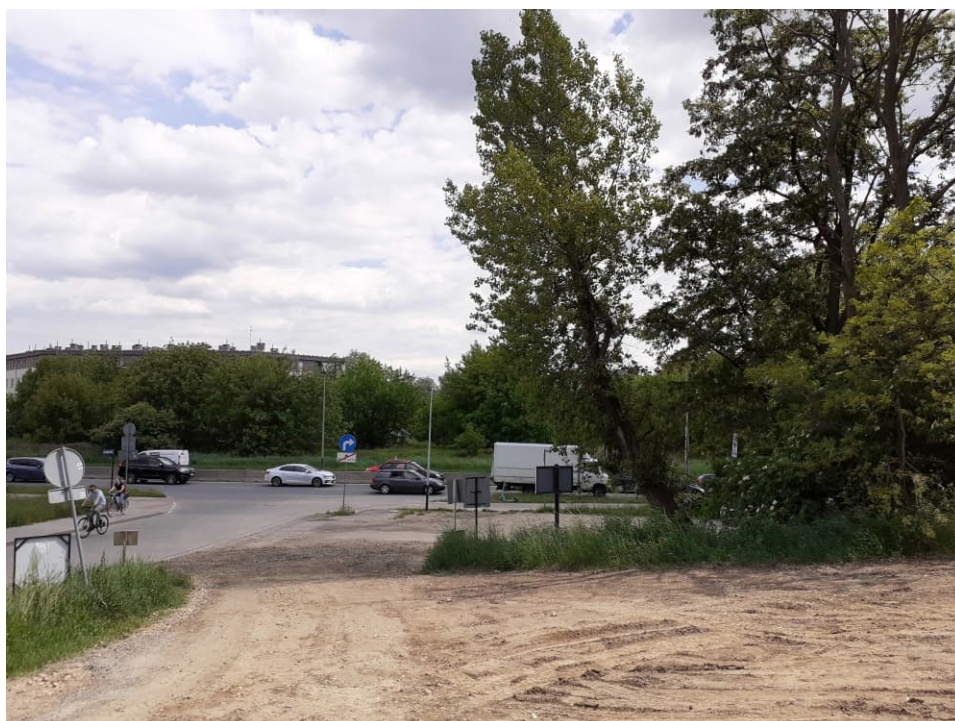
Foto. 20. Połączenie drogi dojazdowej do terenu budowy z drogami publicznymi, stan w trzeciej dekadzie maja 2022 r. (widok w kierunku południowym).
