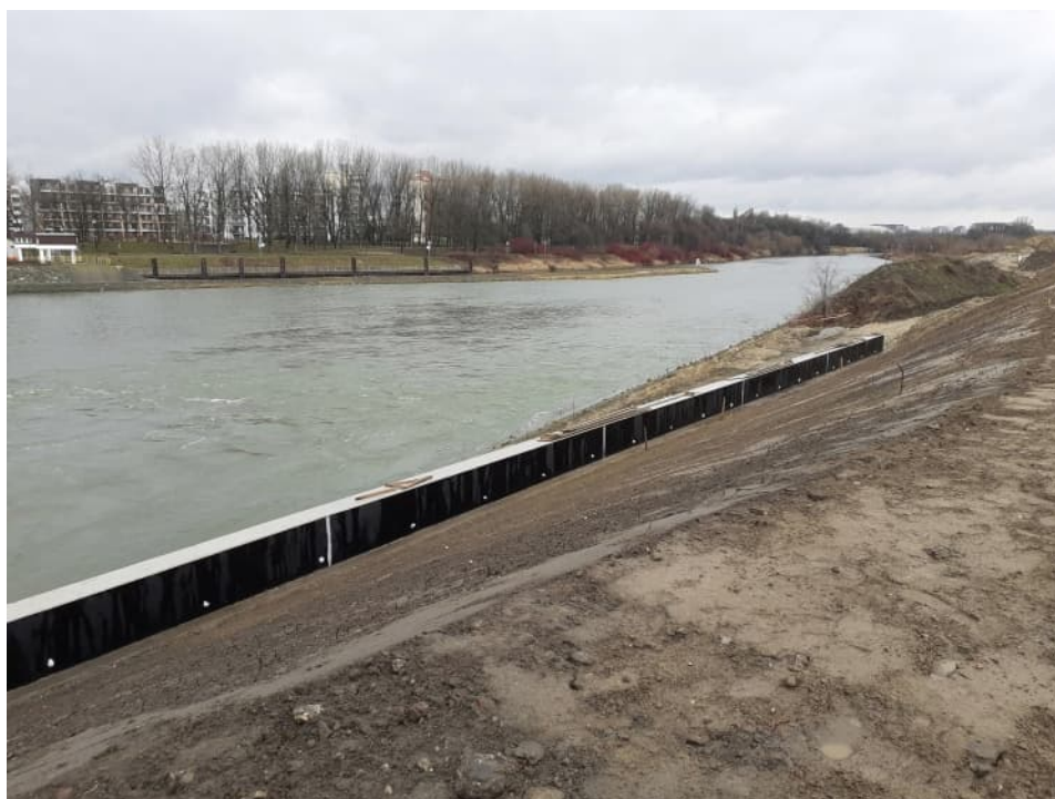
Foto. 54. Formowanie skarp wału przeciwpowodziowego Wisły powyżej portu Płaszów, stan w pierwszej dekadzie marca 2023 r. (widok w kierunku wschodnim).
