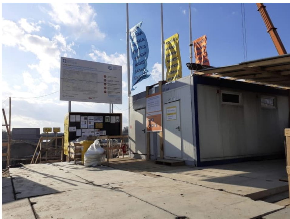
Foto. 18. Zaplecze budowy na wschodnim brzegu kanału portu Płaszów, stan w trzeciej dekadzie lutego 2022 r. (widok w kierunku zachodnim).
