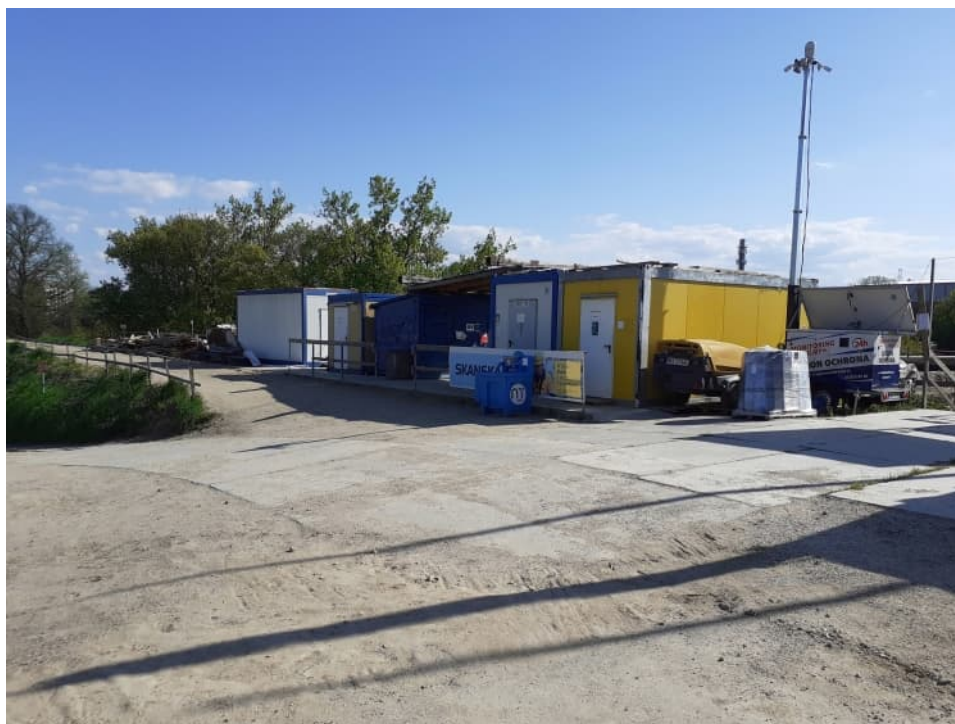
Foto. 17. Zaplecze budowy na wschodnim brzegu kanału portu Płaszów, stan w pierwszej dekadzie maja 2023 r. (widok w kierunku zachodnim).
