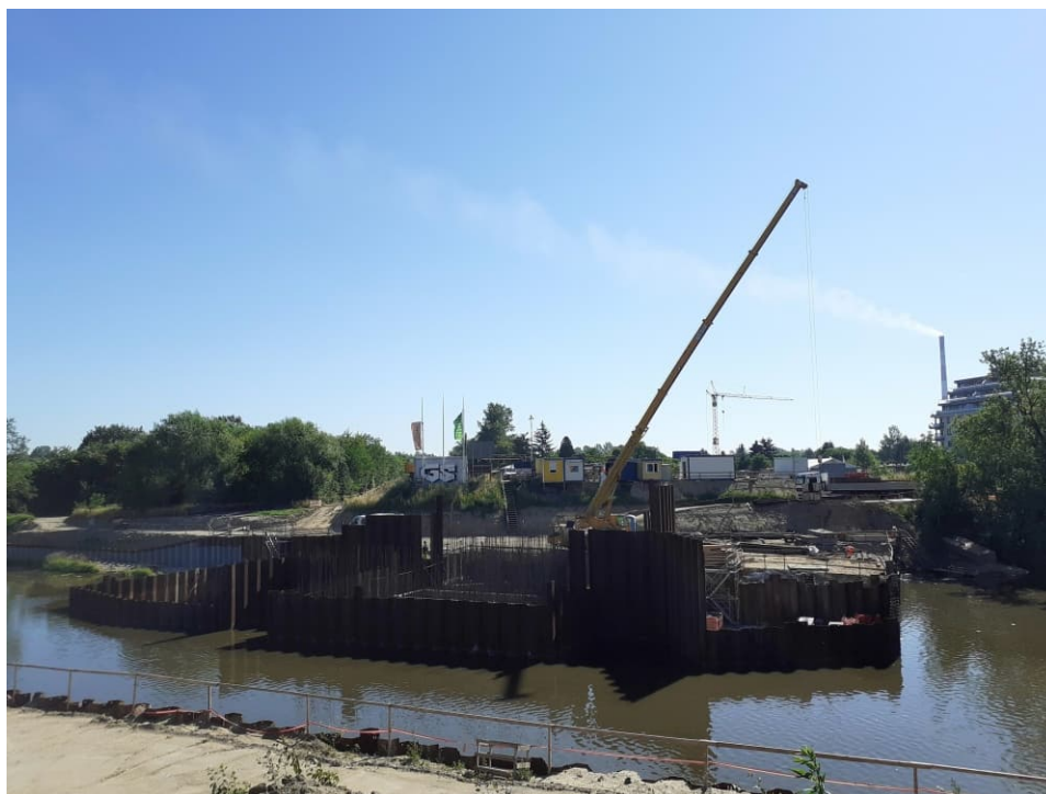
Foto. 41. Teren budowy bramy przeciwpowodziowej na kanale portu Płaszów, stan w trzeciej dekadzie czerwca 2022 r. (widok z zachodniego brzegu kanału, w kierunku wschodnim).
