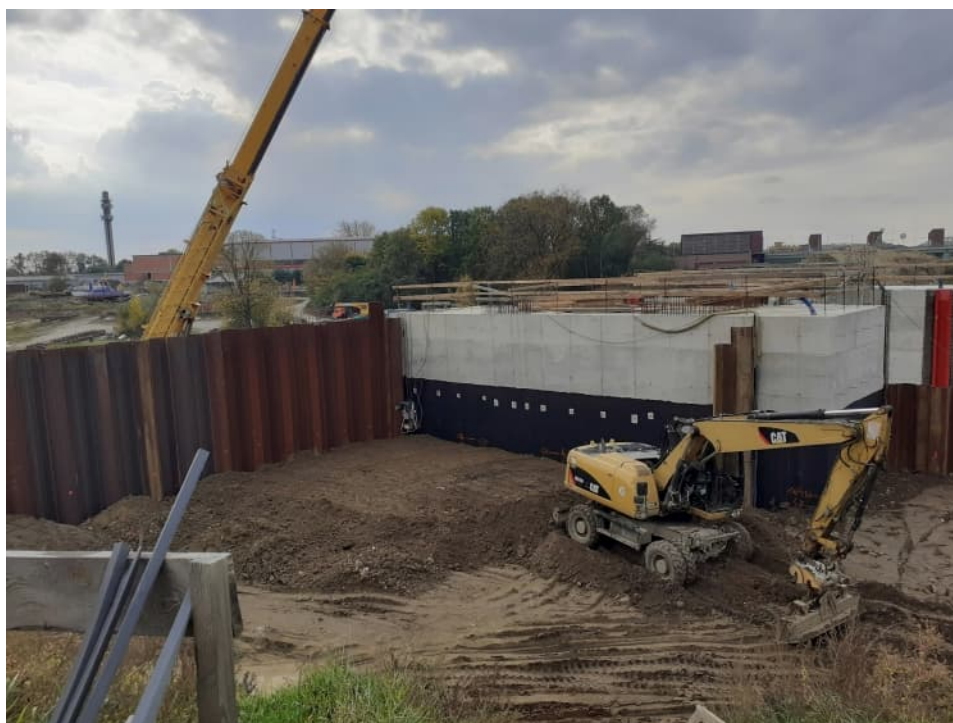
Foto. 44. Teren budowy bramy przeciwpowodziowej na kanale portu Płaszów, stan w pierwszej dekadzie października 2022 r. (widok ze wschodniego brzegu kanału, w kierunku zachodnim).
