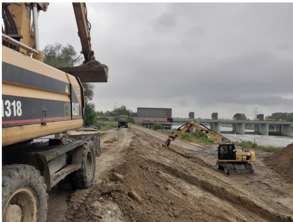
Foto. 53. Formowanie skarp wału przeciwpowodziowego Wisły powyżej portu Płaszów, stan w trzeciej dekadzie sierpnia 2023 r. (widok w kierunku zachodnim).
