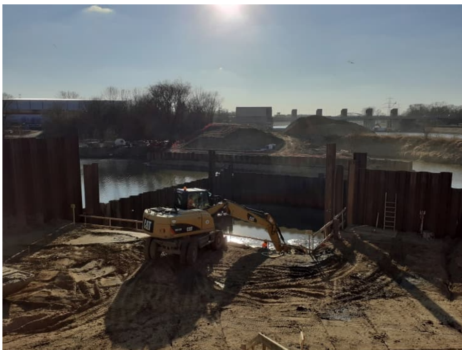
Foto. 40. Teren budowy bramy przeciwpowodziowej na kanale portu Płaszów, stan w pierwszej dekadzie marca 2022 r. (widok ze wschodniego brzegu kanału, w kierunku zachodnim).
