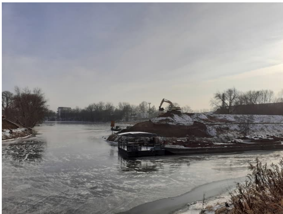
Foto. 31. Zdejmowanie warstwy humusu, stan w trzeciej dekadzie grudnia 2021 r. (widok w kierunku południowym).
