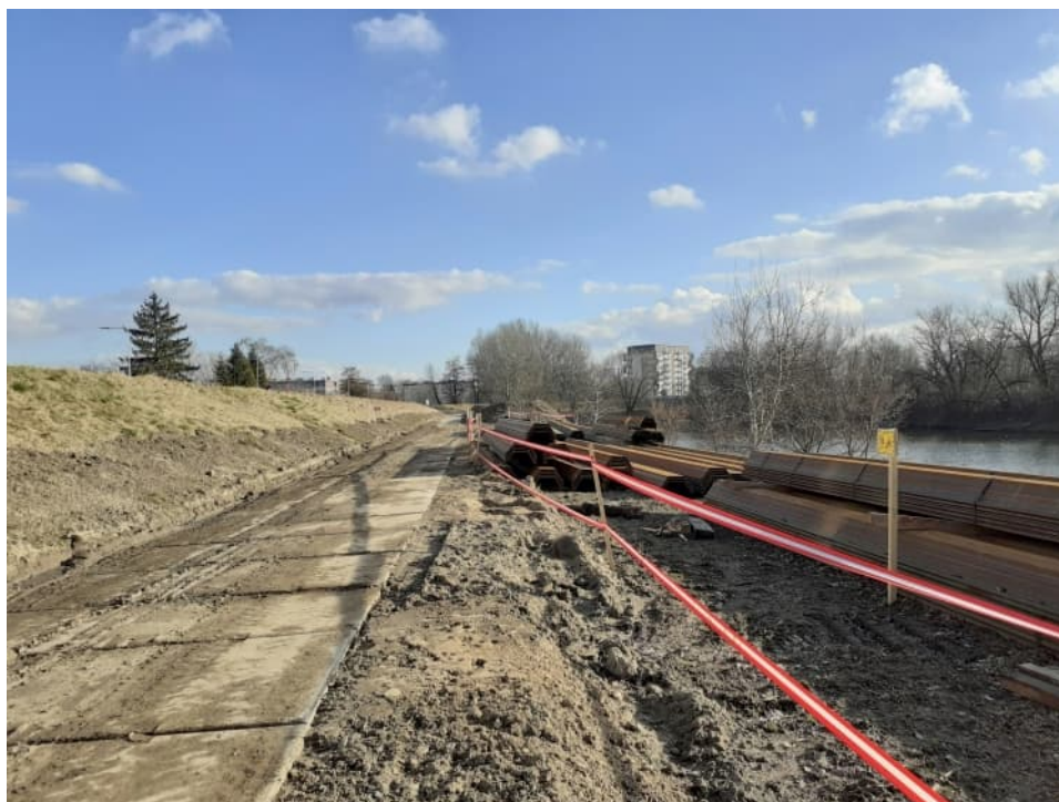
Foto. 19. Droga dojazdowa do terenu budowy na wschodnim brzegu kanału portu Płaszów, stan w trzeciej dekadzie lutego 2022 r. (widok w kierunku południowym).
