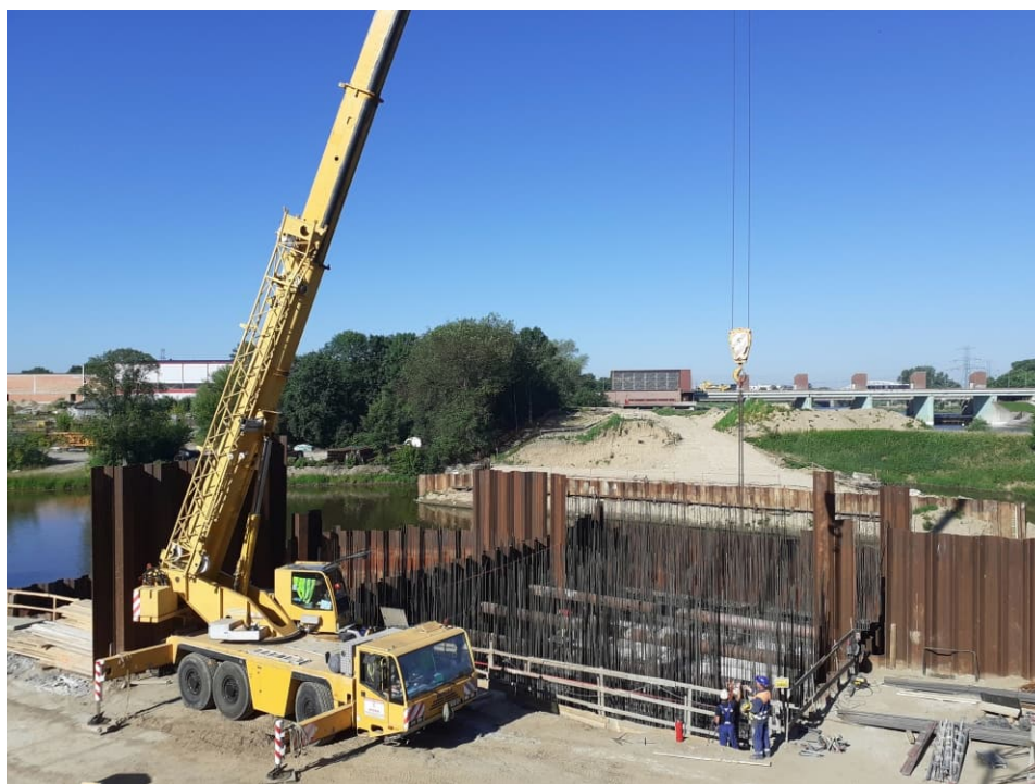
Foto. 42. Teren budowy bramy przeciwpowodziowej na kanale portu Płaszów, stan w pierwszej dekadzie czerwca 2022 r. (widok ze wschodniego brzegu kanału, w kierunku zachodnim).
