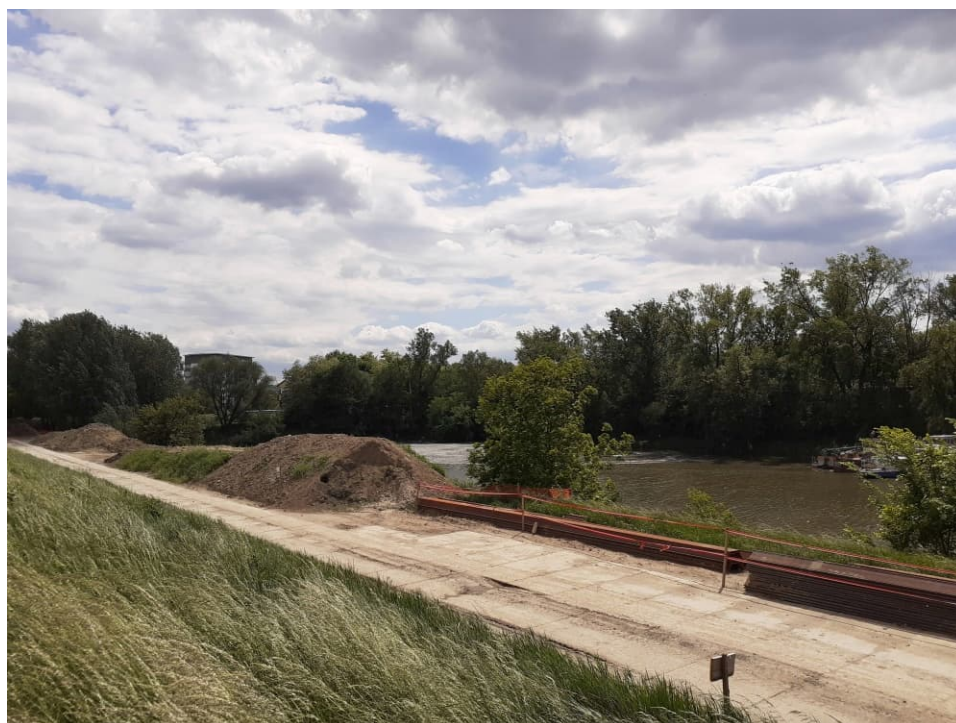
Foto. 32. Zabezpieczenie hałd humusu, stan w trzeciej dekadzie maja 2022 r. (widok w kierunku południowym).
