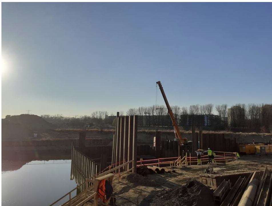
Foto. 36. Pograżanie ścianek szczelnych na wschodnim brzegu kanału portu Płaszów, stan w trzeciej dekadzie marca 2022 r. (widok w kierunku zachodnim).
