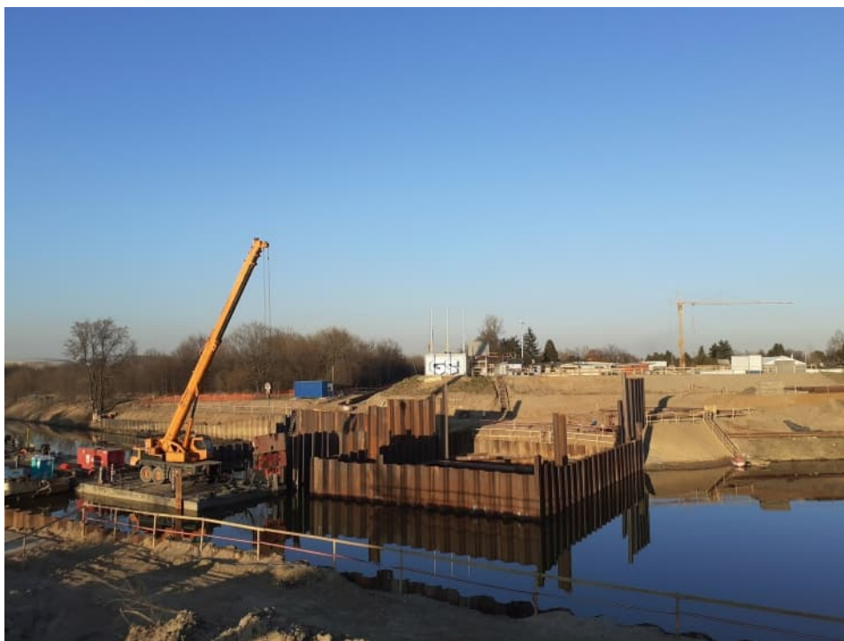
Foto. 39. Teren budowy bramy przeciwpowodziowej na kanale portu Płaszów, stan w trzeciej dekadzie marca 2022 r. (widok z zachodniego brzegu kanału, w kierunku wschodnim).
