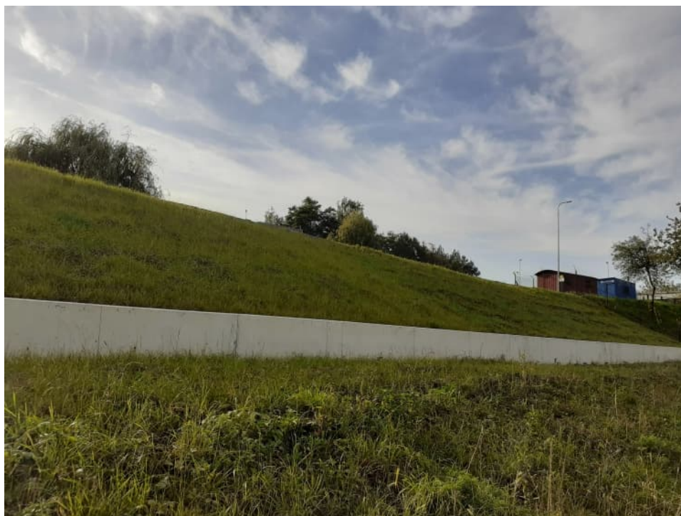
Foto. 59. Stan terenu budowy w ostatnim kwartale okresu realizacji robót – wał przeciwpowodziowy Wisły powyżej portu Płaszów – część górna, stan w drugiej dekadzie października 2023 r. (widok w kierunku zachodnim).
