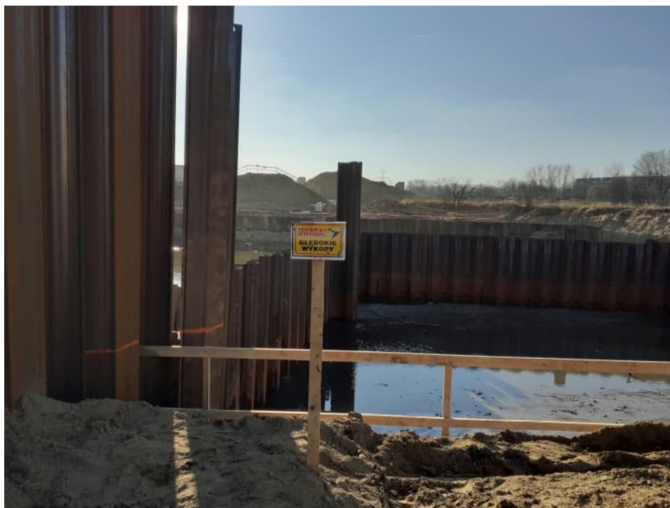
Foto. 23. Zabezpieczenie miejsc niebezpiecznych, stan w pierwszej dekadzie marca 2022 r. (widok w kierunku zachodnim).
