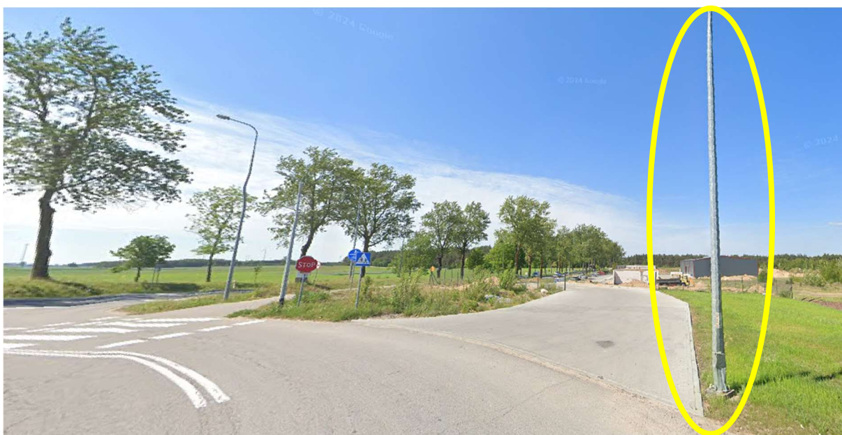
- słup oświetleniowy - km 240+530, str. P, lampa oświetleniowa nr 1/2/2
