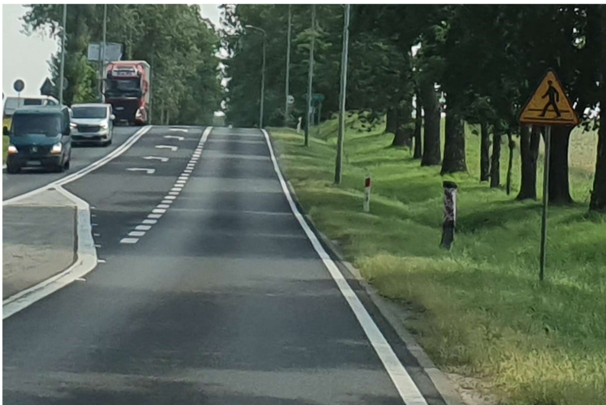
- słup oświetleniowy - km 240+430, str. L, droga podporządkowana do m. Zagórki, lampa oświetleniowa nr 1/3
