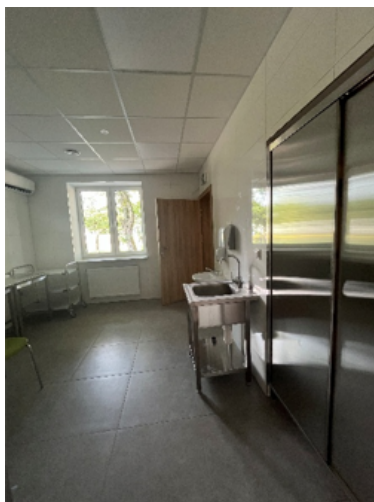
Zdjęcie nr 7 Gminny Żłobek w Chąśnie - Rozdzielnia
