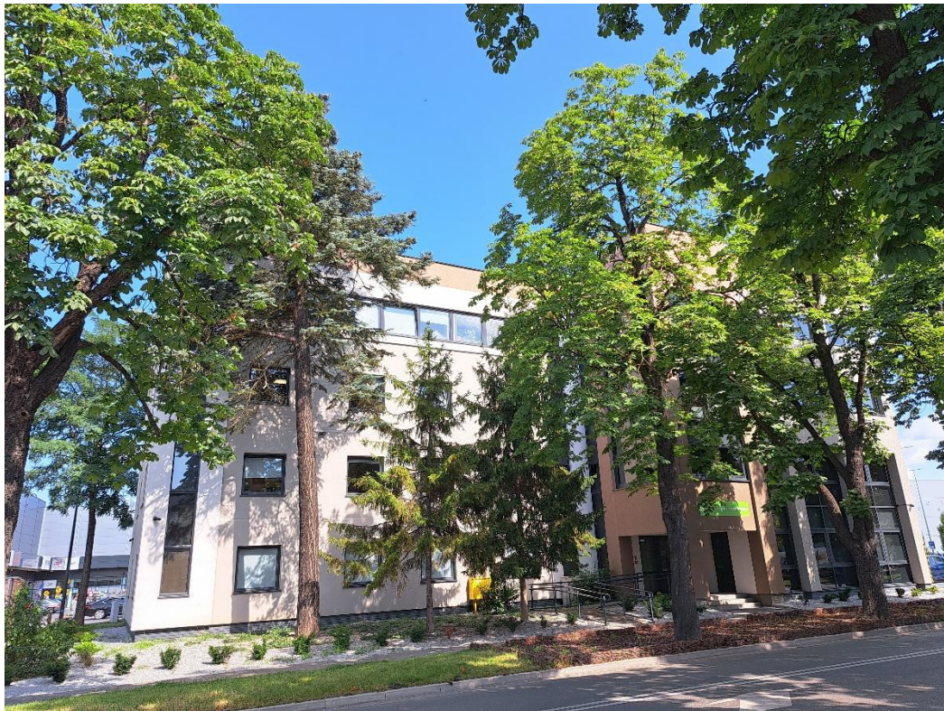
Zdj. 1. Przód budynku RDOŚ
