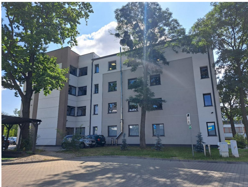
Zdj. 3. Tył budynku RDOŚ
