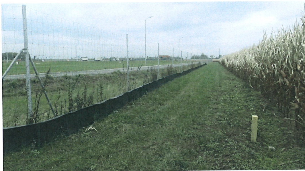
Fot. 1. S6 MOP Wyszogóra – kierunek Płoty, teren planowanej drogi dodatkowej
